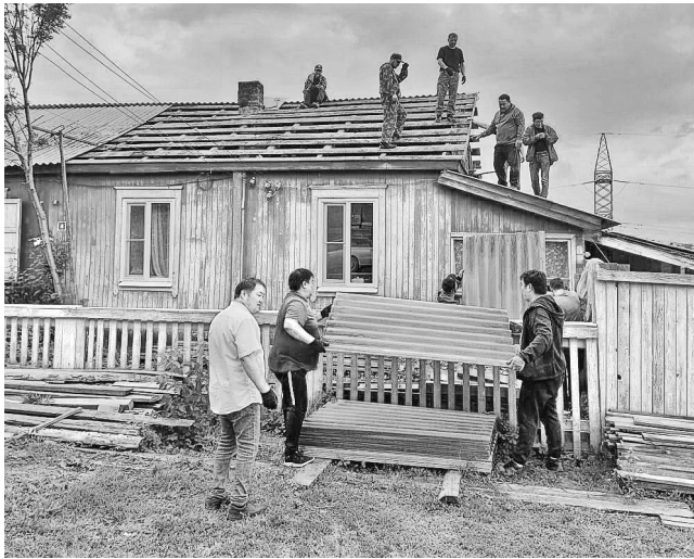
В Осинском районе многодетной семье отремонтировали дом в рамках адресной материальной помощи
