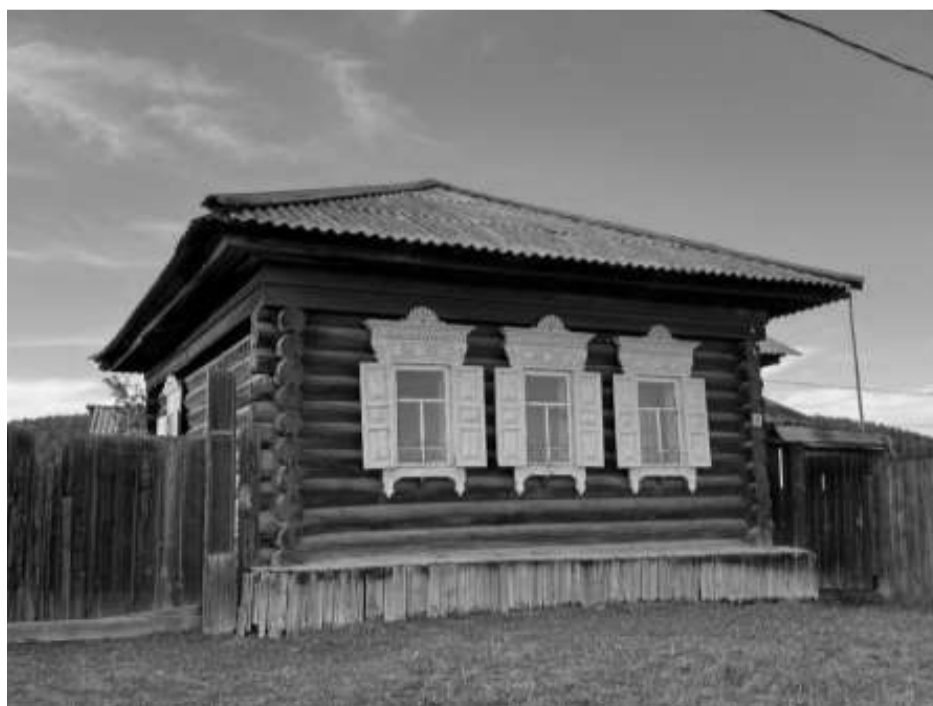
Фотография № 2. Вид с улицы М. Копыловой на западный и южный фасады объекта культурного наследия
