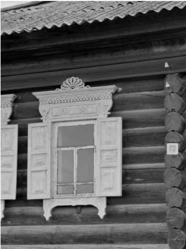
Фотография № 4. Фрагмент южного фасада объекта культурного наследия
