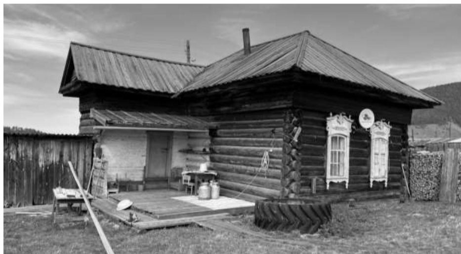
Фотография № 3. Вид на северо-западный и юго-западный фасады объекта культурного наследия
