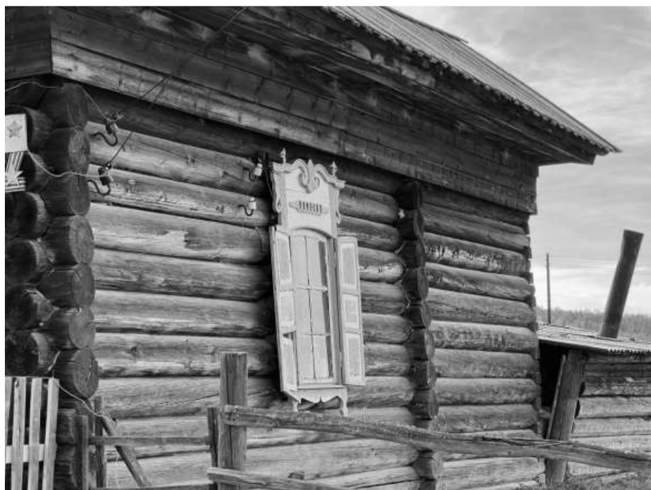
Фотография № 4. Фрагмент северо-восточного фасада объекта культурного наследия
