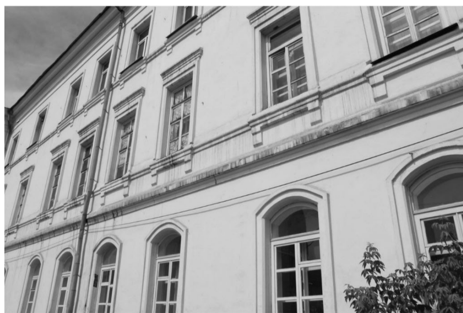
Фото 17. Фрагмент бокового юго-западного фасада.
