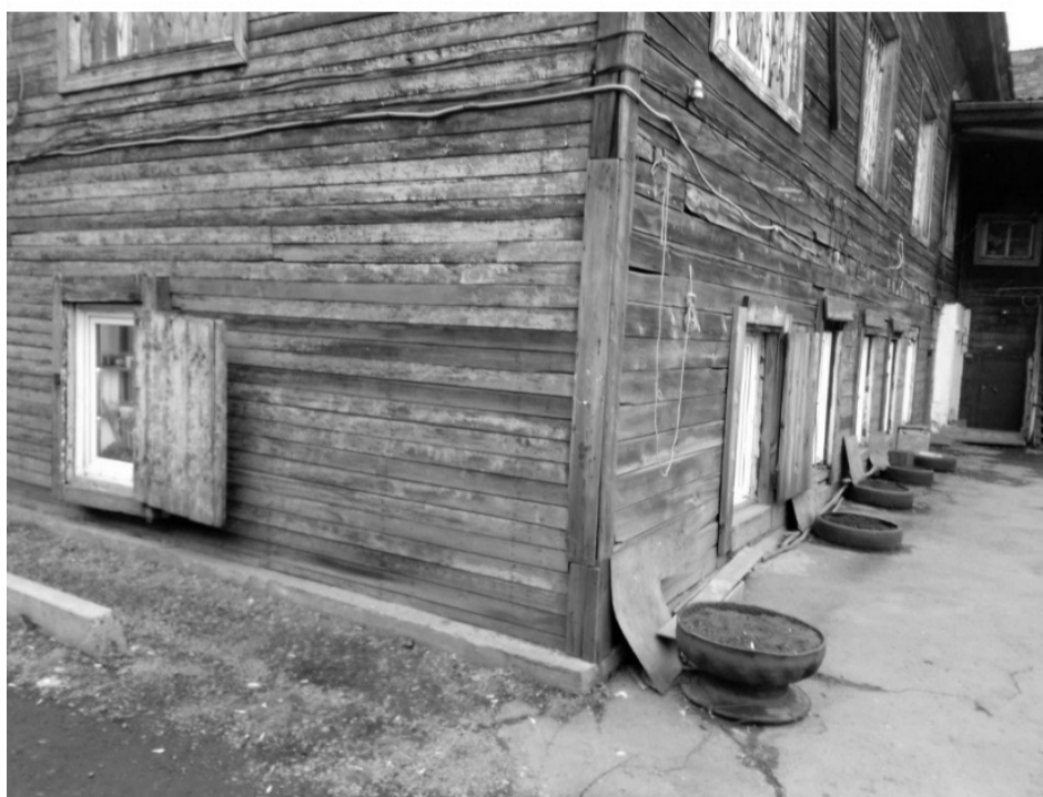
Фото 13. Северо-западный фасад дома под лит. а.
