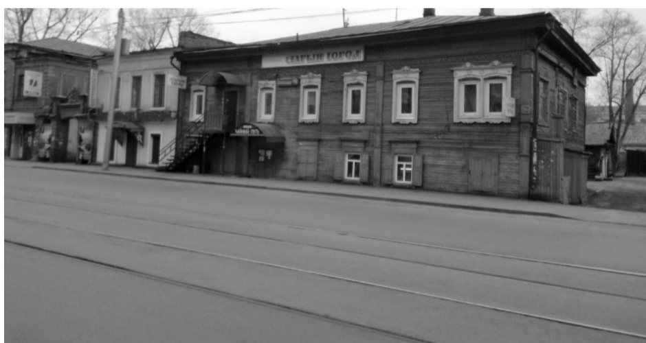
Фото 1. Главный фасад по улице Тимирязева дома под лит. а.
