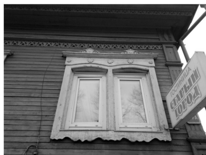
Фото 5. Фрагмент главного фасада по ул. Тимирязева дома под лит. а.
