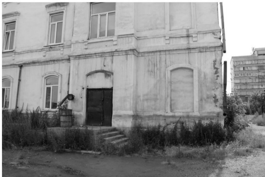
Фото 12. Фрагмент бокового северо-восточного фасада.
