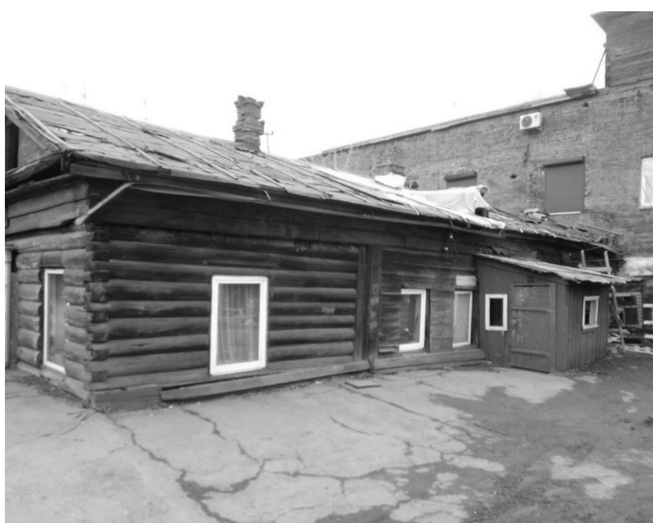
Фото 16. Северо-западный фасад дома под лит. б.
