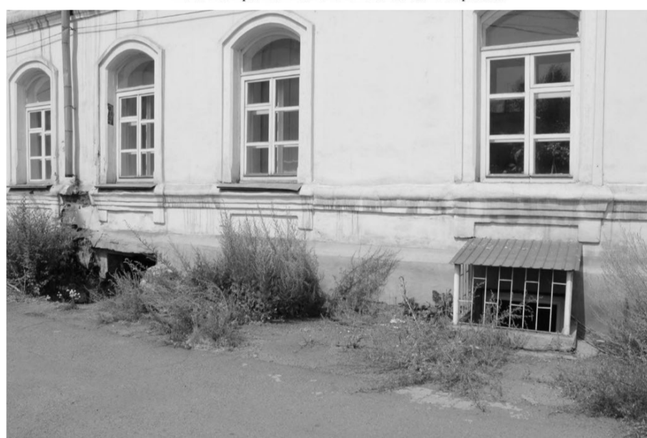
Фото 18. Фрагмент бокового юго-западного фасада.
