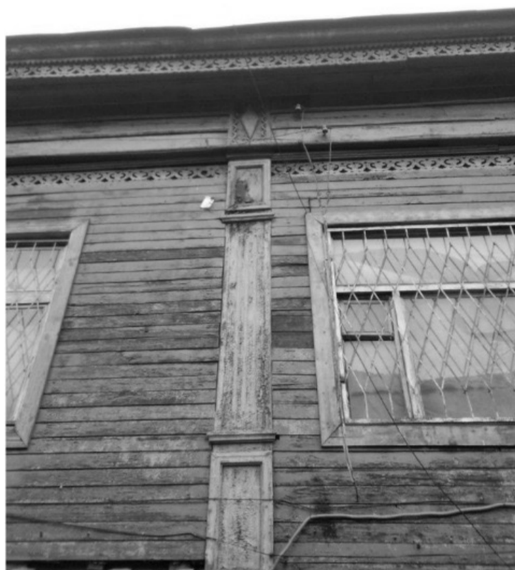
Фото 11. Фрагмент северо-восточного фасада дома под лит. а.
