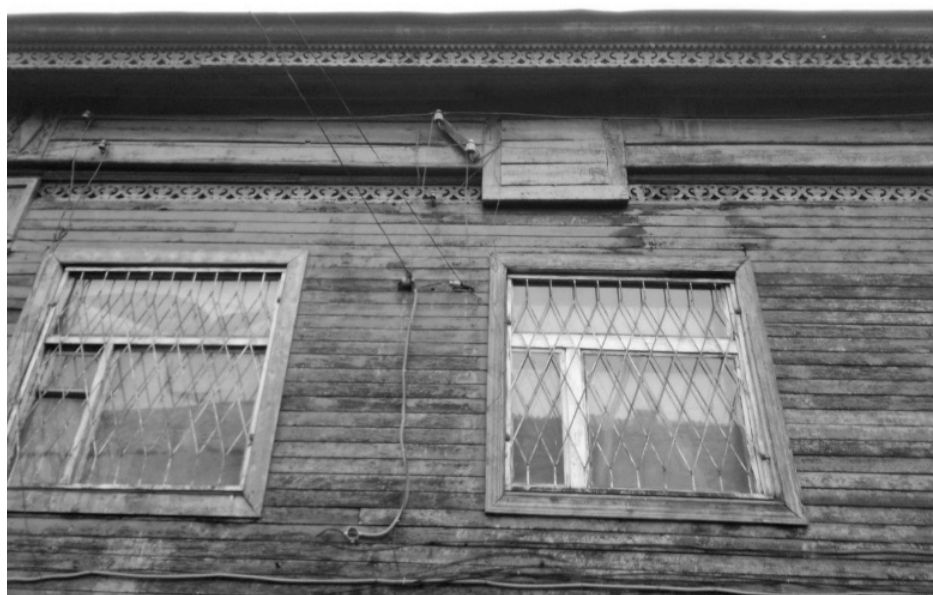
Фото 10. Фрагмент северо-восточного фасада дома под лит. а.
