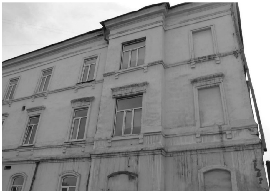
Фото 13. Фрагмент бокового северо-восточного фасада.
