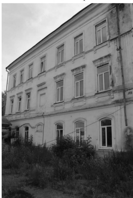
Фото 14. Фрагмент бокового северо-восточного фасада.
