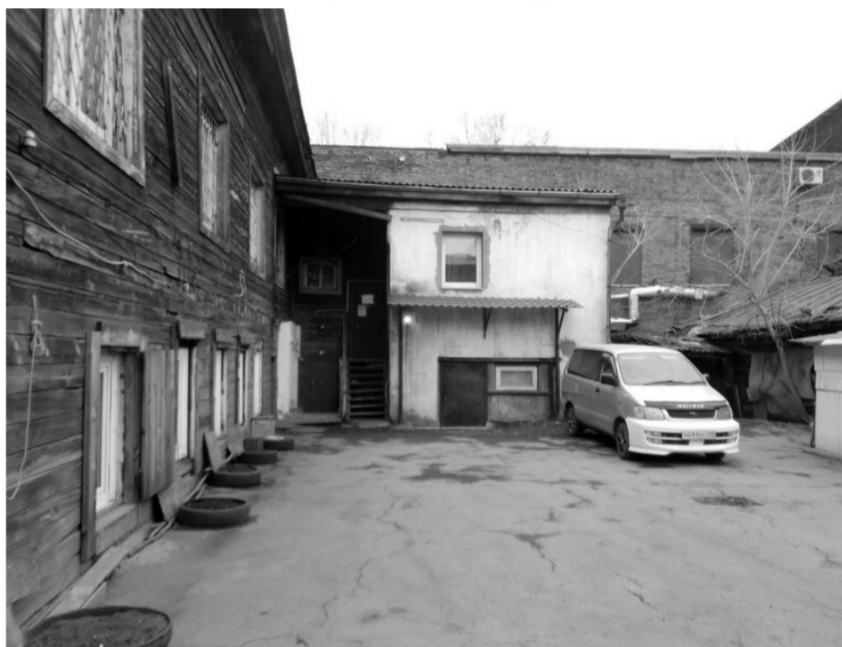
Фото 12. Северо-западный фасад дома под лит. а.
