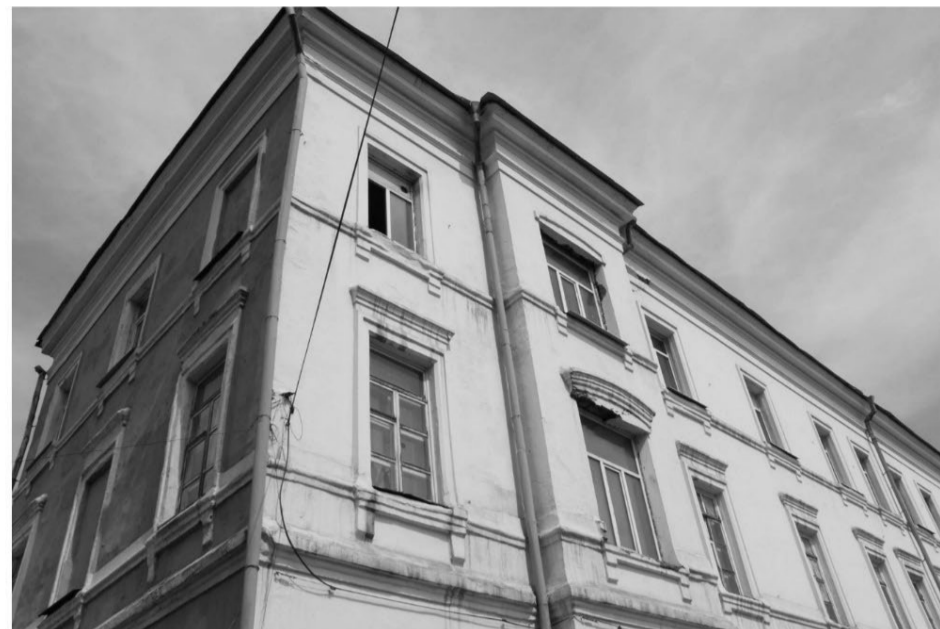
Фото 16. Фрагмент бокового юго-западного фасада.
