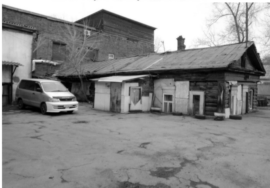
Фото 17. Юго-восточный фасад дома под лит. б.
