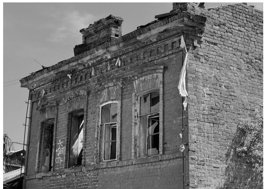
Фотография № 3. Вид с улицы Подгорной на фрагмент фасада объекта культурного наследия «Дом жилой, двухэтажный, каменный», кон. XIX - нач. XX вв., расположенного по адресу: Иркутская область, г. Иркутск, ул. Грязнова ул., 34, лит. А, а, лит. Б, 6.
