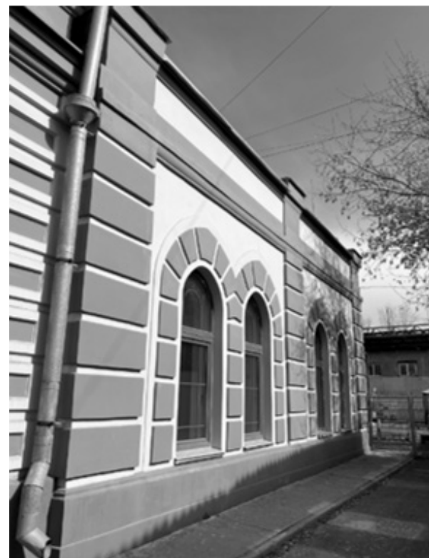
Фото 2. Фрагмент бокового (юго-восточного) фасада здания. Пристрой
