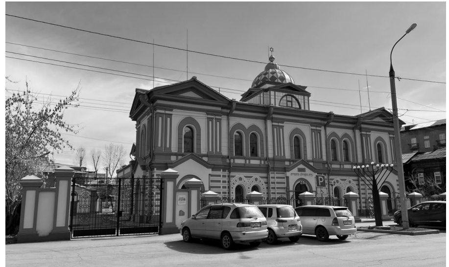
Фото 1. Вид на здание со стороны улицы Карла Либкнехта. Главный (юго-западный) фасад здания
