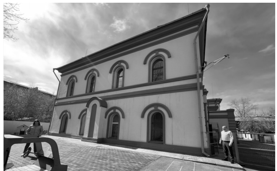
Фото 4. Северо-восточный фасад здания
