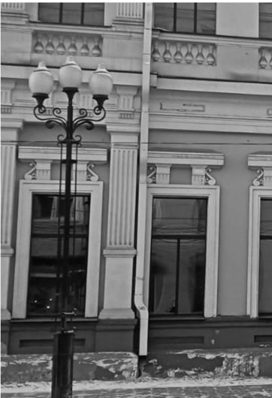
Фото 18. Фрагмент главного юго-восточного фасада. Межэтажный пояс. Окна и наличники 1 этажа. Пилястры 1 этажа.
