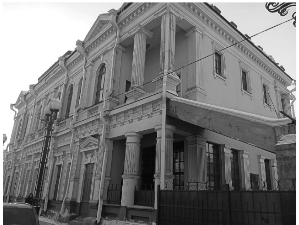
Фото 8. Восточный угол здания. Фото 2023 г.
