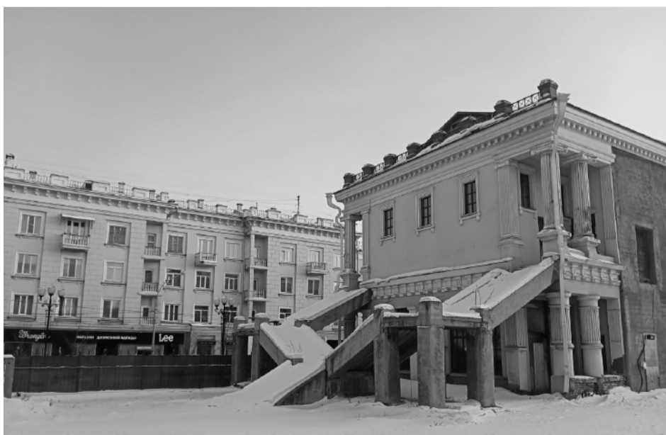
Фото 12. Северный угол здания. Пристрой с галереей и парадной лестницей. Фото 2023 г.
