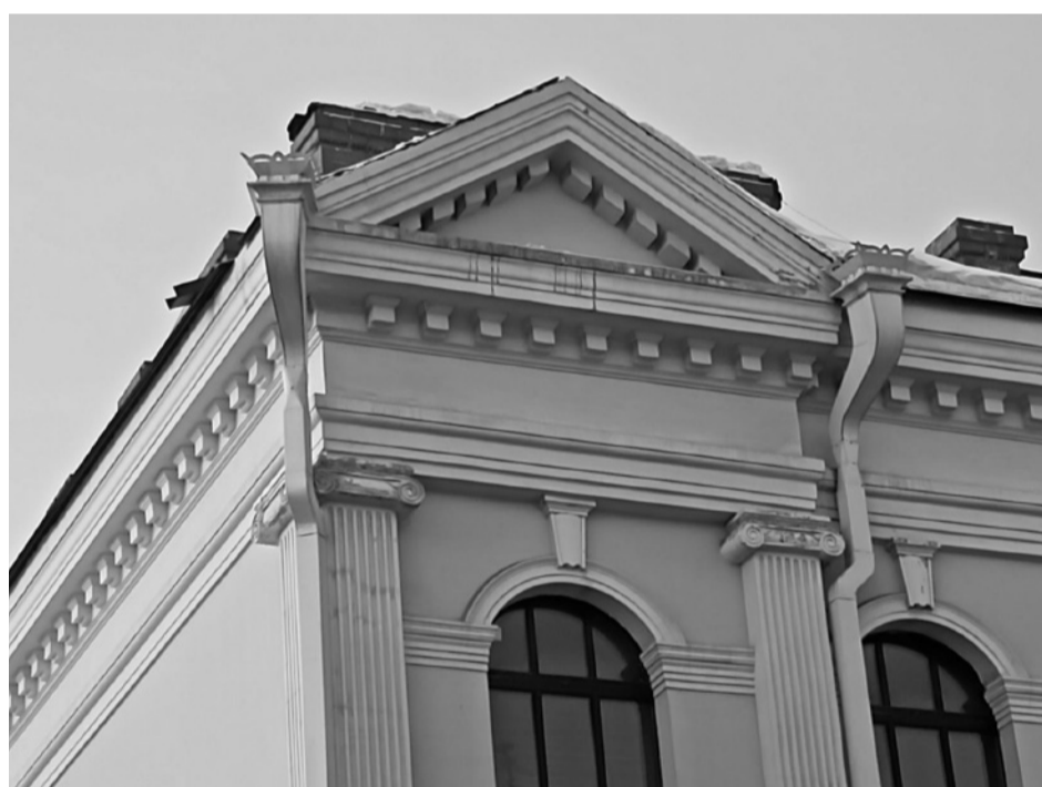
Фото 15. Фрагмент главного юго-восточного фасада. Вернувшийся антаблемент. Фронтон разлита. Аттиковые стенки. Фото 2023 г.
