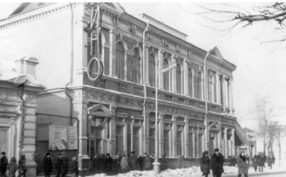
Фото 3. Общий вид здания с юга. Фото 1960-х (?) гг.
