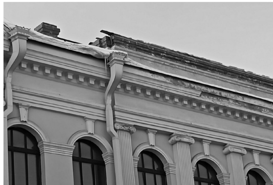
Фото 16. Фрагмент главного юго-восточного фасада. Вернувшийся антаблемент. Аттиковые стенки. Фото 2023 г.
