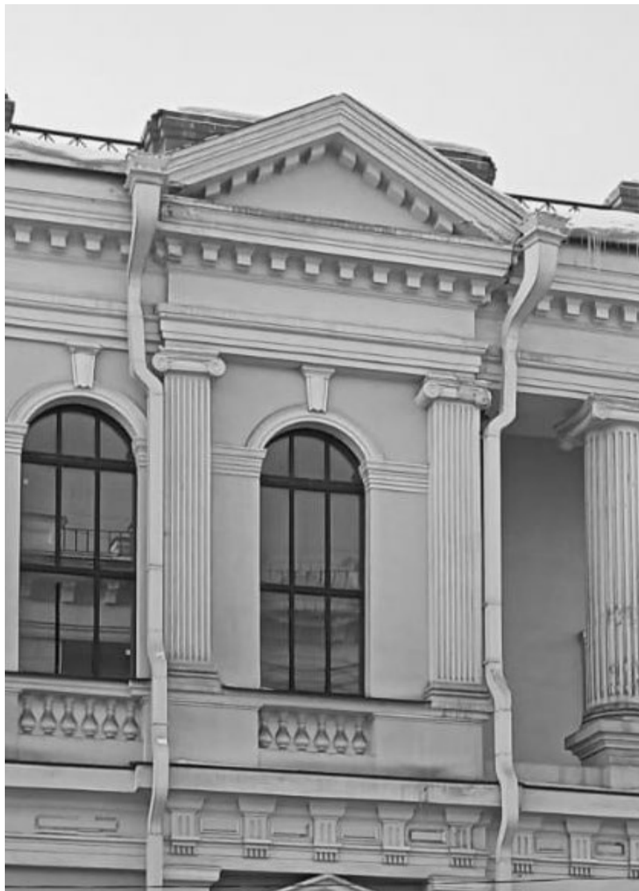
Фото 17. Фрагмент главного юго-восточного фасада. Вернувшийся антаблемент. Аттиковые стенки. Фронтон ризалита. Окна 2 этажа. Пилястры 2 этажа. Межэтажный пояс. Фото 2023 г.
