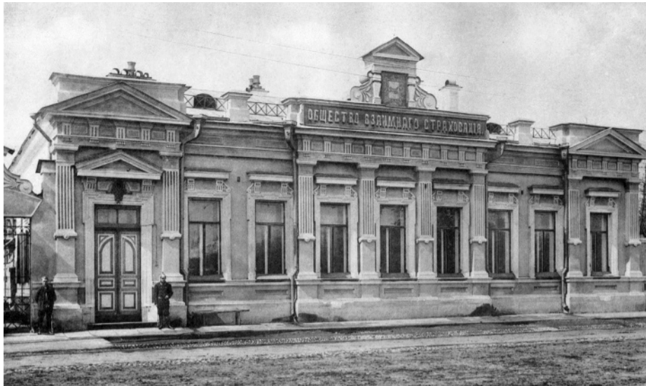
Фото 1. Юго-восточный фасад до реконструкции 1930-х гг. Вид с ул. Карла Маркса. Кон. XIX – нач. XX вв.
