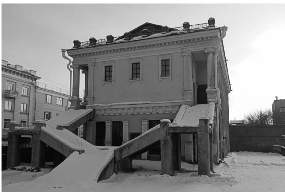
Фото 11. Северо-восточный фасад. Фото 2023 г.
