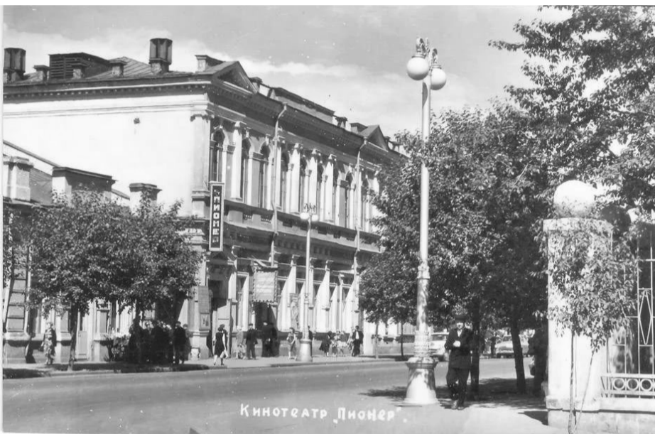
Фото 2. Общий вид здания с юга. Фото 1950 – 1960-х гг.
