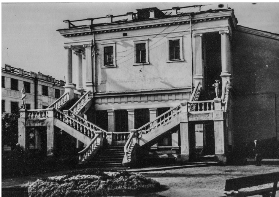
Фото 9. Северо-восточный фасад. Фото 1950 – 1960-х гг.
