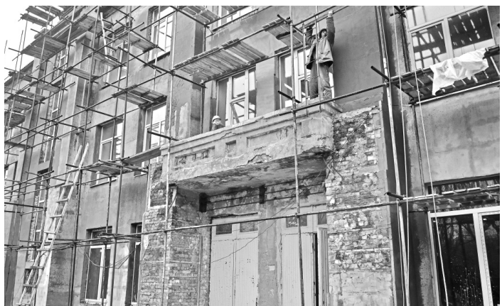
Капитальный ремонт школы № 1 Кировска
