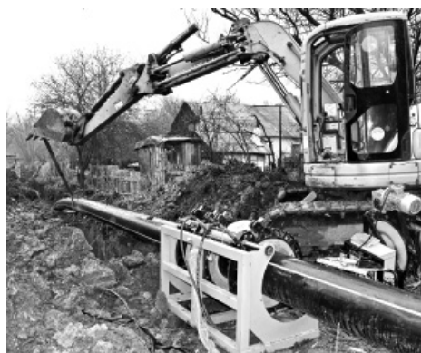
Работы по ремонту водоснабжения
