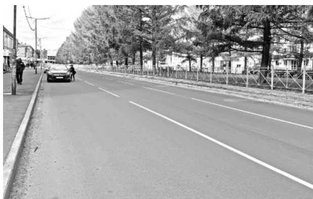
Автомобильная дорога по ул. Социалистической (ремонт от Энгельса до Коминтерна)
