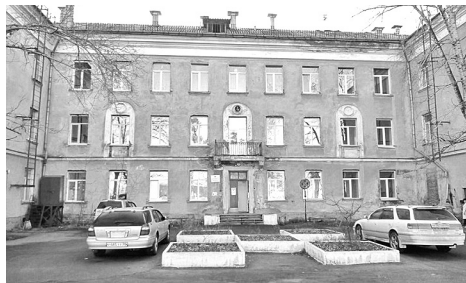
Здание старой инфекционной больницы реконструкции не подлежит
