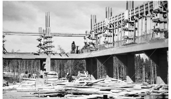
Строительство остается проблемной отраслью по безопасности труда
