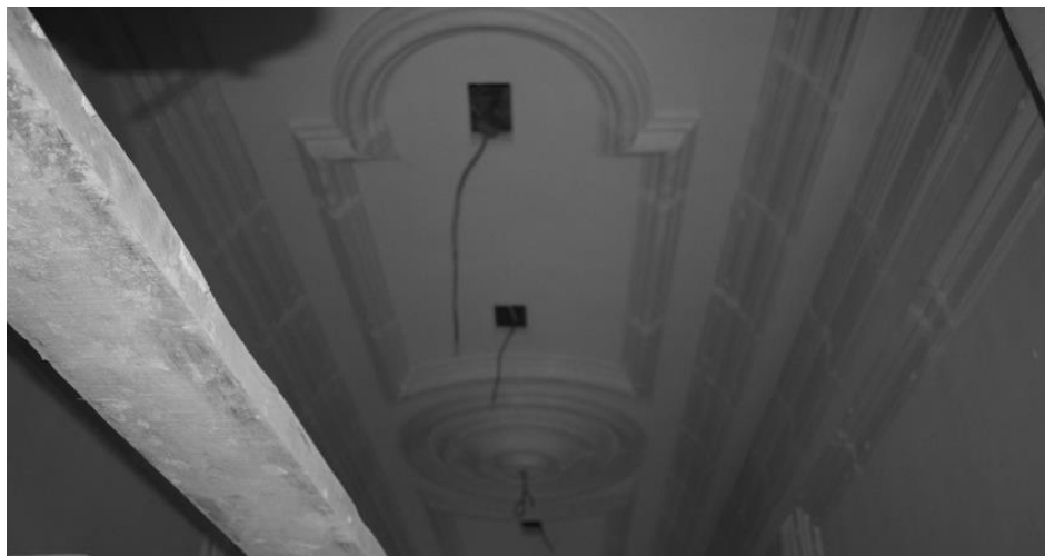
Фрагмент помещения парадных лестниц, расположенных в блоке бывш.доходного дома. Потолок. Ремонтные работы.
