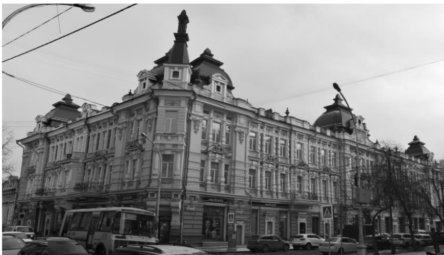
Общий вид на здание со стороны улиц (с запада).
