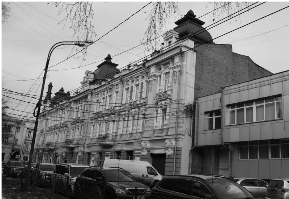
Вид на юго-западный фасад здания со стороны улицы Литвинова.
