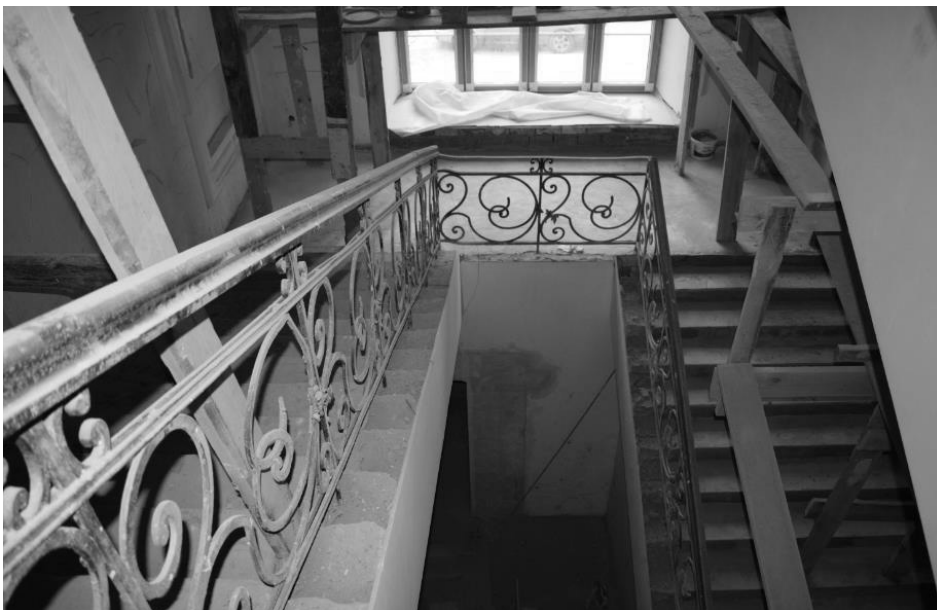
Фрагмент парадной лестницы, расположенной в блоке бывш.доходного дома. Вход на нее организован со стороны улицы К.Маркса. Ремонтные работы.
