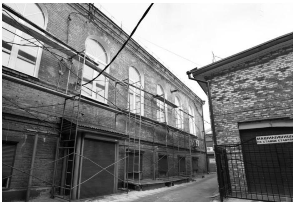
Вид на юго-восточный фасад здания в части блока бывш.флигеля (слева).
