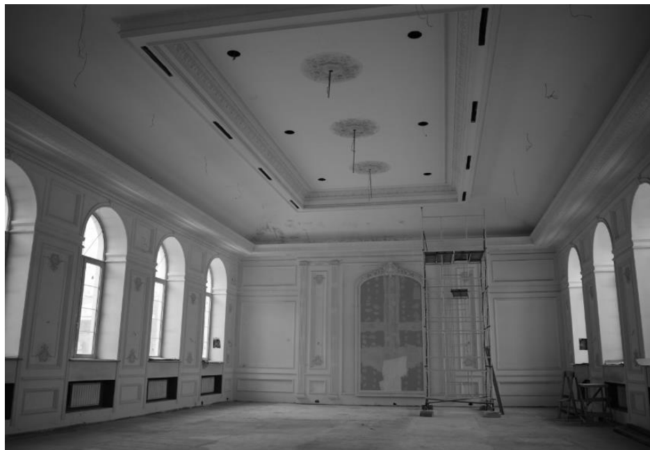
Интерьер в части блока бывш. флигеля в уровне второго этажа. Ремонтные работы.
