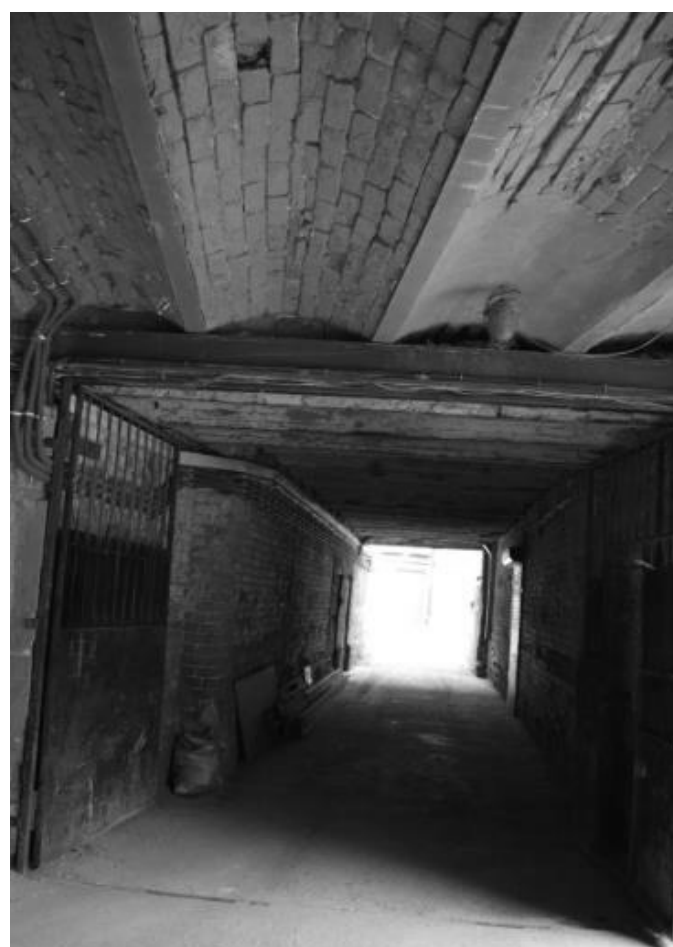
Пространство под блоком галереи-перехода.
