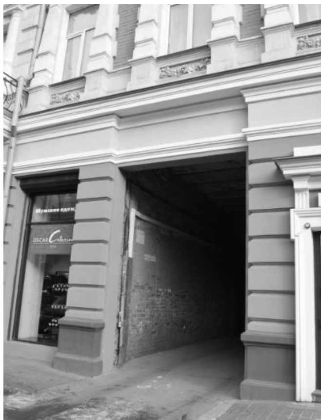
Фрагмент юго-западного фасада здания со стороны ул. Литвинова. Первый этаж. Въезд во двор через сквозной арочный проезд.
