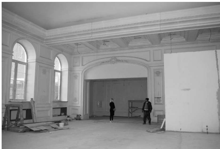
Интерьер в части блока бывш. флигеля в уровне второго этажа. Ремонтные работы.
