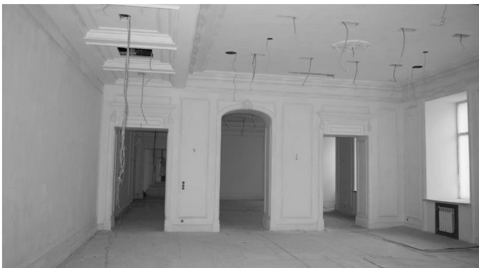
Интерьер в части блока бывш. доходного дома в уровне второго этажа. Ремонтные работы.
