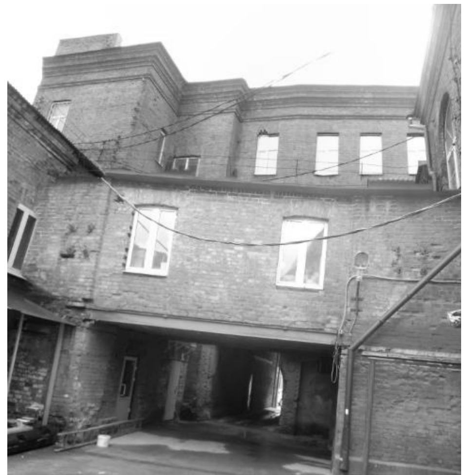
Фрагмент дворового северо-восточного фасада здания. На заднем плане расположен фрагмент протяженного корпуса по ул. Литвинова бывш. доходного дома с арочным проездом, на переднем плане - блок галереи-перехода между двухэтажным блоком бывш. хозяйственной постройки (слева) и блоком бывш. флигеля (справа).
