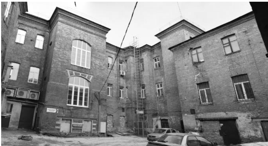
Вид на фрагменты дворовых (северо-восточного и юго-западного) фасадов здания в части блока бывш.доходного дома.
