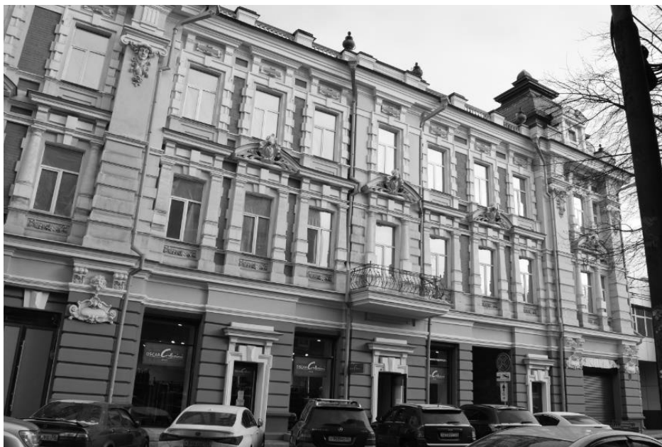
Фрагмент юго-западного фасада здания со стороны ул.Литвинова.
