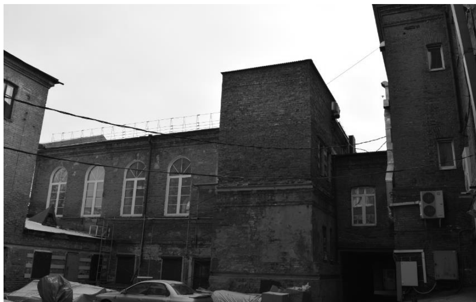
Вид на северо-западный фасад здания в части блока бывш.флигеля (слева), блока галереи-перехода (справа).
