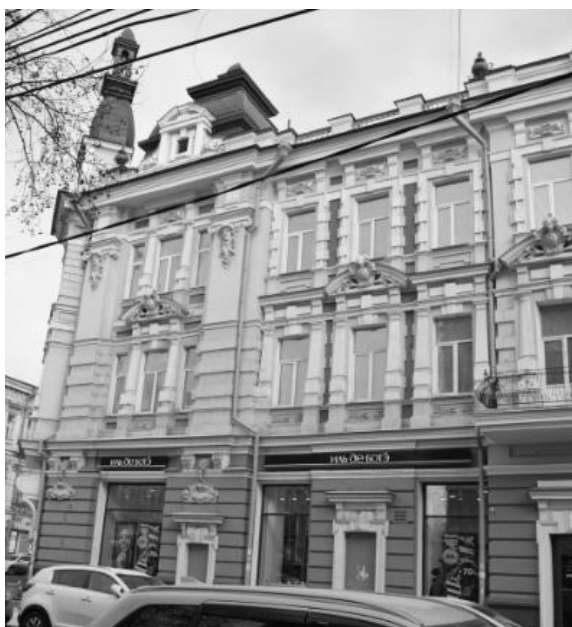
Фрагмент юго-западного фасада здания со стороны ул. Литвинова.
