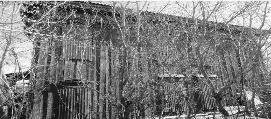
Жилой дом (лит Л). Боковой(северо-западный) фасад.
