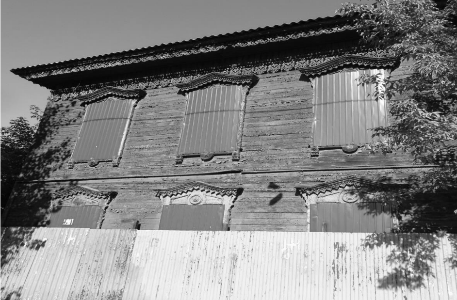
Главный лицевой (юго - западный) фасад дома.
