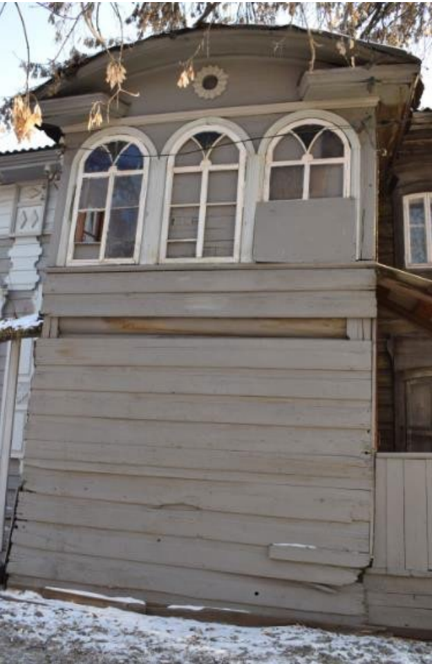
Фрагмент бокового (северо-западного) фасада здания. Прируб со светёлкой во втором ярусе.
