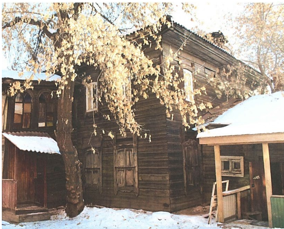
Снимок 7: Общий вид здания с западного угла. Автор снимка: арх. Н.В. Шастун Дата съемки: 03.04.2017г.
