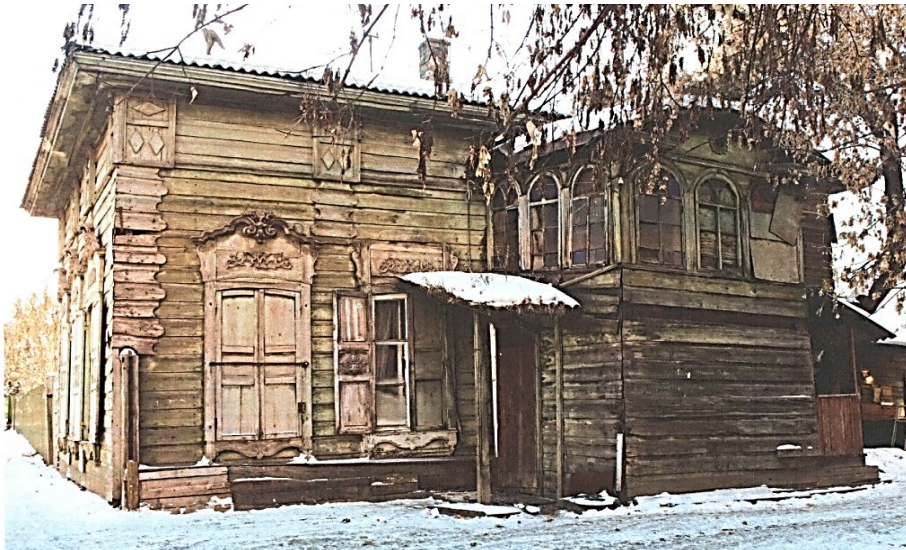
Снимок 2: Северо-западный фасад. Автор снимка: арх. Н.В. Шастун Дата съемки: 03.04.2017г.
