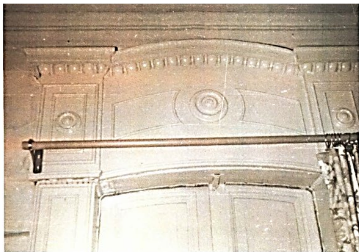
Снимок 15, 16: Фрагмент интерьера. Оформление дверного проема парадных комнат. Автор снимка: арх. Е.Ю.Барановский Дата съемки: 1979г.
