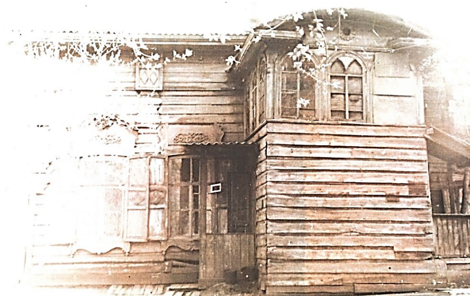
Снимок 10: Северо-западный фасад Автор снимка: арх. А.Е. Ширко Дата съемки: 1984г.
