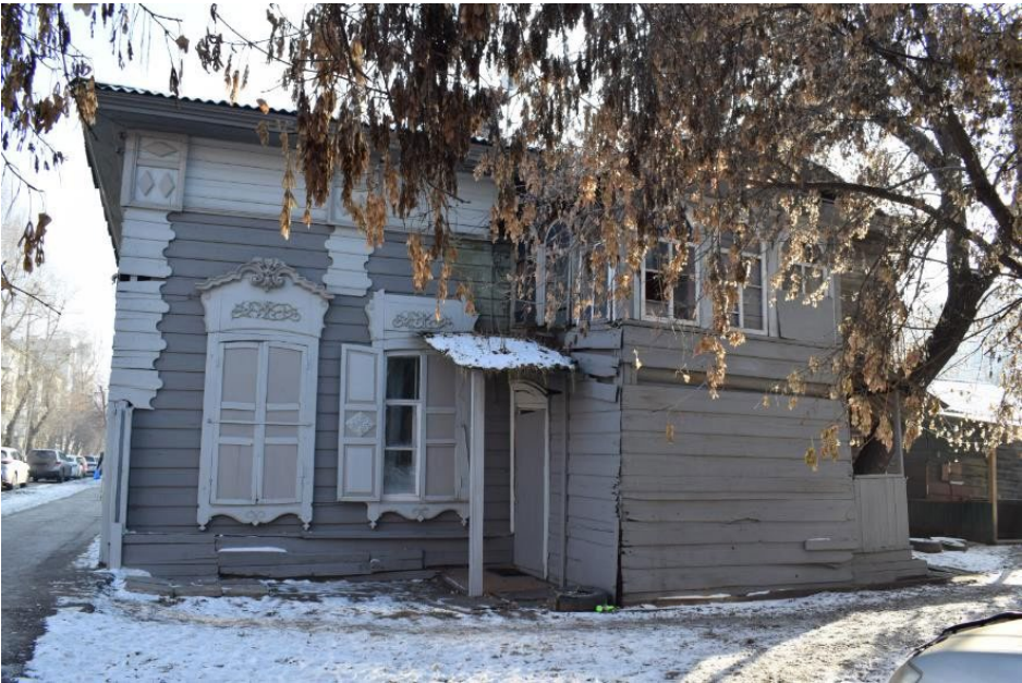
Фрагмент бокового (северо-западного) фасада здания.
