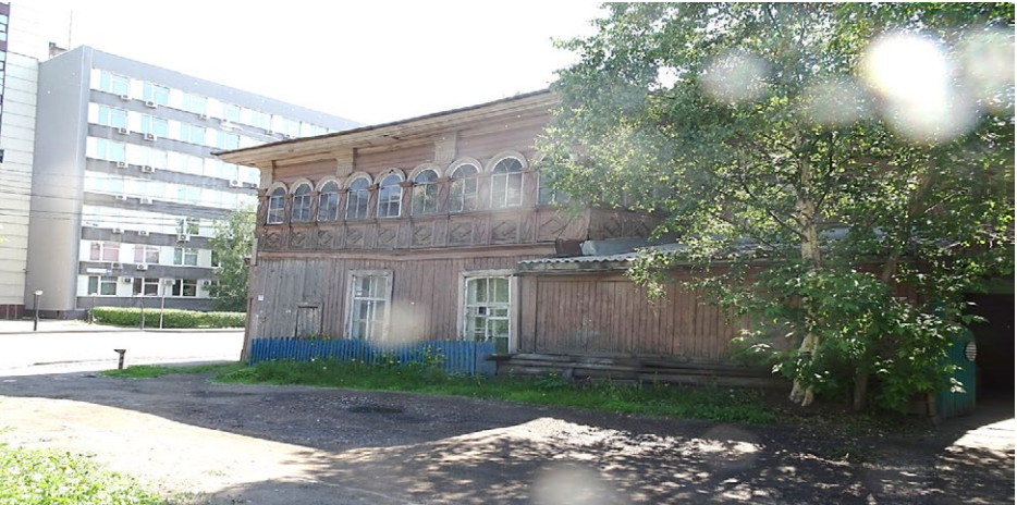
Фрагмент бокового (северо-западного) фасада.
