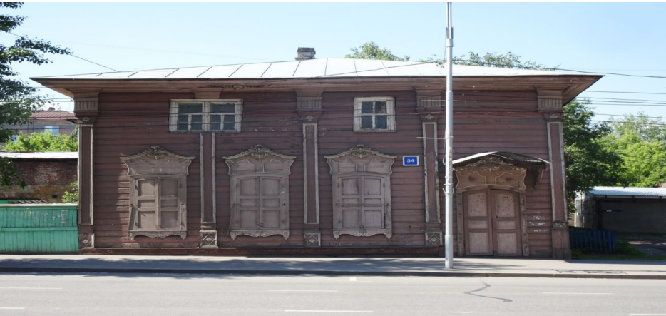
Главный (северо-восточный) фасад здания. Вид с ул. Декабрьских событий.
