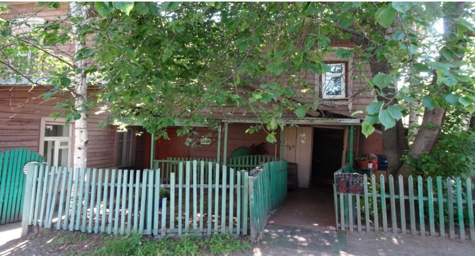
Фрагмент бокового (северо-западного) фасада
