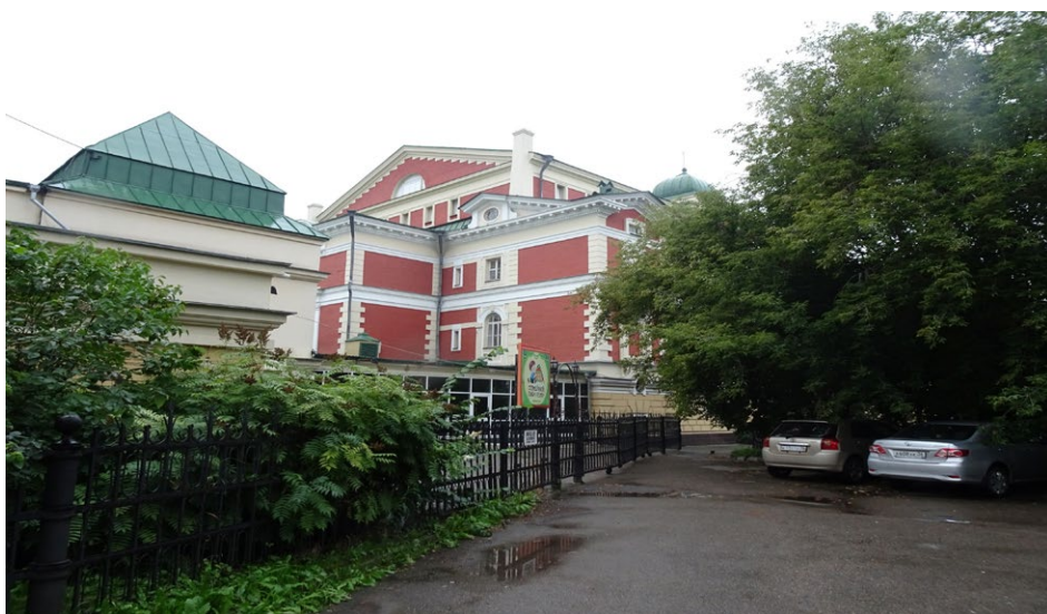
Задний (юго-восточный) фасад. Сценическая часть.
