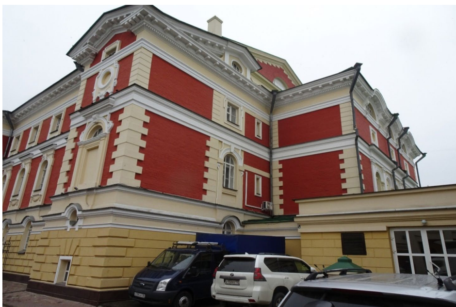
Задний (юго-восточный) фасад. Сценическая часть.
