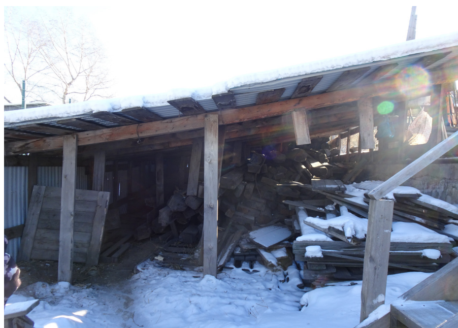
Складированные под навесом элементы памятника.
