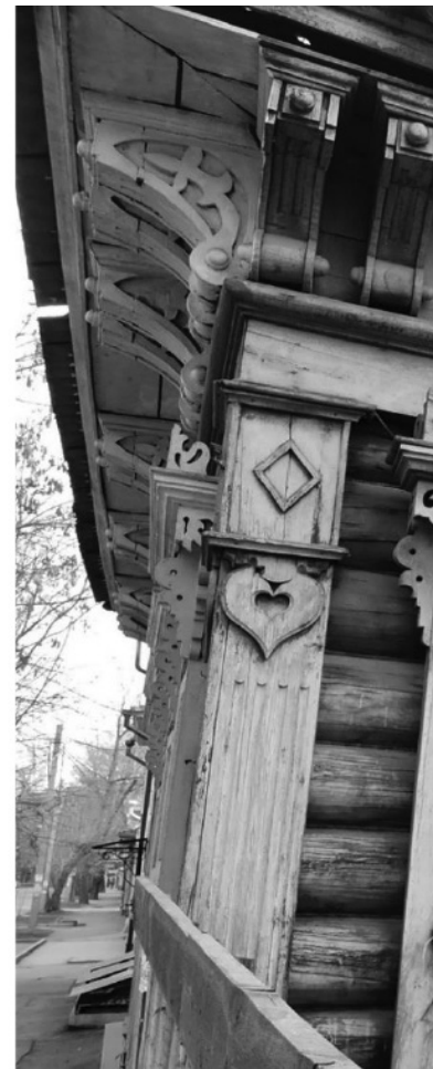
19. Лопатка на северо-западном фасаде здания. Фото 2020 г.
