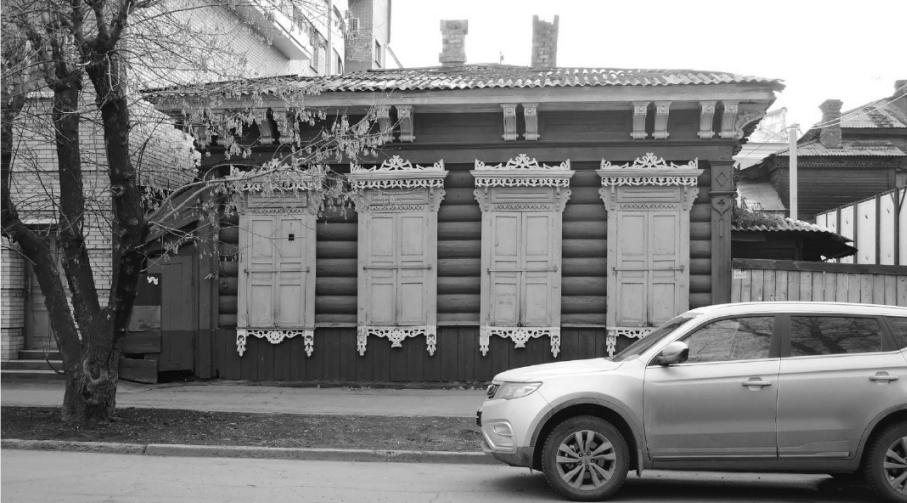
1. Главный северо-восточный фасад здания. Фото 2020 г.
