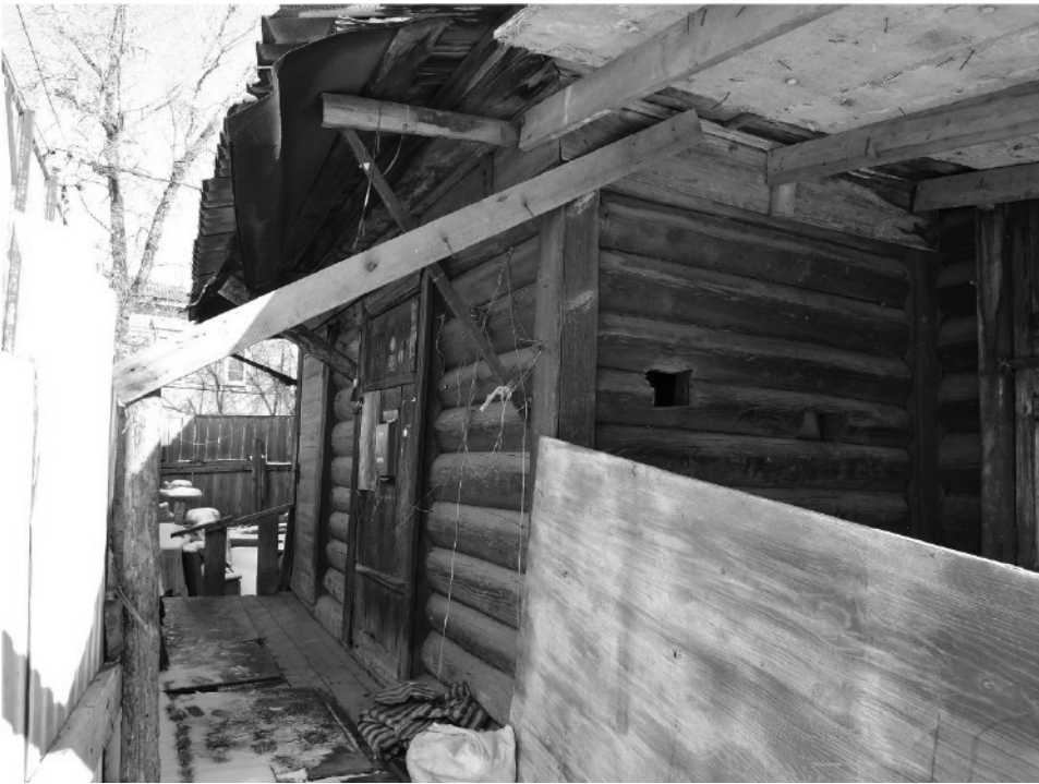
7. Фрагмент северо-западного фасада. Дворовой прируб. Фото 2020 г.
