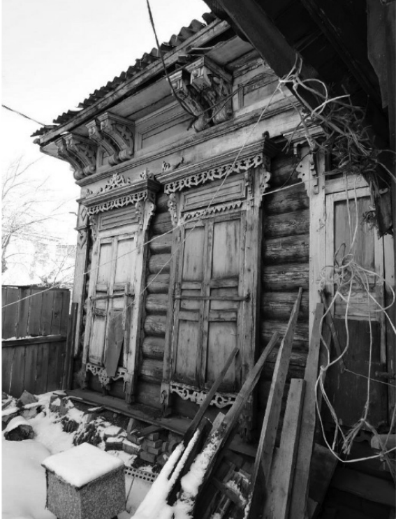
6. Фрагмент северо-западного фасада. Фото 2020 г.
