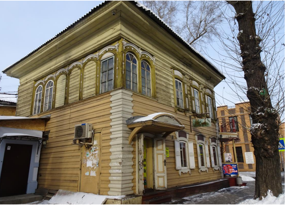
Общий вид здания с южного угла (ул. Дзержинского).
