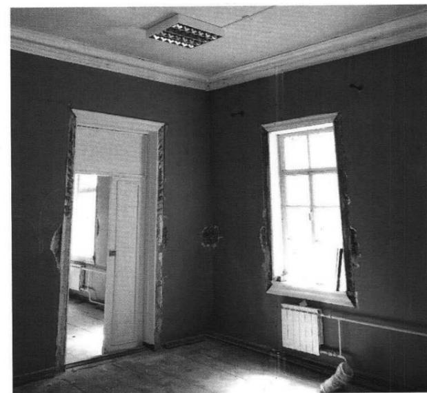
41. Фрагмент деревянных потолочных тяг и профилированного наличника дверного проема в пом. №9, второй этаж
