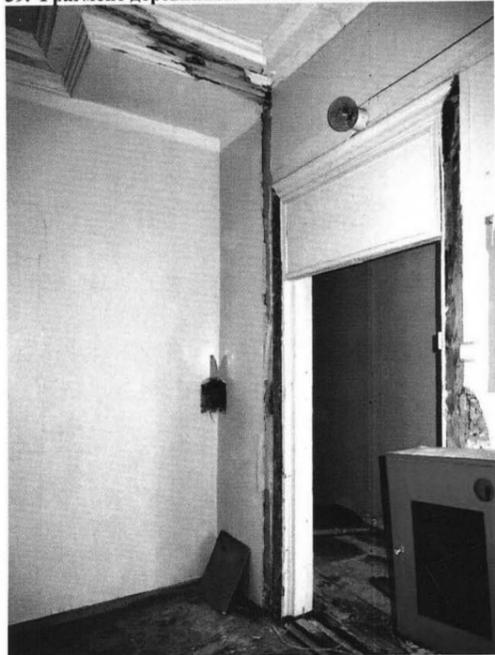
40. Фрагмент деревянных потолочных тяг и профилированного наличника дверного проема в пом. № 1, второй этаж
