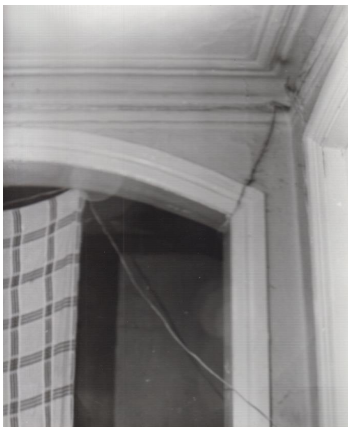
Фото 9 - Фрагмент интерьера жилого дома (лит. А). Потолочные тяги, профилированные дверные наличники. Архив ЦСН
