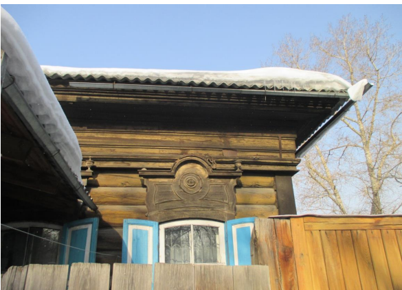
Фото 15 - Фрагмент главного (юго-восточного) фасада жилого дома (лит. А). Фриз, карниз
