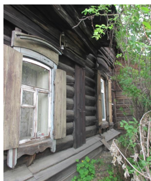
Фото 21, 22 - Фрагменты бокового (юго-восточного) фасада пониженного жилого прируба. Наличники окон
