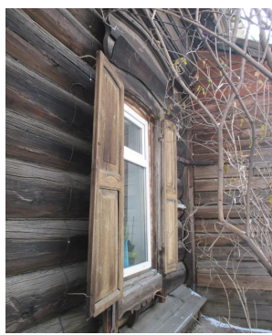
Фото 23, 24 - Фрагменты бокового (юго-восточного) фасада жилого дома (лит. А). Наличник окна, фриз, карниз
