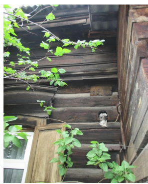
Фото 23, 24 - Фрагменты бокового (юго-восточного) фасада жилого дома (лит. А). Наличник окна, фриз, карниз
