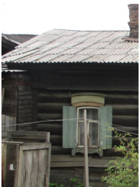
Фото 35 - Фрагмент бокового (северо-восточного) фасада пониженного жилого прируба. Наличник окна, фриз, карниз, заваulinка
