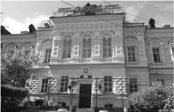
Фото 3 - Центральный ризалит главного северо-восточного фасада
