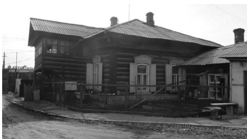
Фото 7 - Вид на здание лит. А с востока. Юго-восточный, северо-восточный фасады дома
