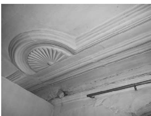
Фото 27 - Потолочные тяги и розетки в пом. №8
