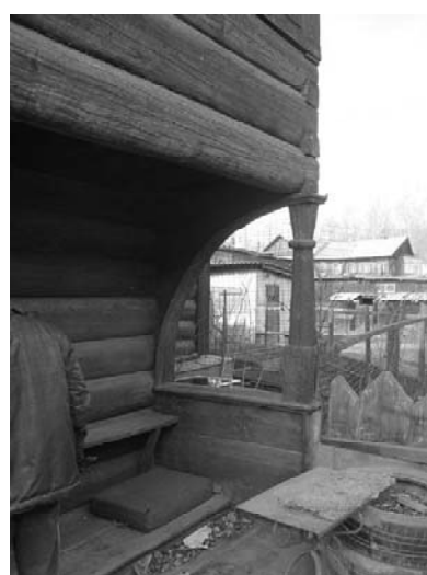
Фото 17 - Крыльцо. Выкружные консоли, деревянные столбики
