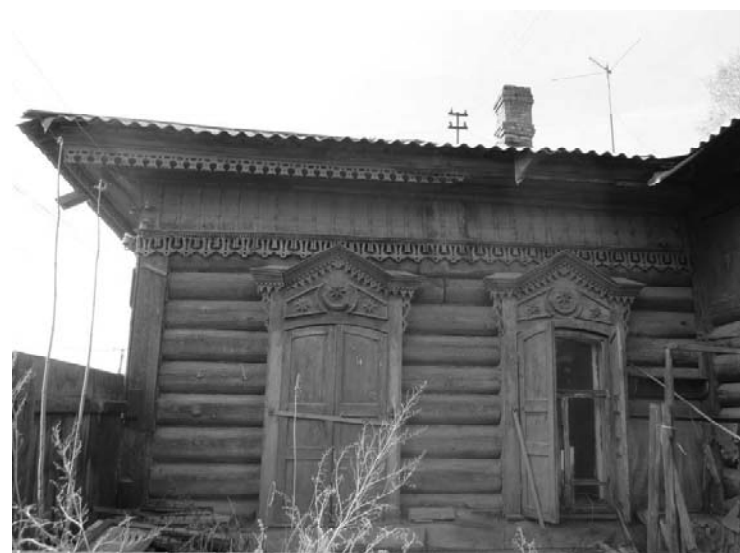
Фото 15 - Фрагмент юго-восточного фасада. Наличники оконных проемов.
