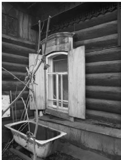
Фото 19 - Фрагмент юго-восточного фасада лит. А. Наличник оконного проема
