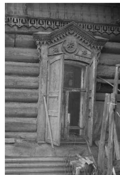
Фото 14 - Фрагмент юго-восточного фасада. Наличник оконного проема
