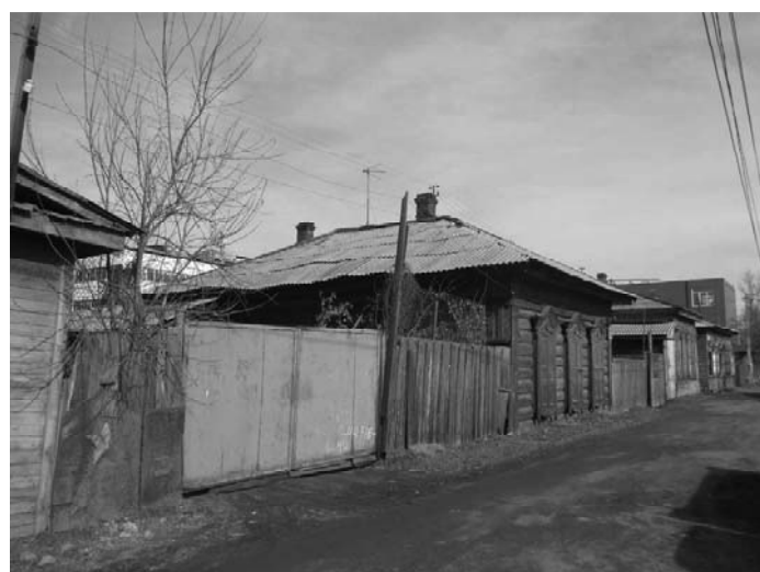
Фото 11 - Вид на дом лит. А с северо-запада
