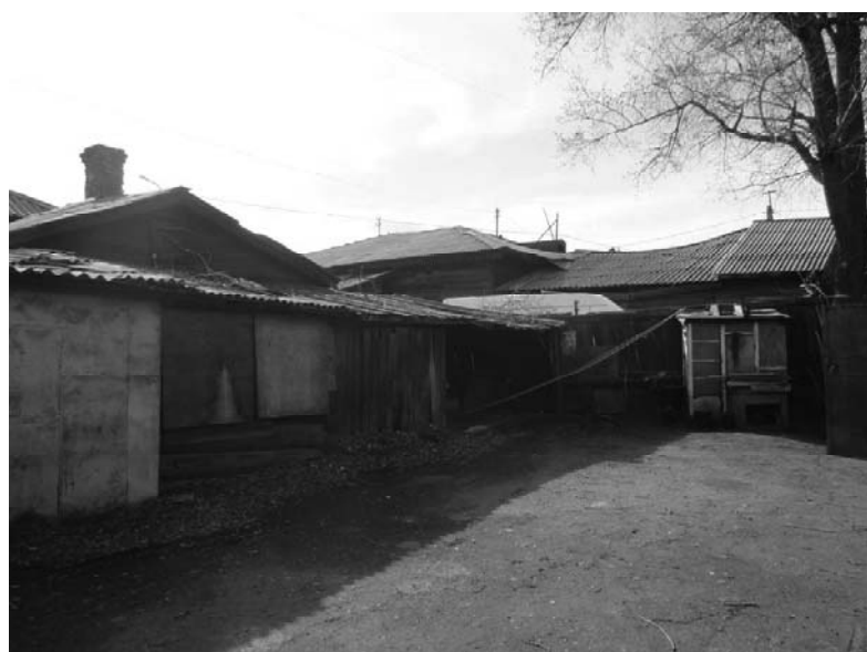
Фото 10 - Северо-восточный дворовой фасад. Поздние пристрой
