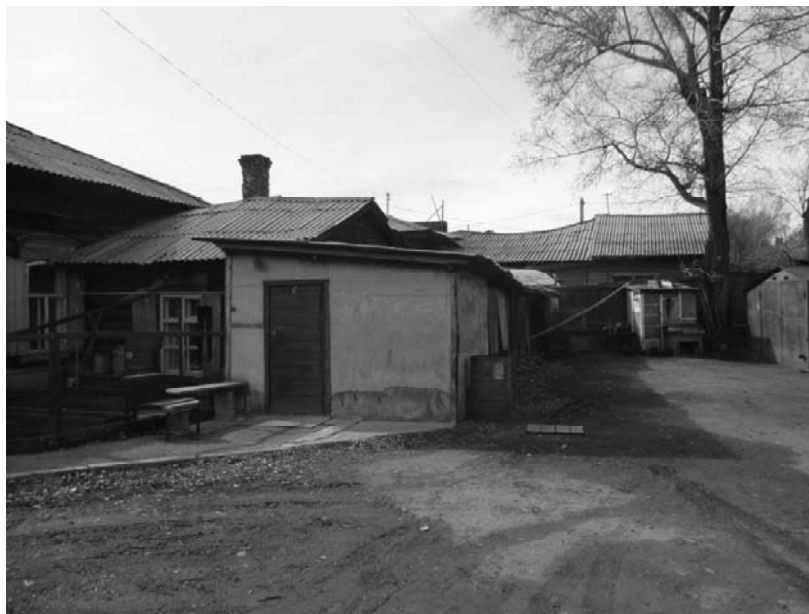
Фото 8 - Боковой (юго-восточный) фасад дома, поздние пристрой к северо-восточному фасаду
