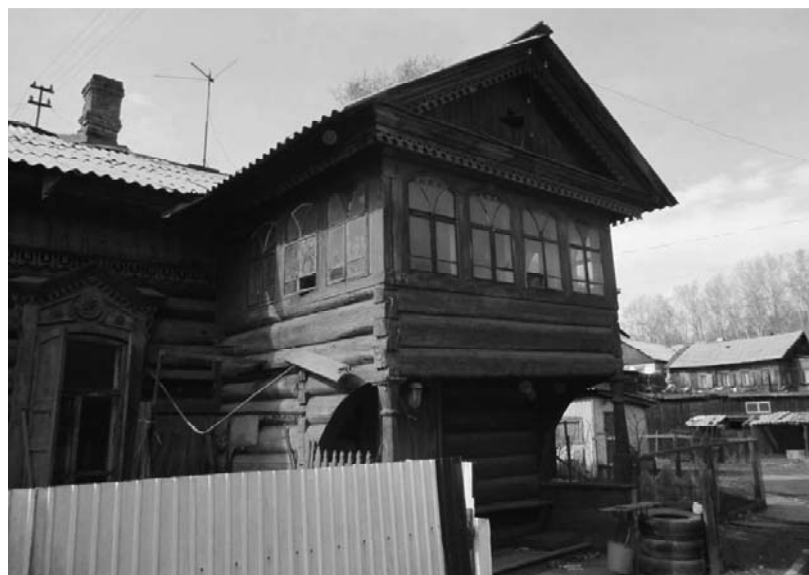
Фото 5 - Фрагмент бокового (юго-восточного) фасада. Входной двухэтажный прируб лит. А1
