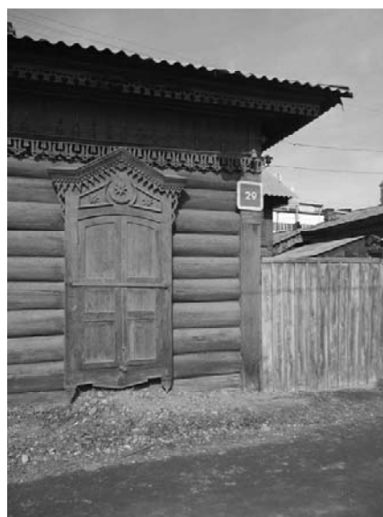
Фото 13 - Фрагмент главного фасада. Наличник оконного проема, лопатка, фриз, карниз
