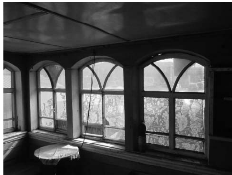
Фото 30 - Оконные проемы галереи 2 этажа. Вид изнутри
