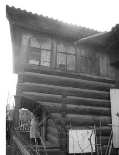
Фото 18 - Пристрой лит. А4, вид с северо-востока
