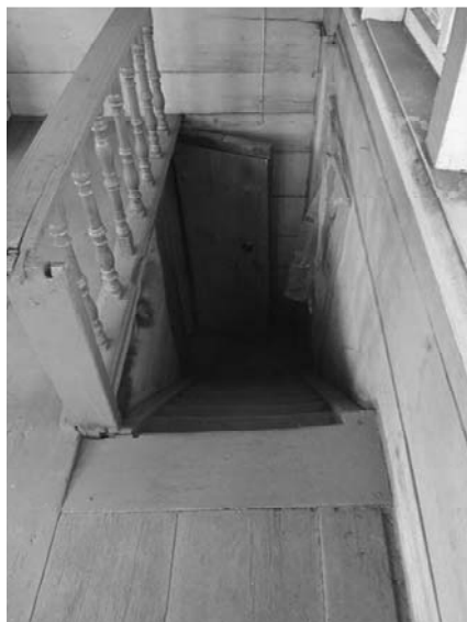
Фото 28 - Лестница в помещ. пристрой лит. А4
