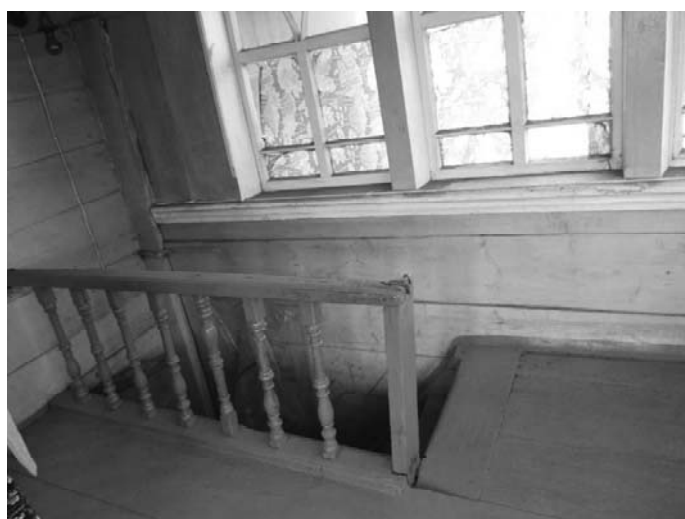
Фото 29 - Ограждение лестничной площадки.
