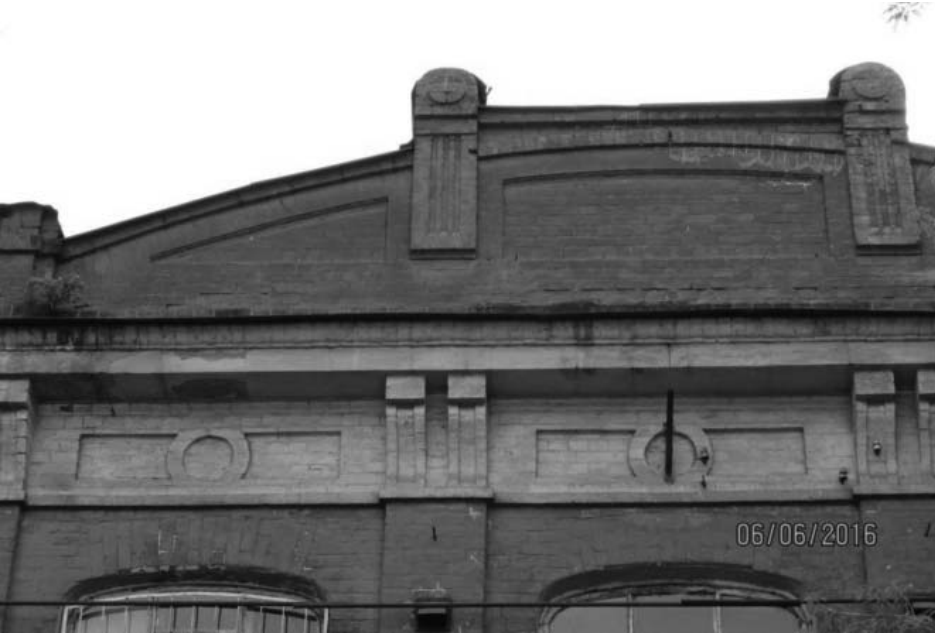
Фото 5 - Аттиковая стенка на главном фасаде
