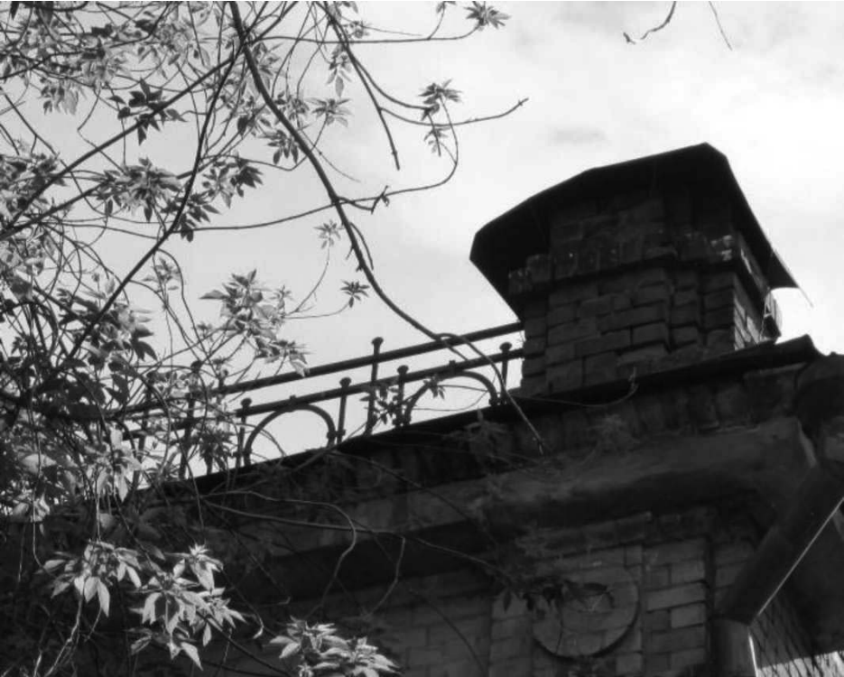
Фото 6 - Ограждение кровли. Главный фасад
