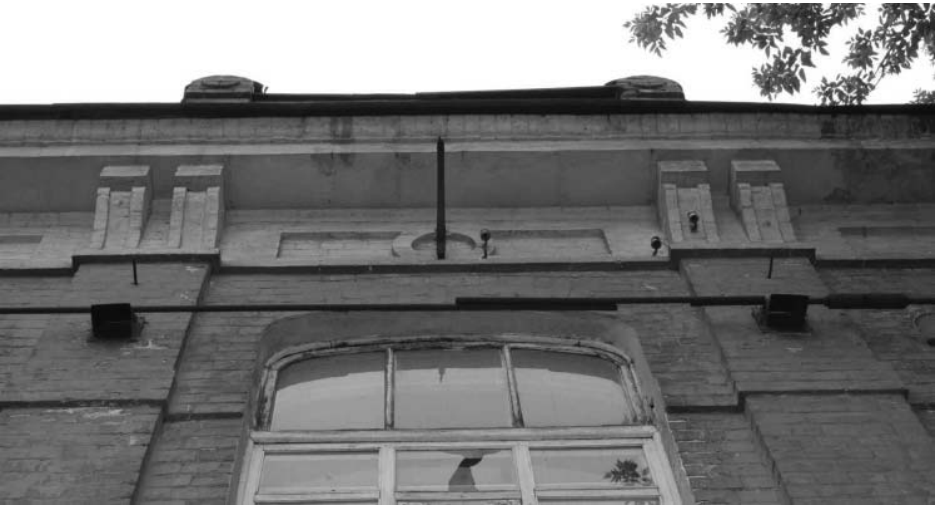
Фото 3 - Фриз и карниз на главном фасаде
