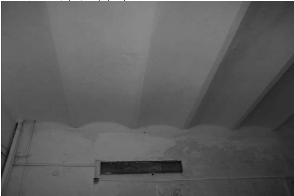
Фото 15 - Фрагмент интерьера. Сводчатые перекрытия
