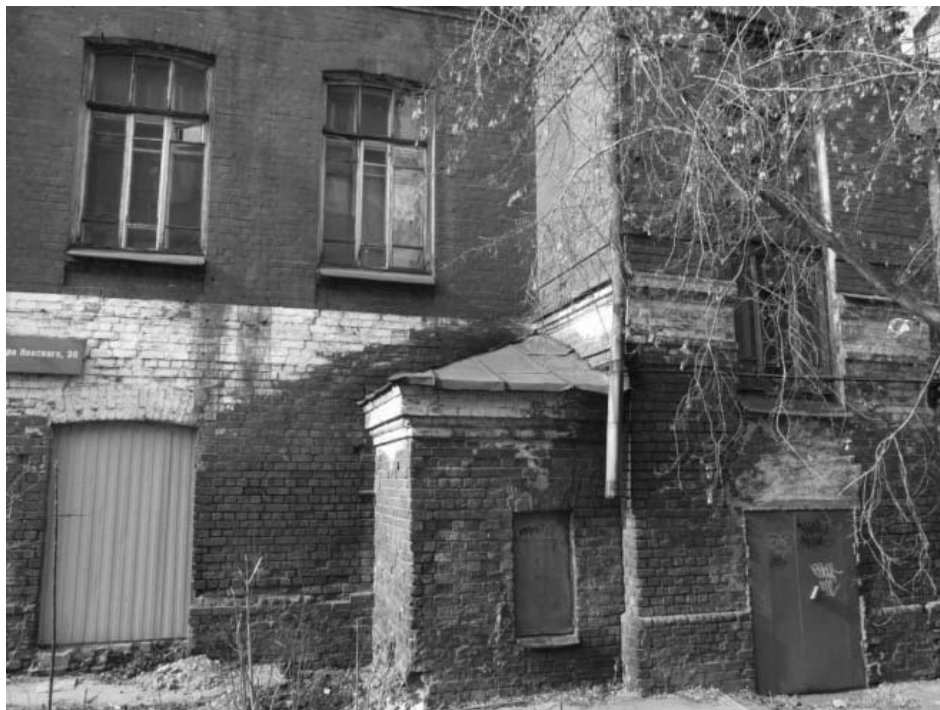
Фото 10 - Фрагмент юго-восточного фасада
