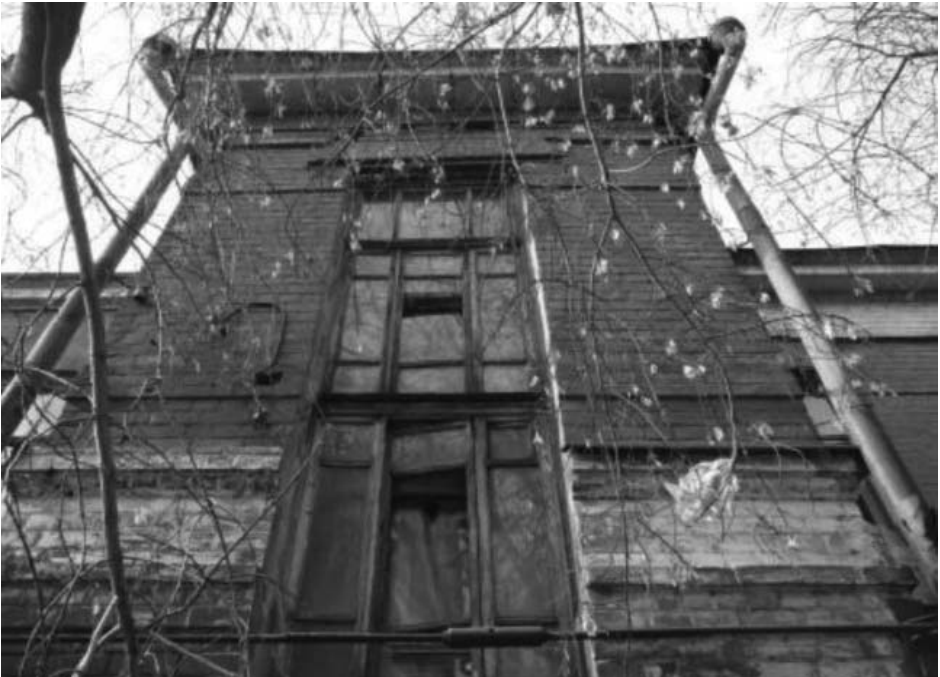
Фото 9 - Фрагмент юго-восточного фасада
