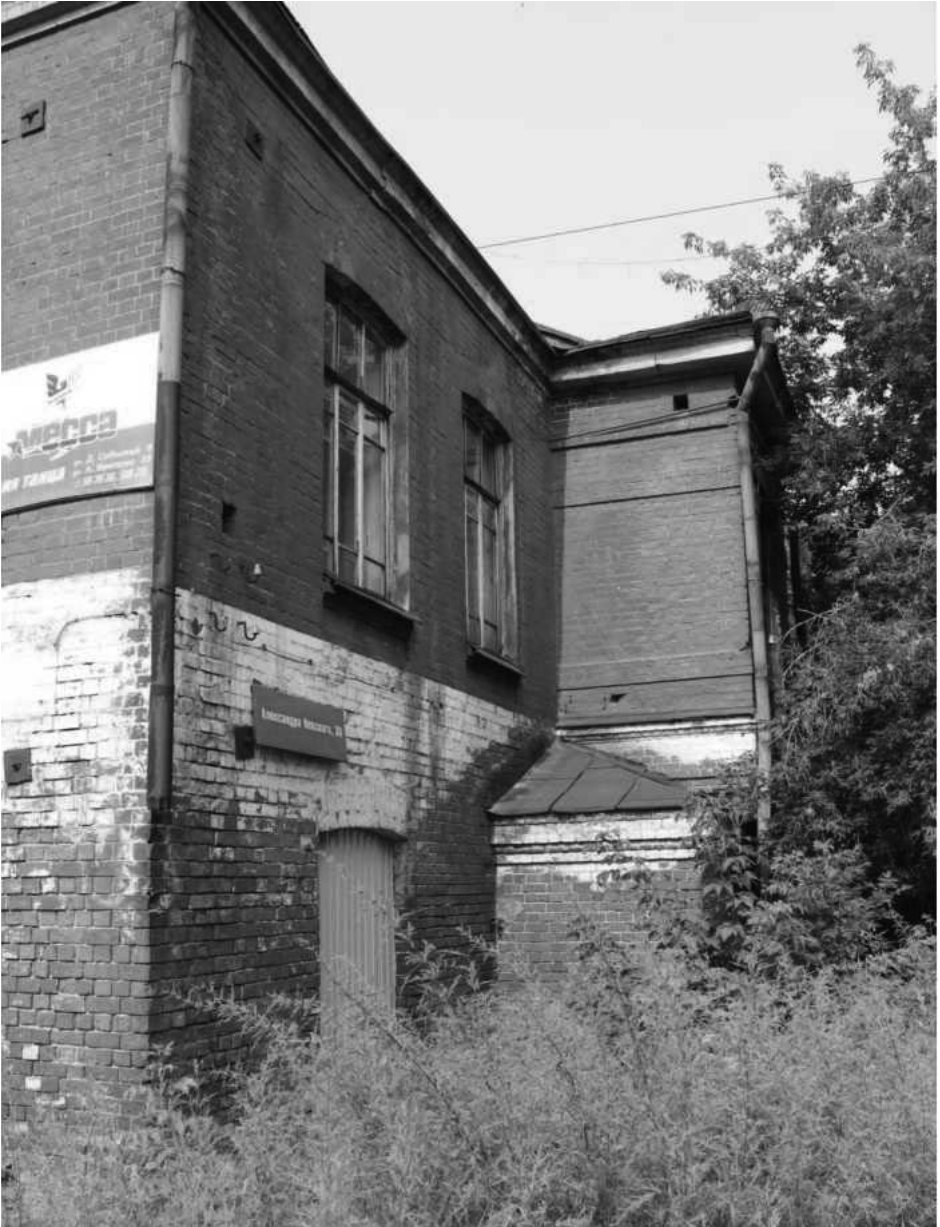
Фото 8 - Фрагмент юго-восточного фасада
