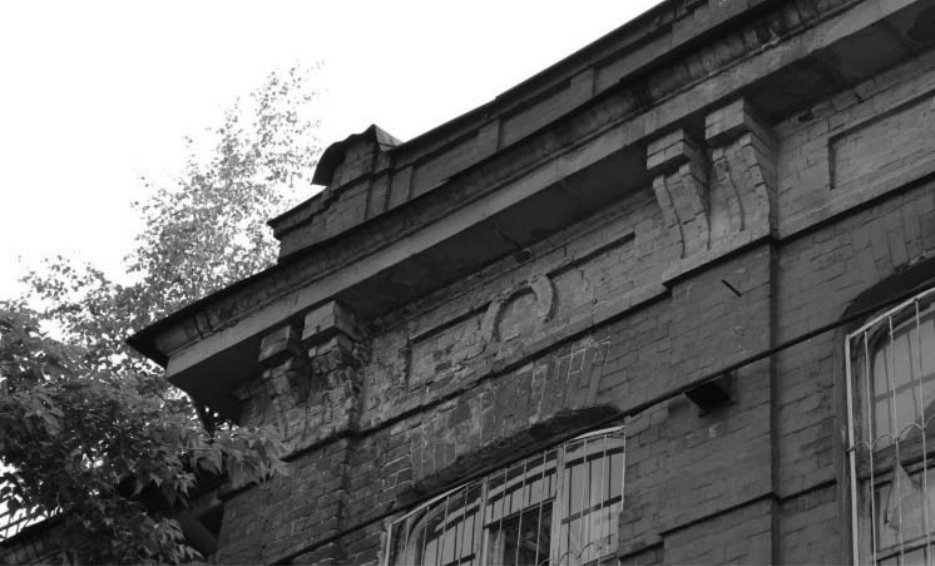
Фото 4 - Фриз и карниз на главном фасаде
