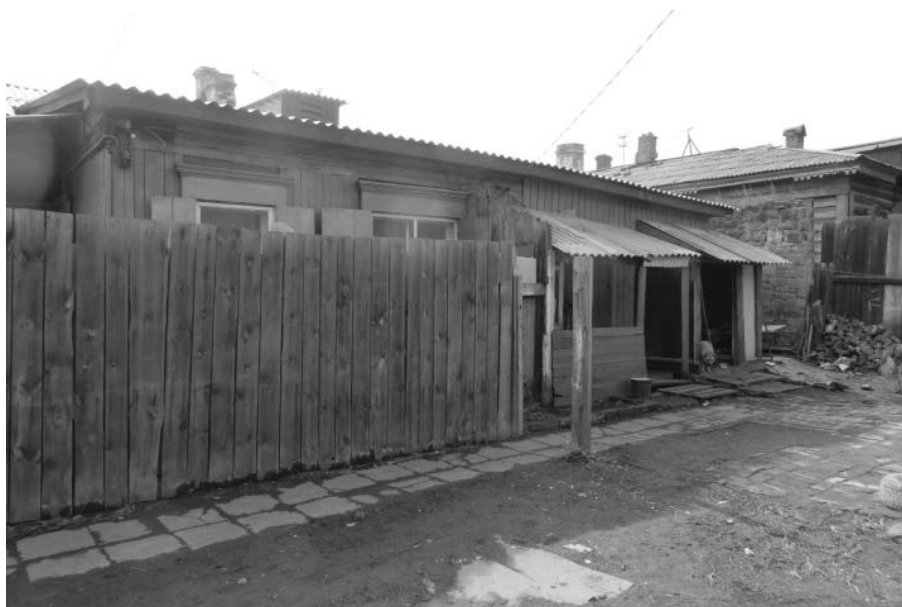
Фото №10 - Дворовой северо-восточный фасад.
