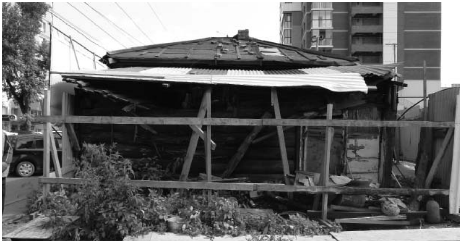
Фото №11 - Северо-западный фасад
