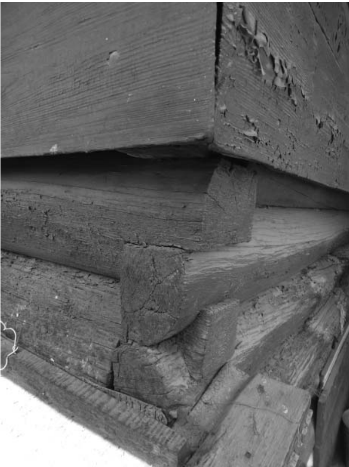
Фото №6 - Деревянные, рубленные «в лапу» стены
