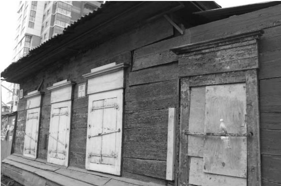
Фото №3 - Оконные наличники главного (северо-восточного) фасада
