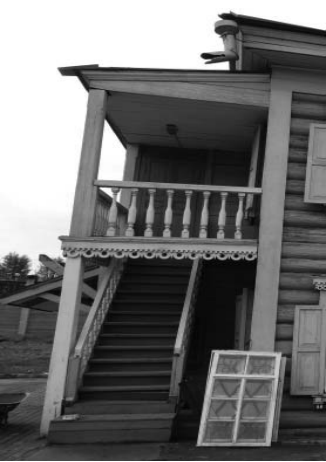
Фото 5,6. Фрагмент северо-восточного фасада. Автор снимка: Захарова А.С. Дата съемки: сентябрь 2013 г.
