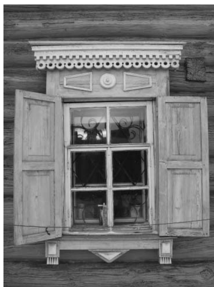
Фото 16. Юго-западный фасад. Типовой наличник оконных проемов первого этажа. Автор снимка: Захарова А.С. Дата съемки: январь 2013 г.
