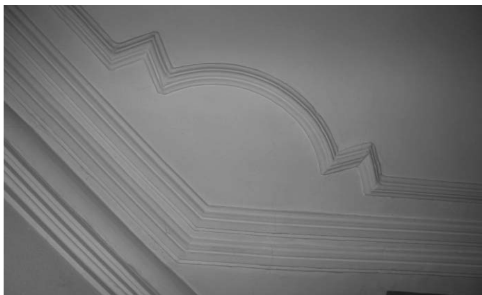
Фото 21. Интерьер. Первый этаж. Тяги, падуги стен и потолка. Автор снимка: Захарова А.С. Дата съемки: январь 2013 г.
