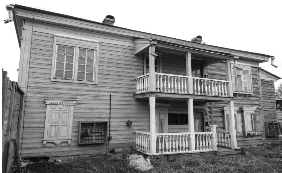
Фото 9. Юго-западный фасад. Автор снимка: Захарова А.С. Дата съемки: сентябрь 2013 г.
