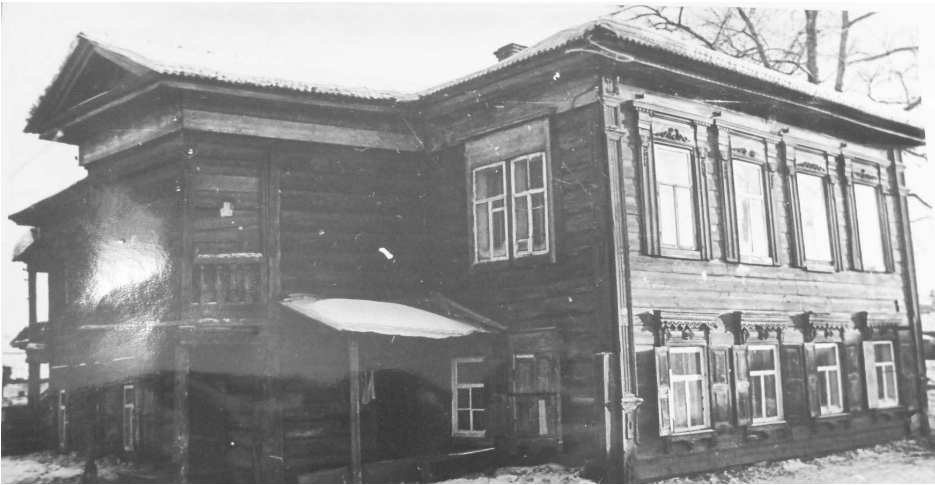
Фото 24. Общий вид. Угол северо-западного и северо-восточного фасадов. Автор снимка: Барановский Е.Ю. Дата съемки: 1979 г.
