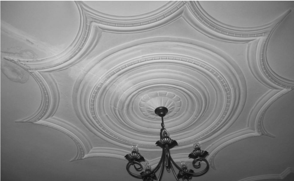
Фото 22. Интерьер. Второй этаж. Розетка. Автор снимка: Захарова А.С. Дата съемки: январь 2013 г.
