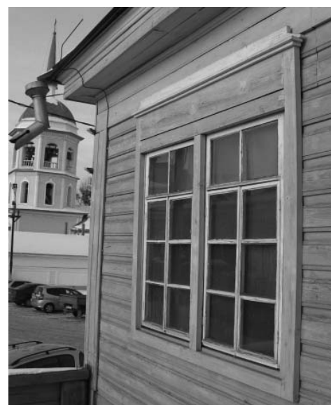
Фото 16. Юго-западный фасад. Типовой наличник оконных проемов первого этажа. Автор снимка: Захарова А.С. Дата съемки: январь 2013 г.
