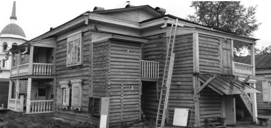
Фото 7. Общий вид. Угол юго-восточного и юго-западного фасадов. Автор снимка: Захарова А.С. Дата съемки: сентябрь 2013 г.
