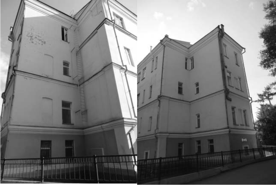
Равновысокий пристрой со стороны дворового (северо-восточного) фасада левого крыла Кузнецовской больницы
