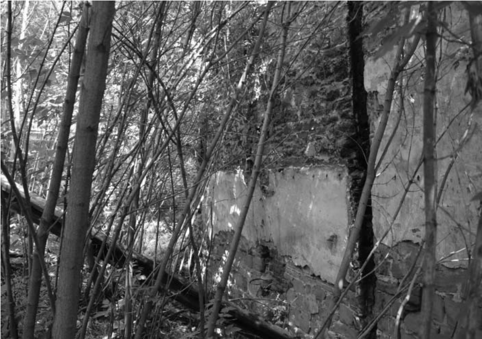
Фото А.А. Жильцов, июль 2017 г. Фрагмент юго-западного фасада.
