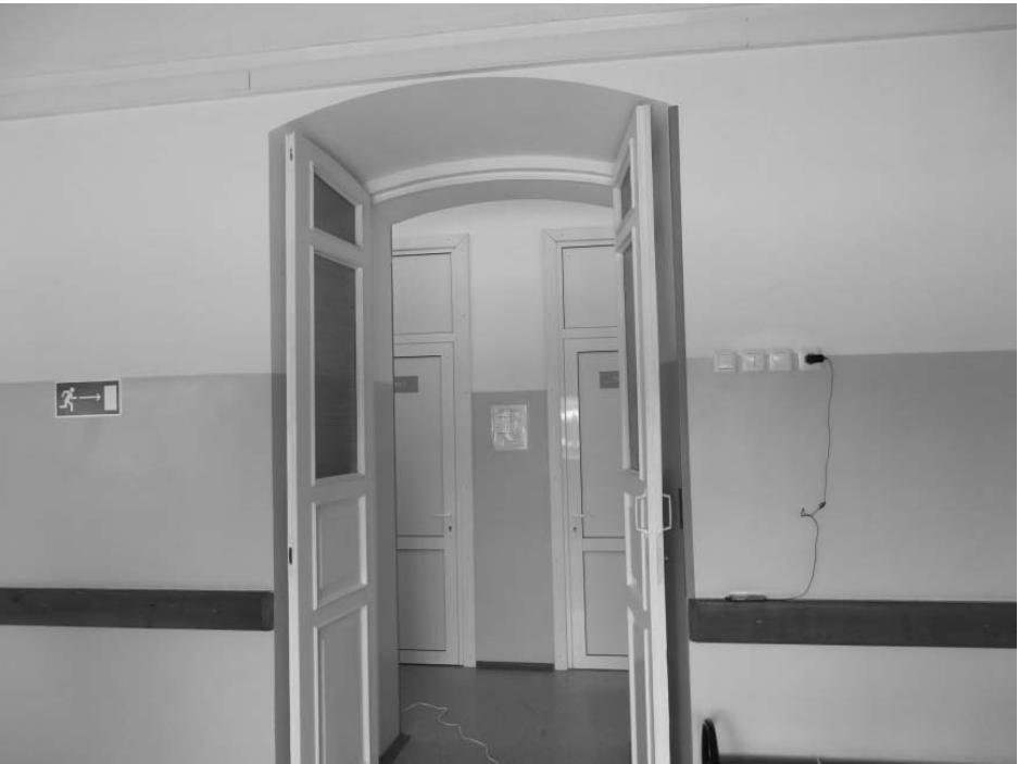
Интерьер помещений (деревянная дверь с лучковым завершением)
