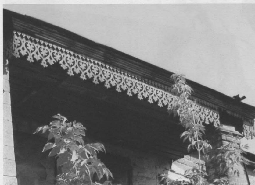
Фото 18 Боковой юго-восточный фасад; карниз и подзор галереи
