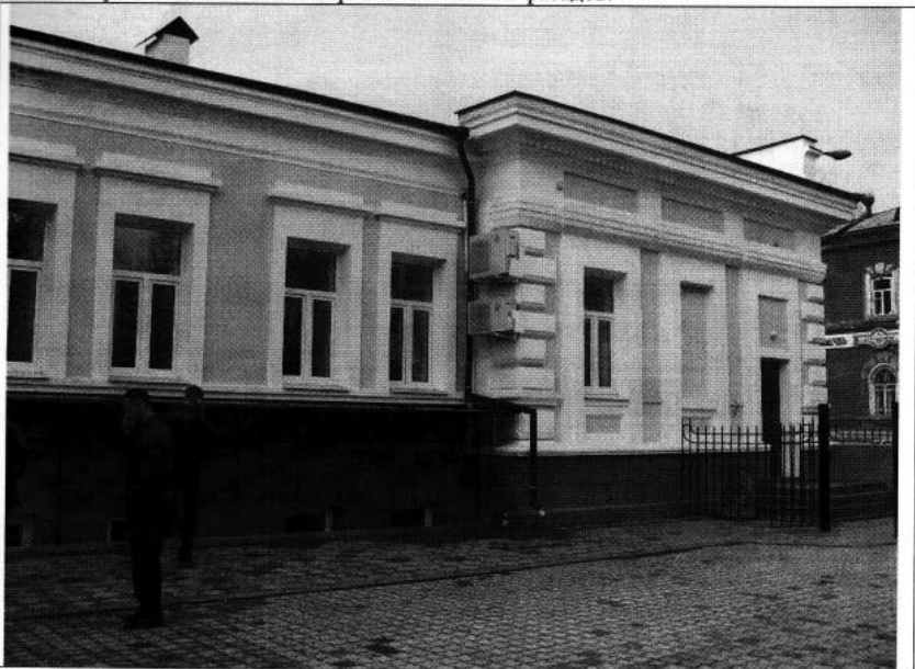
Фото 4. Боковой северный фасад. Вид со стороны двора.
