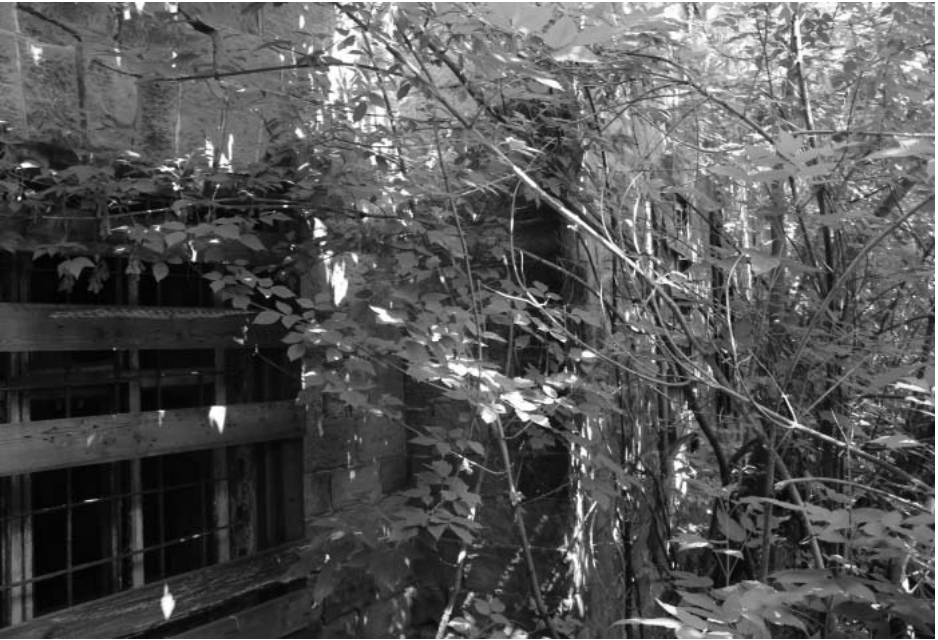
Фото А.А. Жильцов, июль 2017 г. Юго-восточный фасад, вид на окна первого этажа.
