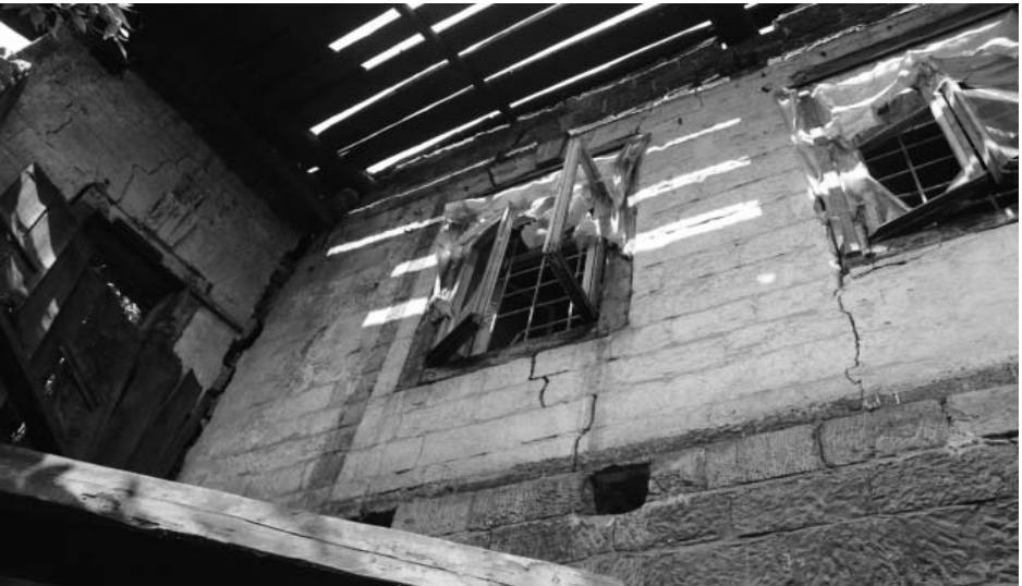
Фото А.А. Жильцов, июль 2017 г. Юго-восточный фасад, вид на окна второго этажа и пазы утраченных выпускных балок галереи.
