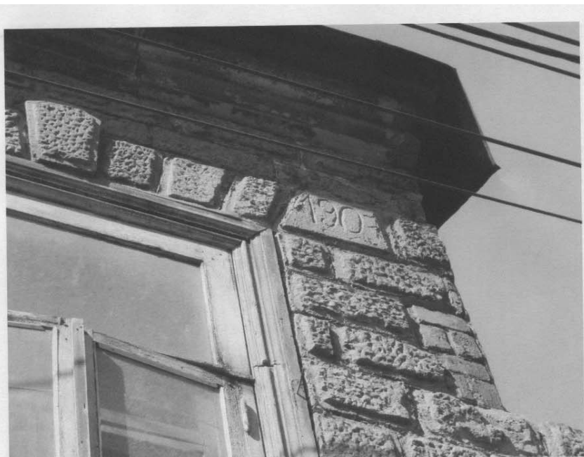
Фото 11 Лицевой северо-восточный фасад; клеймо с датой постройки, карниз
