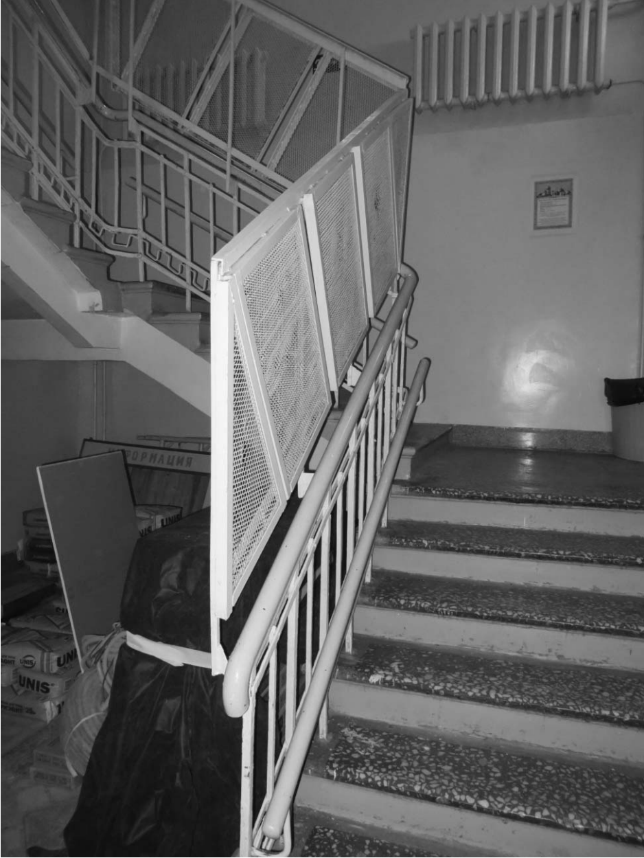
Лестница с металлическим ограждением
