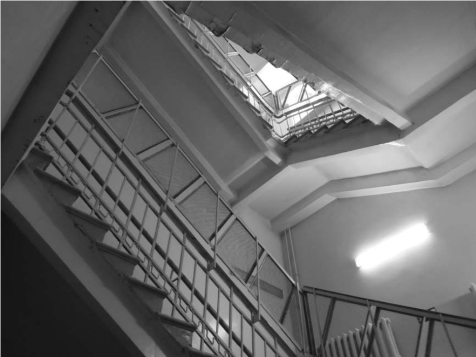
Лестница с металлическим ограждением
