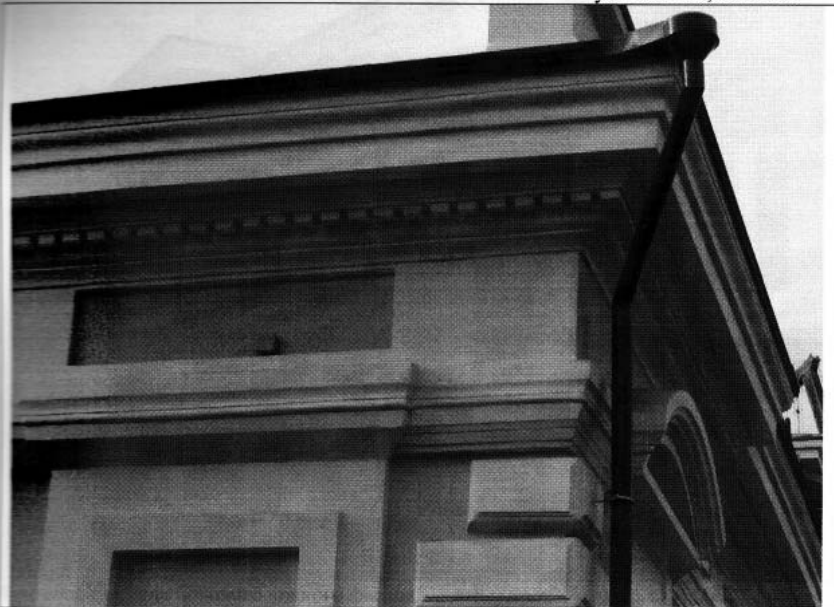
Фото 3. Фрагмент бокового северного и главного фасадов.
