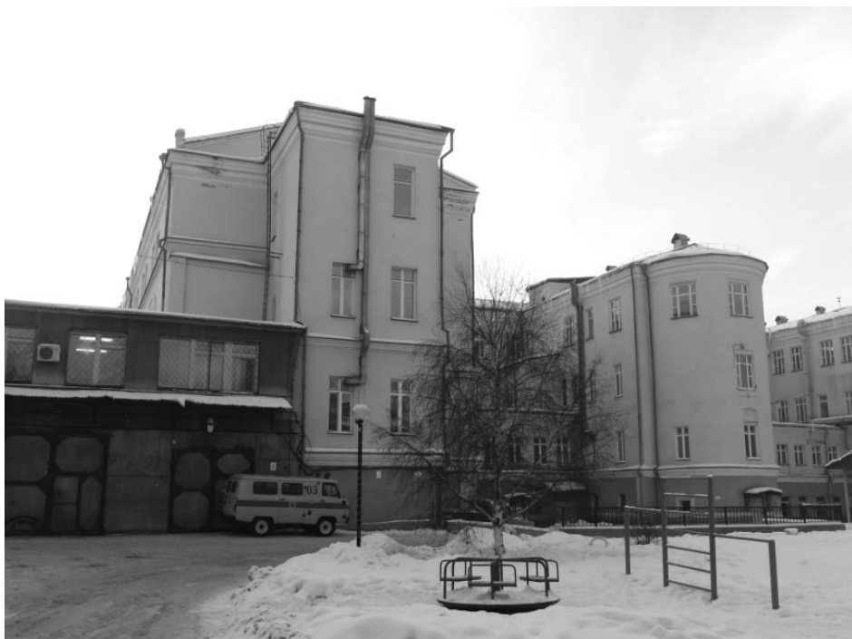
Равновысокий пристрой правого крыла дворового (северо-восточного) фасада Кузнецовской больницы
