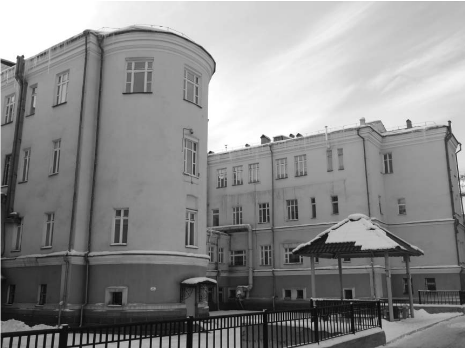
Вид на левое крыло и объем домовый церкви со стороны дворового (северо-восточного) фасада
