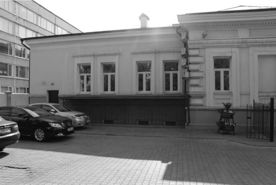
Фото А.А. Жильцов, июль 2017 г. Фрагмент восточного фасада.
