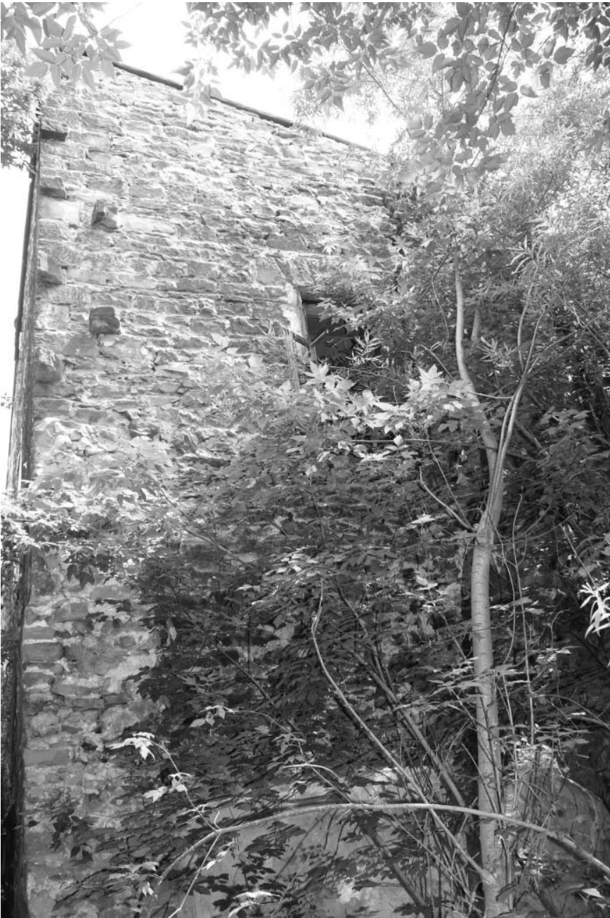
Фото А.А. Жильцов, июль 2017 г. Юго-западный фасад.
