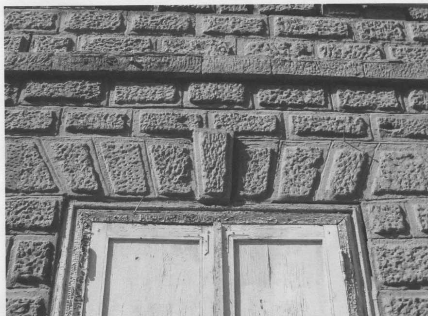
Фото 8. Лицевой северо-восточный фасад; клинчатая перемычка окна, междуэтажный пояс.
