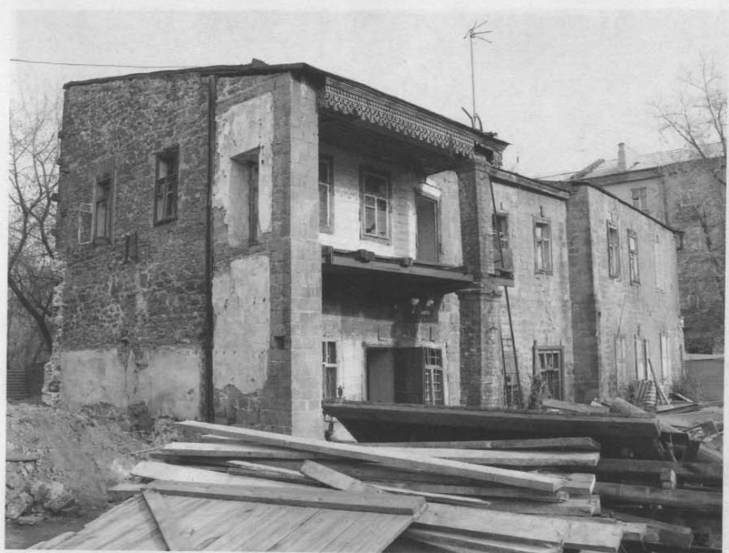
Фото 14 Боковой юго-восточный фасад; вид с юга. Фото 2006 г.
