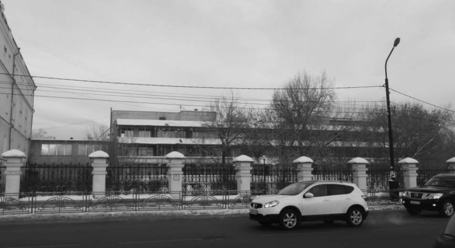
Пристрой нового корпуса со стороны бокового (юго-восточного) фасада
