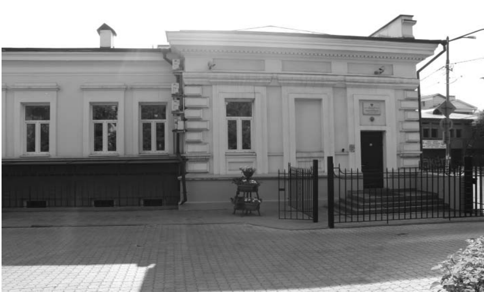
Фото А.А. Жильцов, июль 2017 г. Фрагмент восточного фасада.
