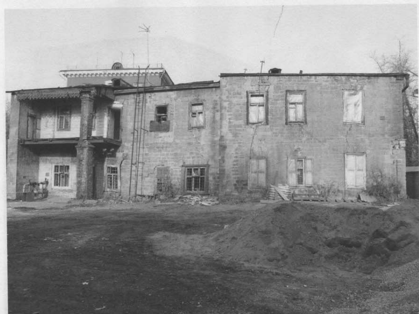
Фото 12 Боковой юго-восточный фасад. Фото 2006 г.
