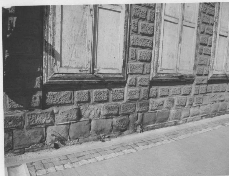
Фото 9. Лицевой северо-восточный фасад; подоконные ниши
