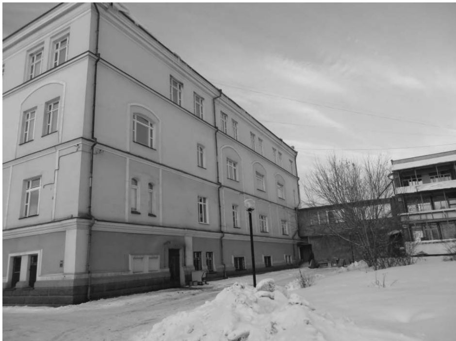
Боковой (юго-восточный) фасад Кузнецовской больницы
