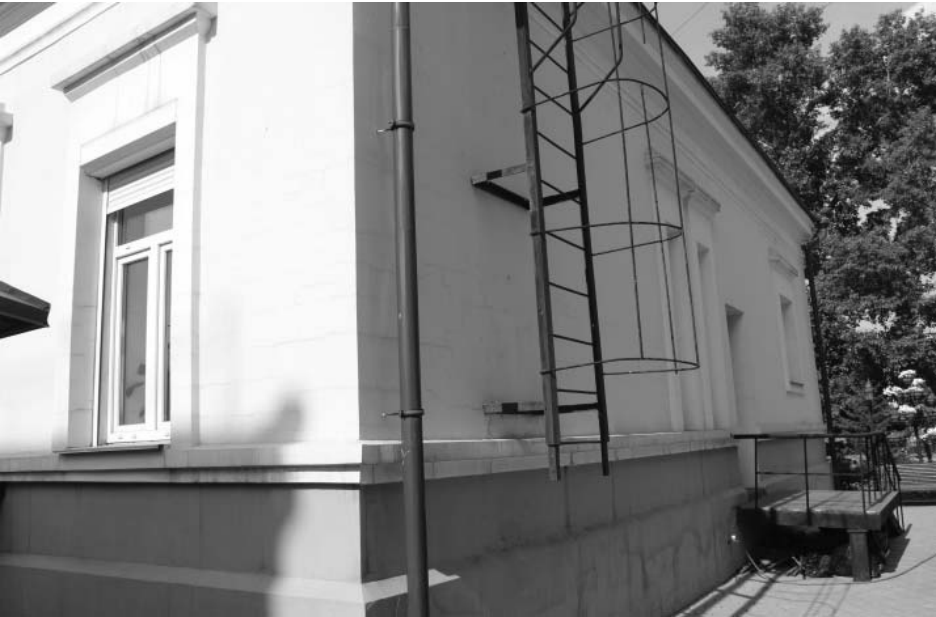
Фото А.А. Жильцов, июль 2017 г. Южный фасад.
