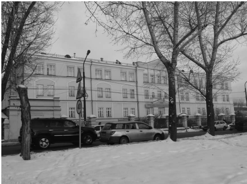
Вид Кузнецовской больницы с бульвара Гагарина (югозападный фасад)
