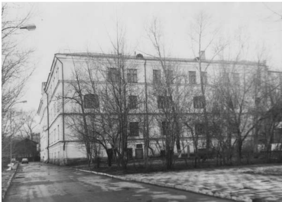
Боковой (юго-восточный) фасад, фото Хохрина Е.В., 1983г.
