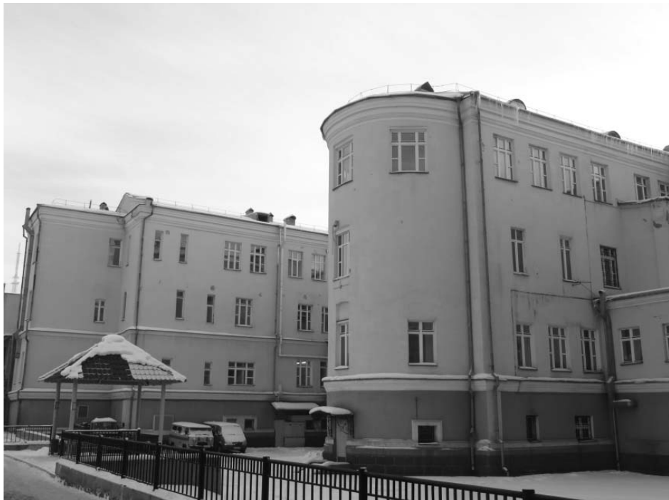
Вид на правое крыло и объем домовая церкви со стороны дворового (северо-восточного) фасада
