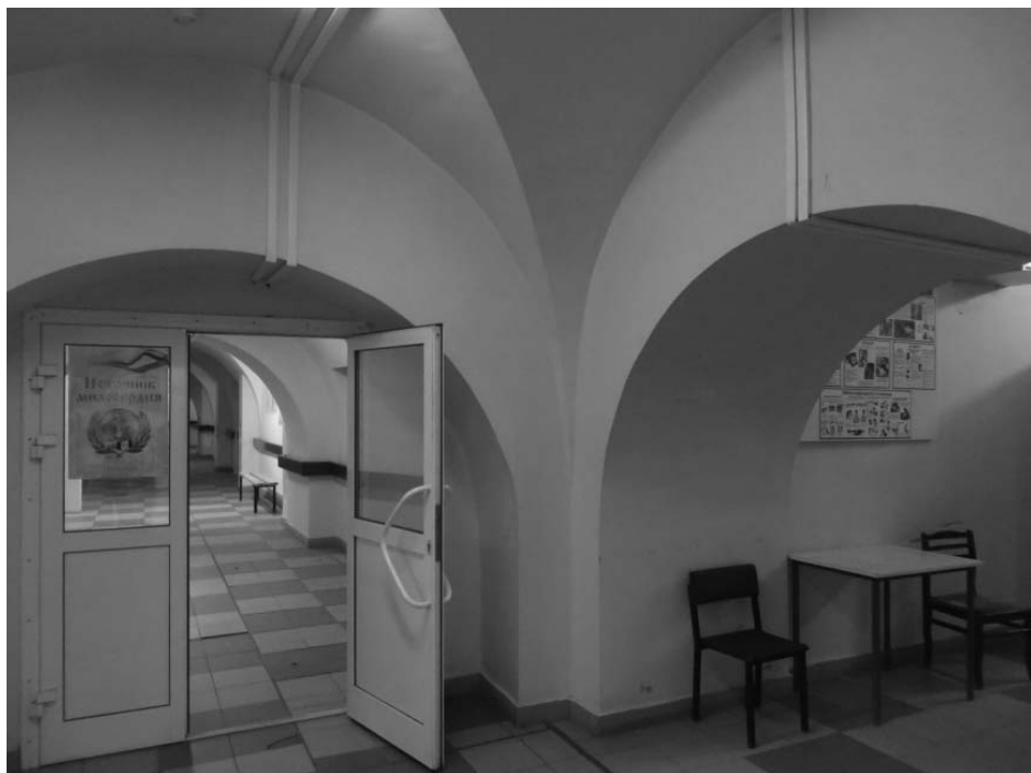
Интерьер цокольного этажа (кreshчатые своды)
