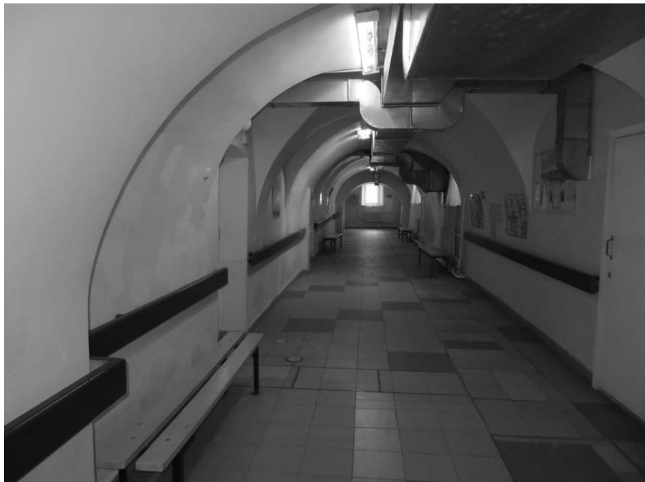
Интерьер цокольного этажа (кreshчатые своды)
