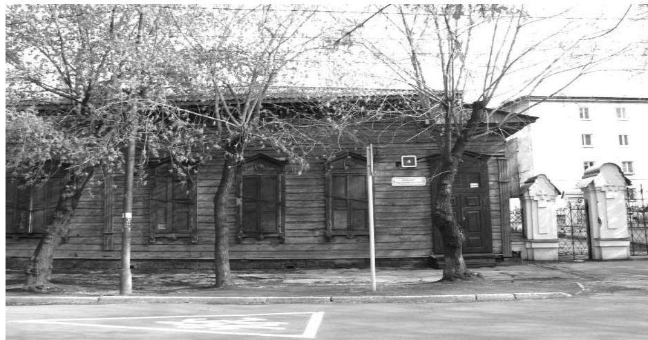
4. г. Иркутск, ул. Чкалова, 4, лит. А. Фрагмент северо-западного фасада, фото 2017 г.
