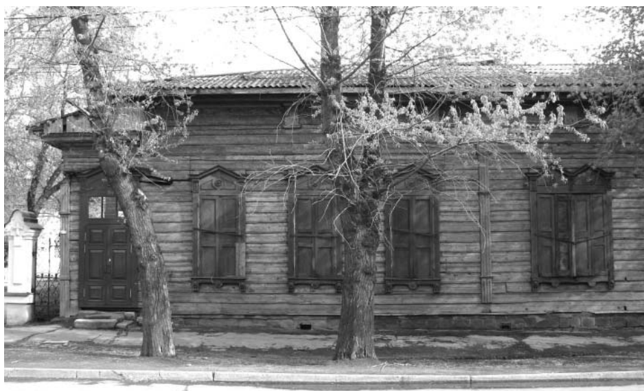
3. г. Иркутск, ул. Чкалова, 4, лит. А. Фрагмент северо-западного фасада, фото 2017 г.
