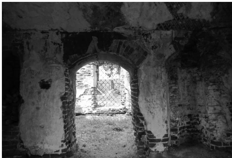
Фото А.А. Жильцов, июнь 2017 г. Вид из притвора на западный вход в церковь.
