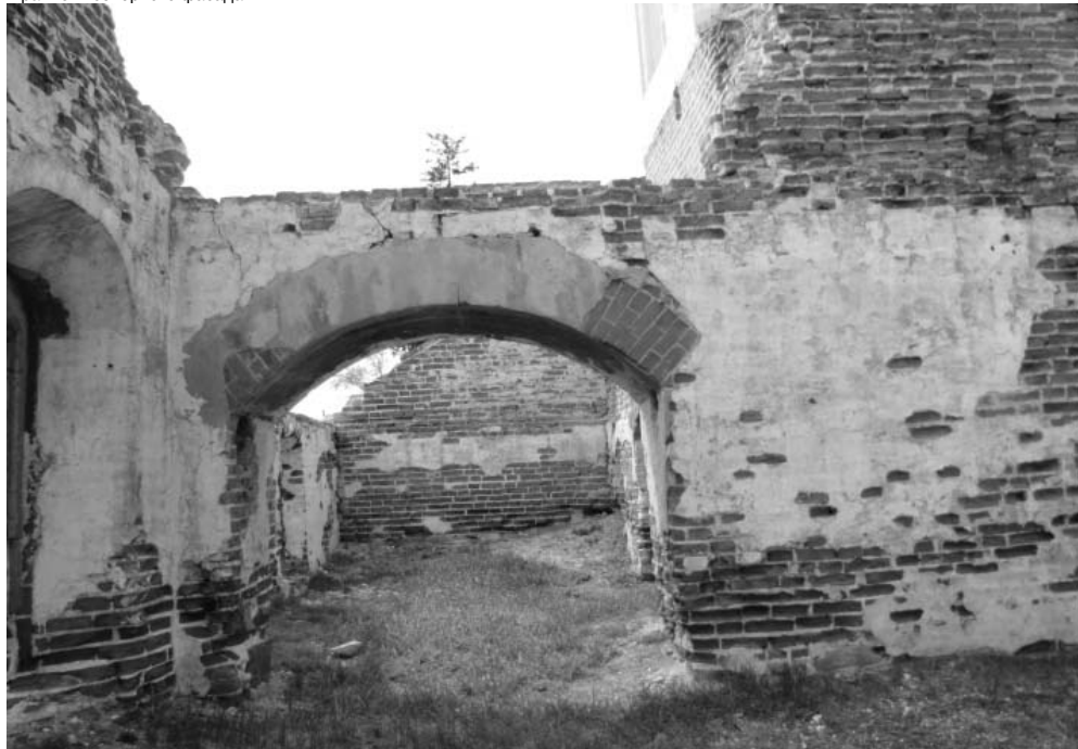
Фото А.А. Жильцов, июнь 2017 г. Пологая арка. Вид из церковной части.
