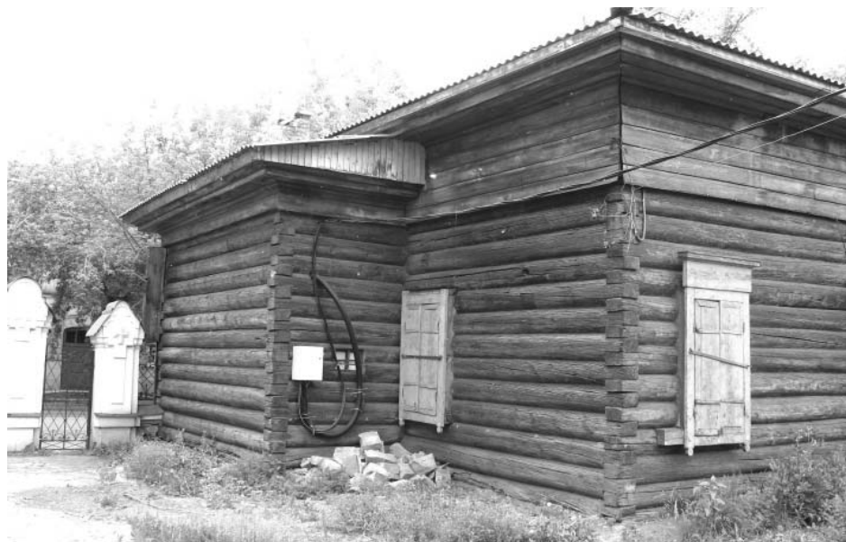
8. г. Иркутск, ул. Чкалова, 4, лит. А. Юго-западный фасад, фото 2017 г.
