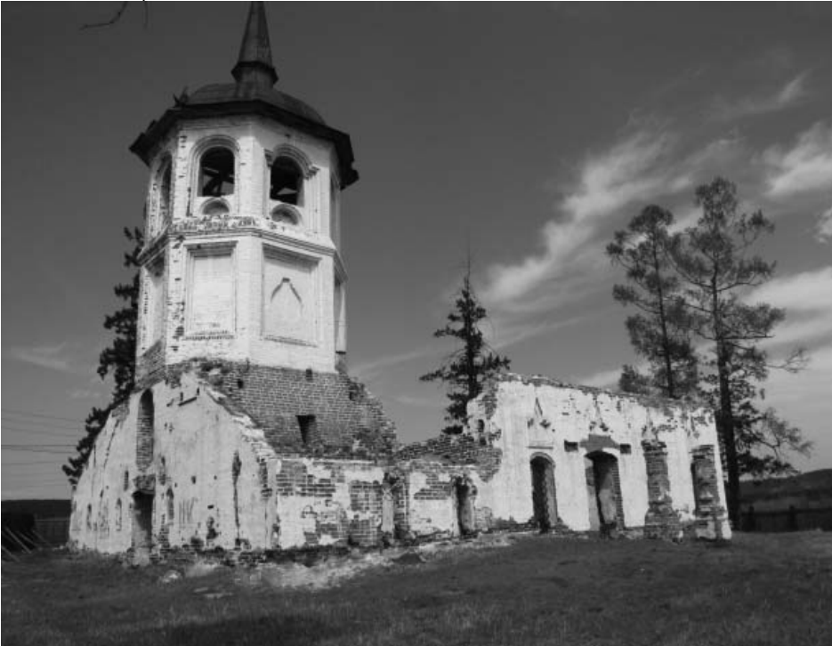
Фото А.А. Жильцов, июнь 2017 г. Южный фасад.
