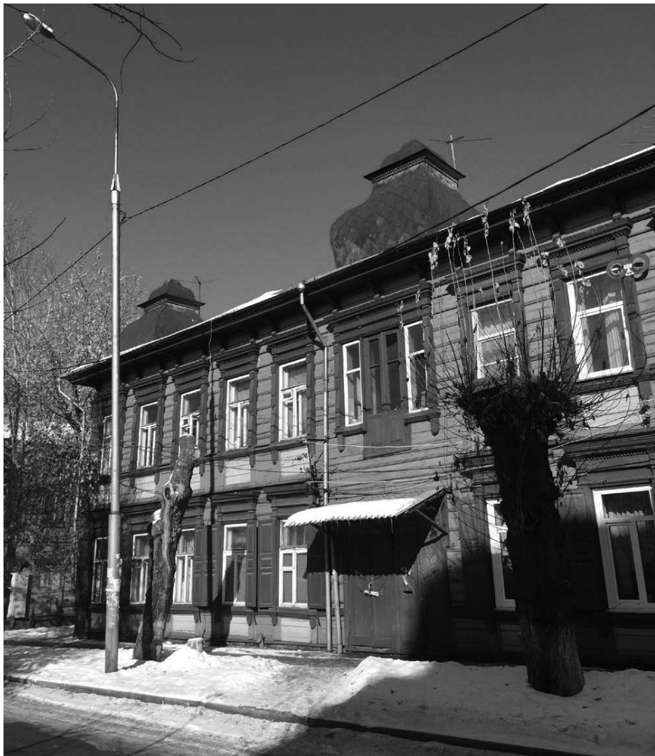
Фото 2. Архивное фото. Главный юго-западный фасад лит. А
