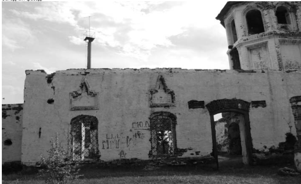
Фото А.А. Жильцов, июнь 2017 г. Фрагмент северного фасада.
