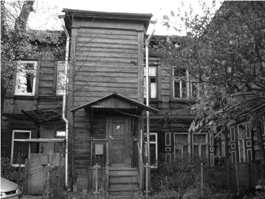
Фото 7. Декоративные элементы оформления дворового фасада лит. А
