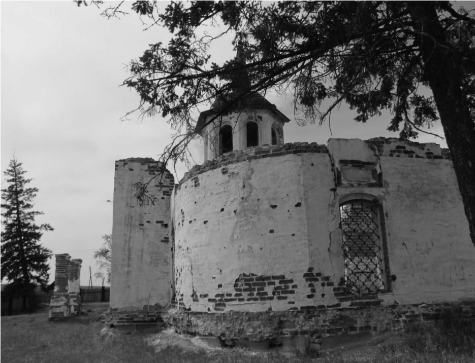
Фото А.А. Жильцов, июнь 2017 г. Восточный фасад.
