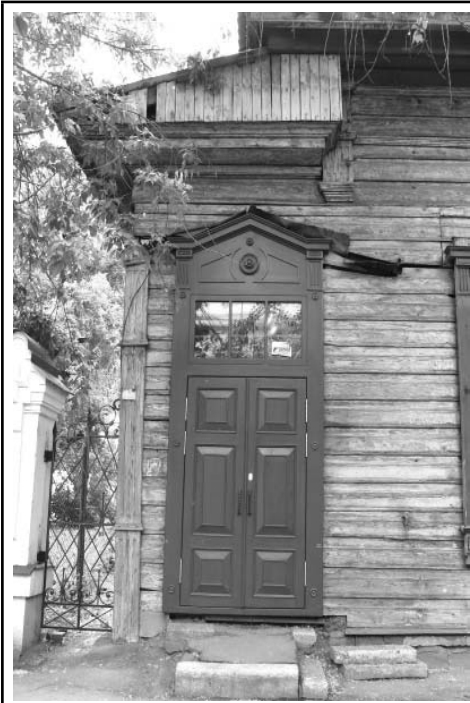
9. г. Иркутск, ул. Чкалова, 4, лит. А. Фрагмент северо-западного фасада, парадный вход в левый прируб, фото 2017 г.
