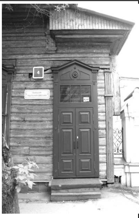
10. г. Иркутск, ул. Чкалова, 4, лит. А. Фрагмент северо-западного фасада, парадный вход в правый прируб, фото 2017 г.
