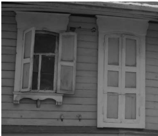
5. Оконный и дверной проемы, наличники, ставни со стороны главного (северо-восточного) фасада, 2 эт. Автор снимка: Шастун Н.В. Дата съемки: февраль 2011 г.
