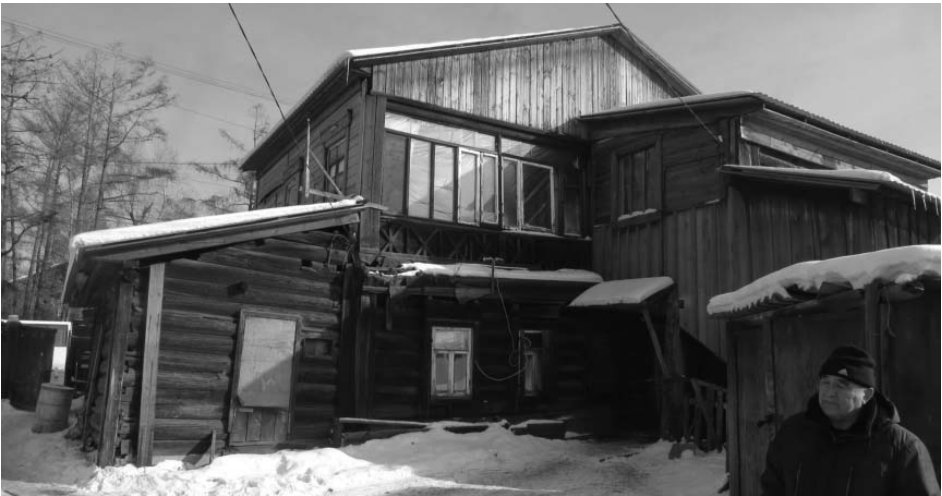
12. Вид на юго-западный фасад здания со стороны двора. Автор снимка: Кравченко В.И. Дата съемки: февраль 2017 г.
