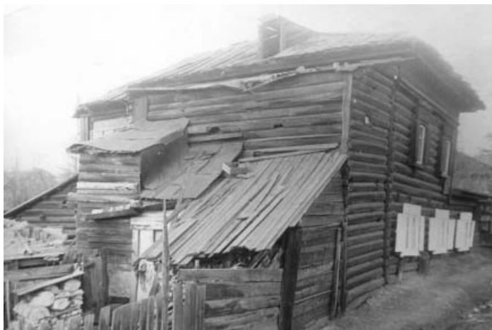
9. Вид на юго-западный фасад здания со стороны внутриквартального тупикового проезда. Автор снимка: Шпирко А.Е. Дата съемки: 1987 г.
