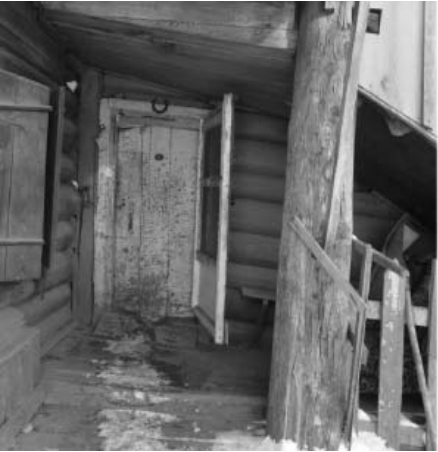
21. Вход в здание со стороны северо-западного фасада двухэтажного прируба. Автор снимка: Кравченко В.И. Дата съемки: февраль 2017 г.
