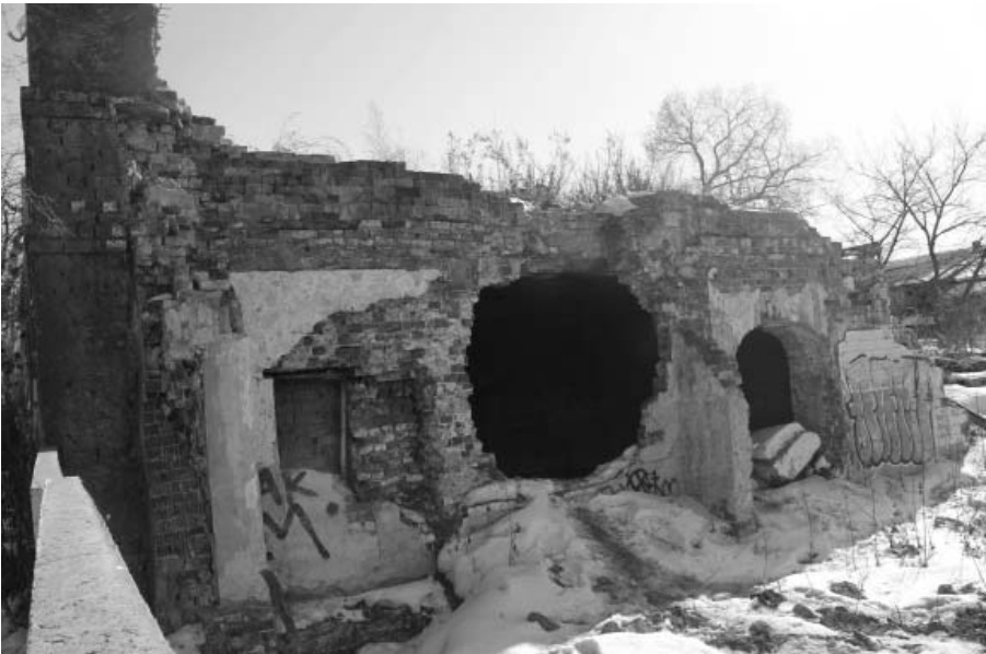
Вид с северо-запада (на старую баню).
