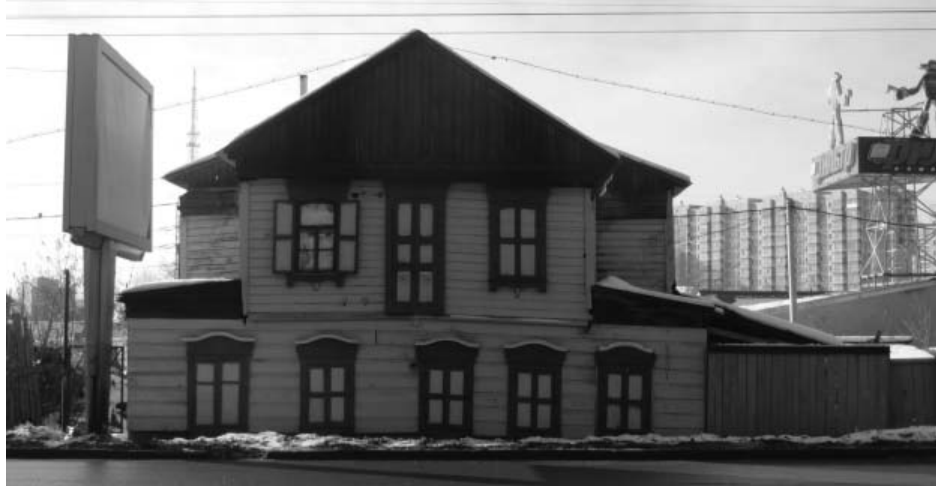
3. Вид на главный (северо-восточный) фасад здания. Автор снимка: Кравченко В.И. Дата съемки: февраль 2017 г.
