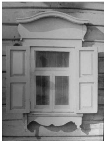
4. Оконный проем, наличник, ставни, обшивка со стороны главного (северо-восточного) фасада, 1эт. Автор снимка: Шпирко А.Е. Дата съемки: 1987 г.
