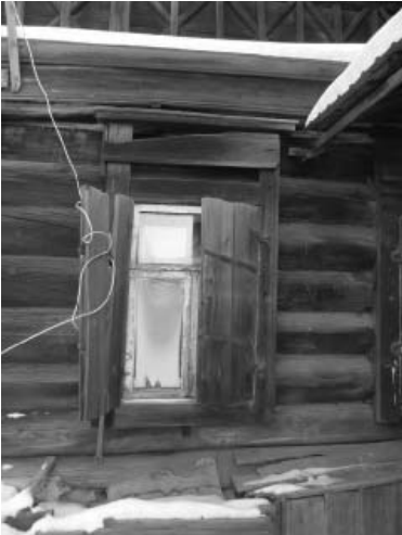
14. Вид на юго-западный фасад здания со стороны двора. Автор снимка: Кравченко В.И. Дата съемки: февраль 2017 г.
