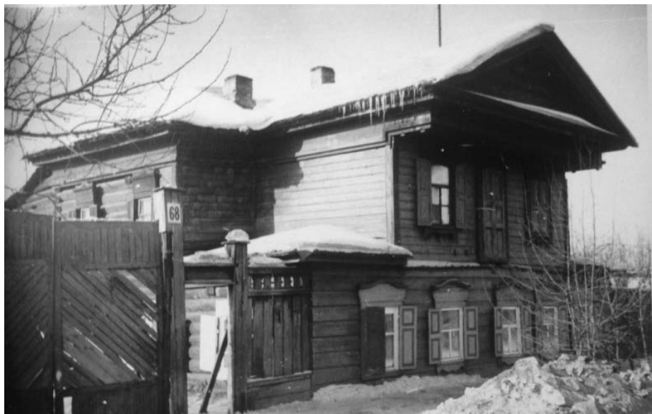
1. Вид на главный (северо-восточный) фасад здания. Автор снимка: Щербин В.Т. Дата съемки: 1981 г.
