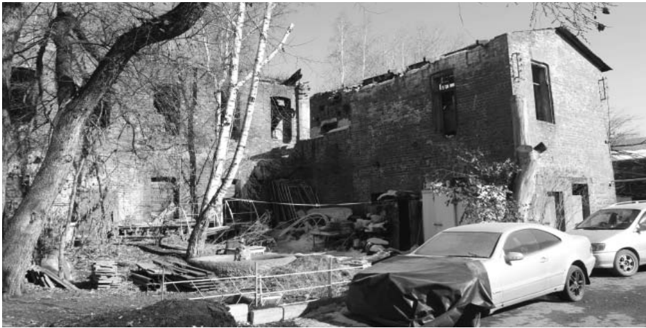
Вид на здание «новой» бани со двора.
