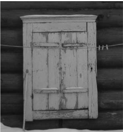
19. Окно первого этажа со стороны северо-западного фасада здания. Автор снимка: Кравченко В.И. Дата съемки: февраль 2017 г.
