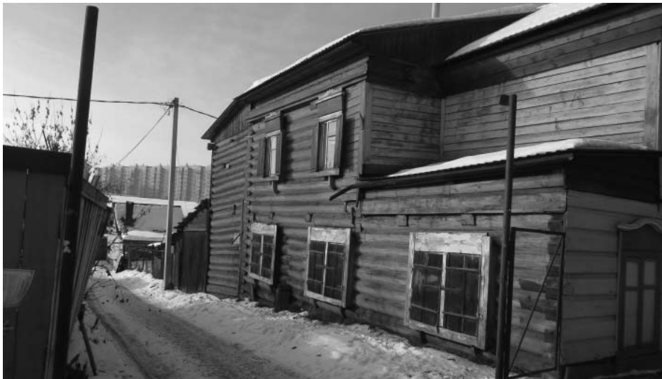
6. Вид на юго-восточный фасад здания со стороны улицы. Автор снимка: Кравченко В.И. Дата съемки: февраль 2017 г.
