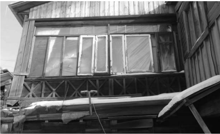
13. Вид на галерею со стороны юго-западного фасада здания со стороны двора. Автор снимка: Кравченко В.И. Дата съемки: февраль 2017 г.
