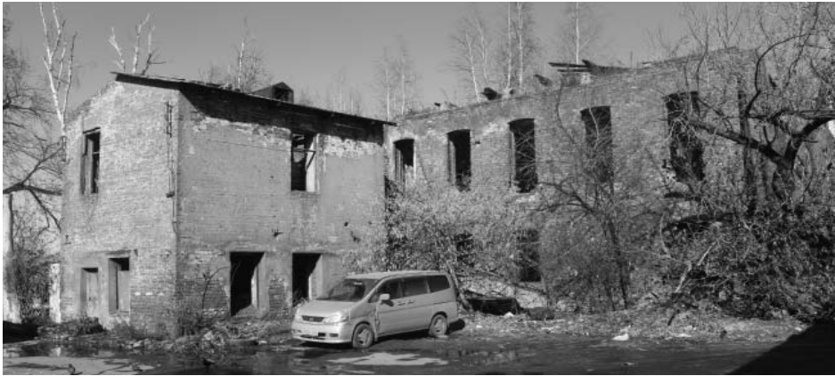
Вид на здание «новой» бани со двора.
