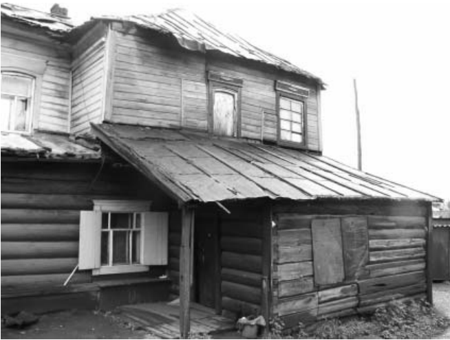
16. Вид на фрагмент северо-западного фасада основного объема одноэтажного прируба здания со стороны двора. Автор снимка: Бельская О.Б. Дата съемки: апрель 2009 г.
