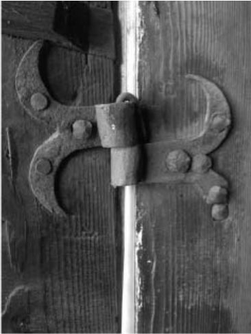
15. Кованые элементы крепления ставень со стороны юго-западного фасада здания. Автор снимка: Кравченко В.И. Дата съемки: февраль 2017 г.
