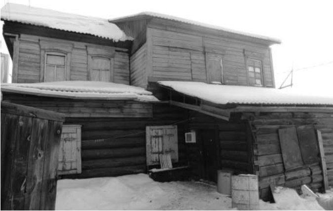
17. Вид на северо-западный фасад здания со стороны улицы. Автор снимка: Кравченко В.И. Дата съемки: февраль 2017 г.
