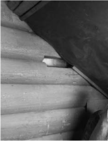
22. Бревна со стороны северо-западного фасада двухэтажного прируба. Автор снимка: Кравченко В.И. Дата съемки: февраль 2017 г.
