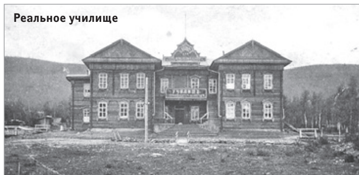
Строительство реального училища (БСШ № 1) 1913 год
