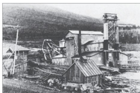
Драга № 601 (крупнейшая в мире речная черпаковая драга для золотодобычи, эксплуатировавшаяся на Мараканской золотой россыпи с 1969 по 1992 год)
