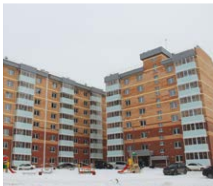
В лучших традициях — под елочку — новоселье отметили 96 работников Иркутского авиазавода
