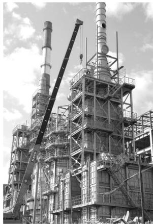
Установка гидроочистки дизельного топлива
