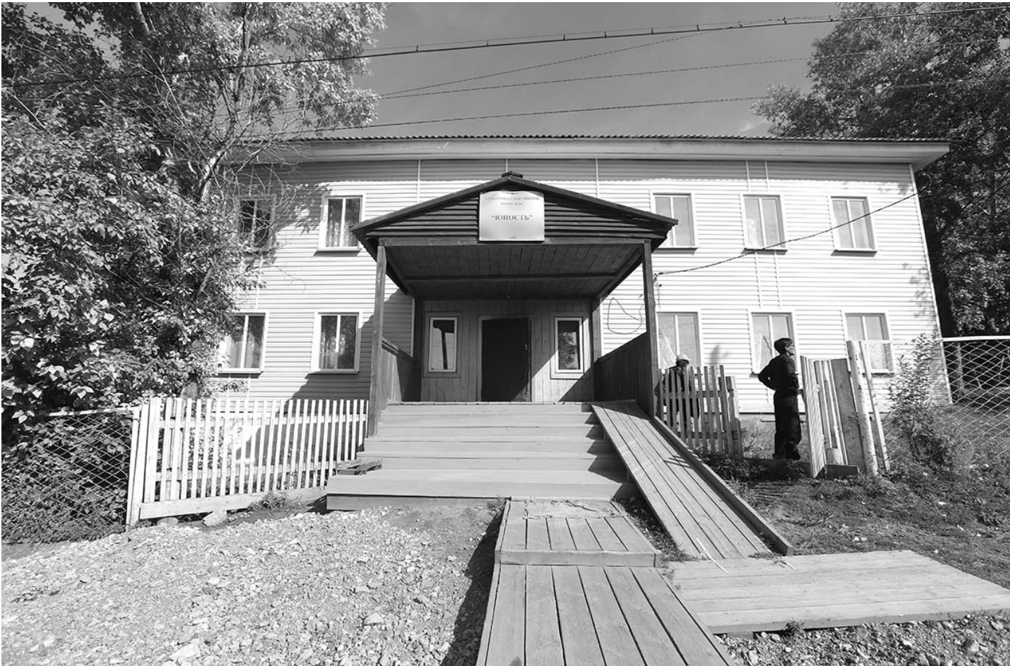
ДК «Юность» после ремонта
