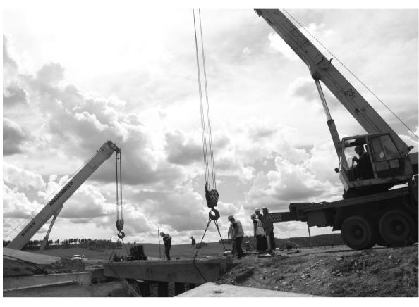
момент рабочие демонтируют пролетные строения моста Каменка - Угольная. Как пояснил начальник мостостроительного управления Дорожной службы Анатолий Ткач, капитальный ремонт предусматривает полную замену опор:
