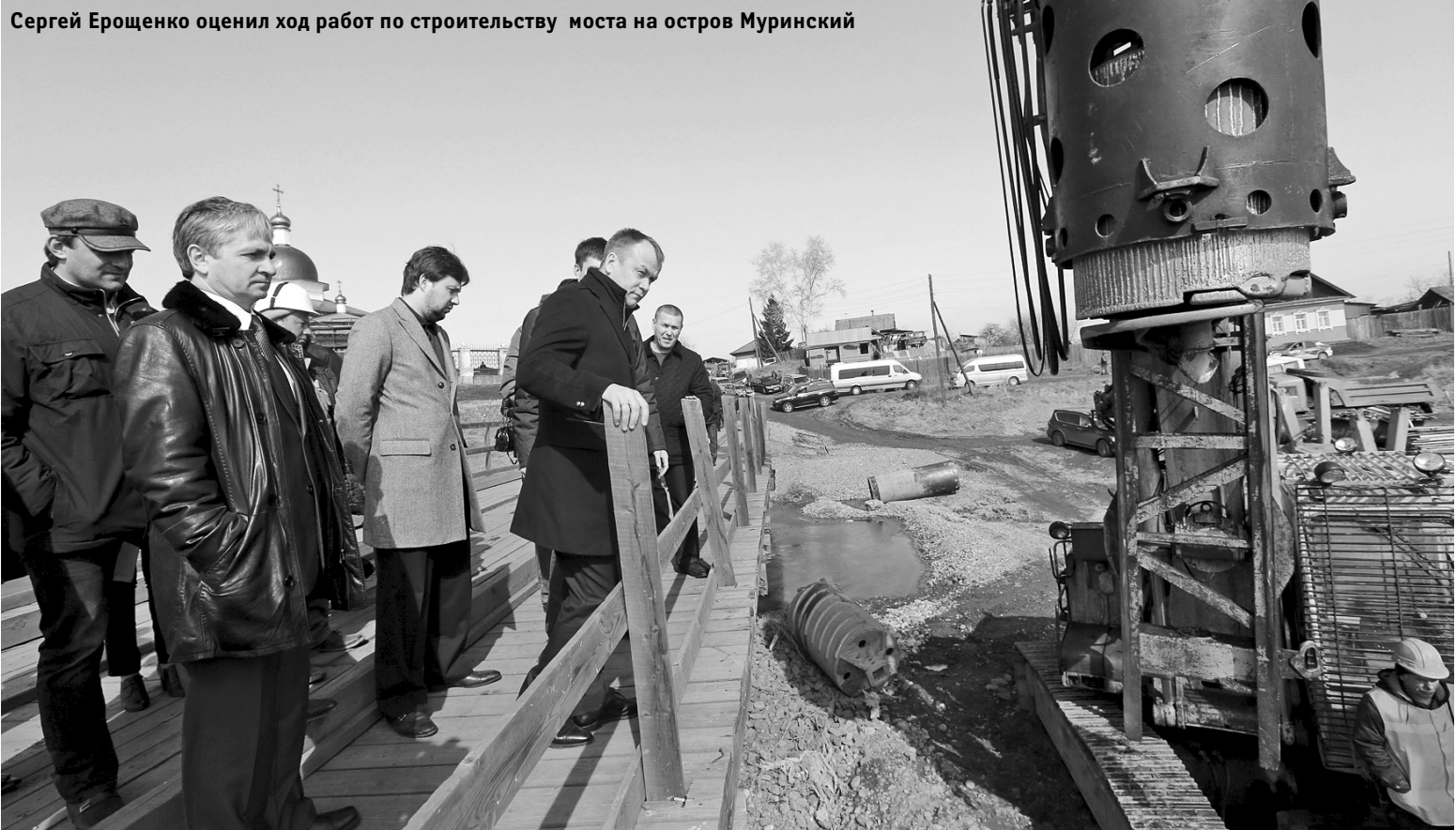
Сергей Ероценко оценил ход работ по строительству моста на остров Муринский
