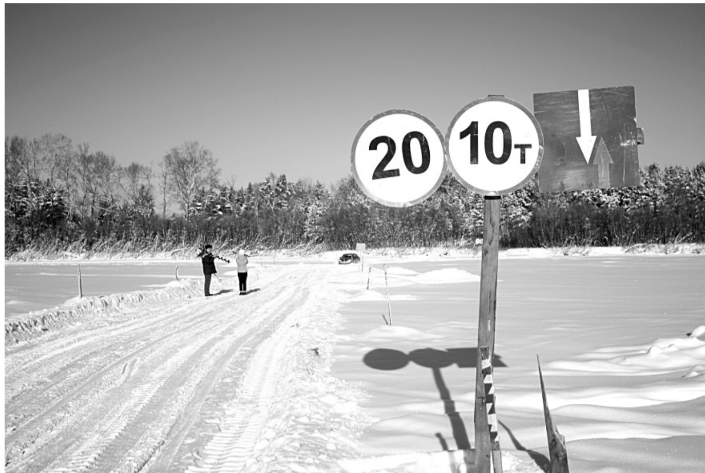
Длина этой переправы 150 метров, и с такой толщиной льда можно пускать грузовики с массой до 60 тонн, но здесь такие не ездят, все больше легковушки
