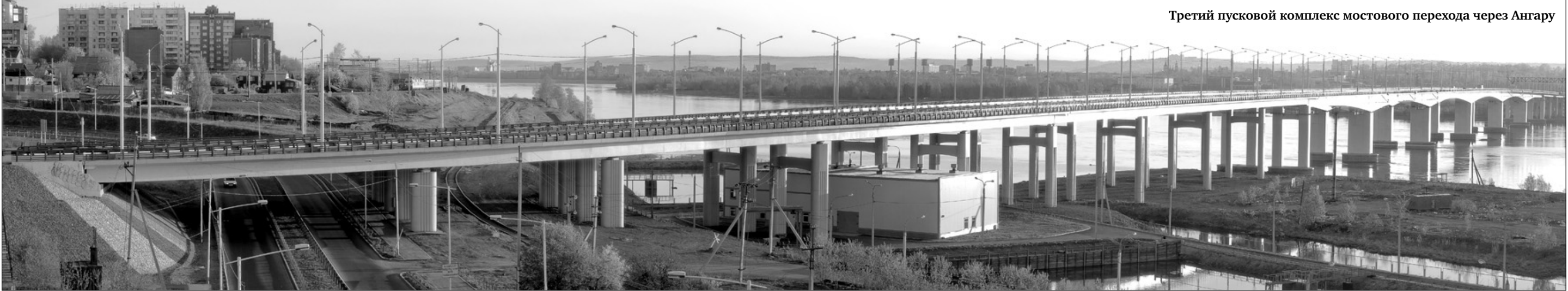
Третий пусковой комплекс мостового перехода через Ангару
