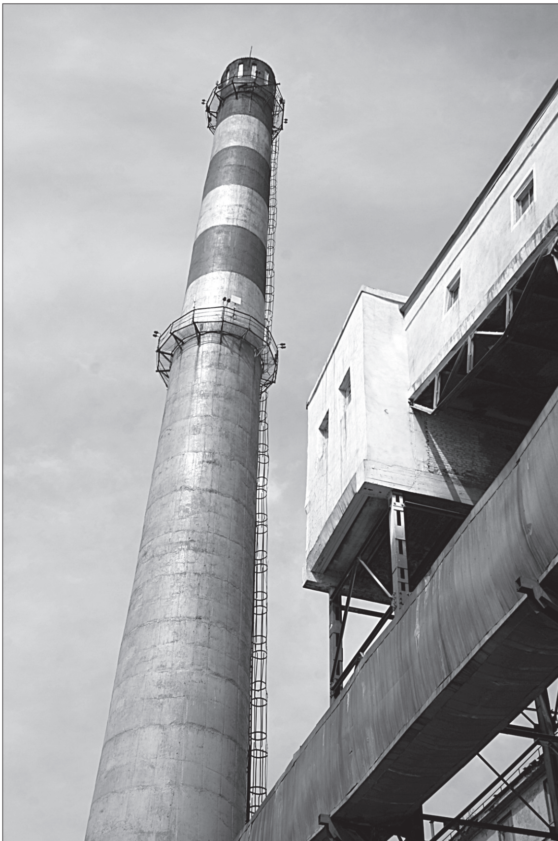
Дымовая труба вполне может вместить в себя лифт и стать смотровой площадкой
