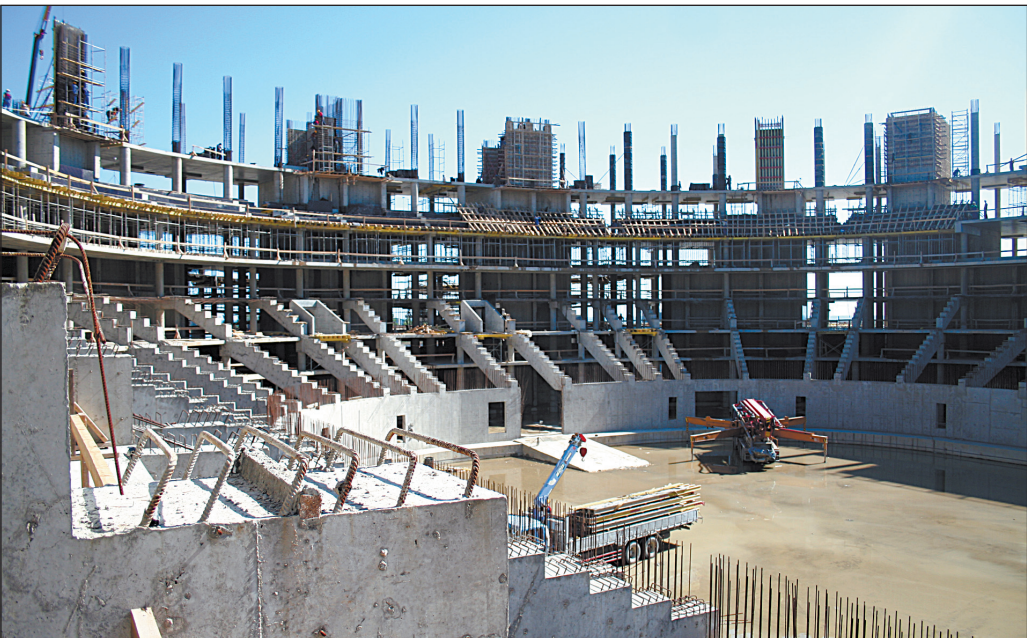
На строительстве большой ледовой арены уложено уже более 80 тысяч кубометров бетона
