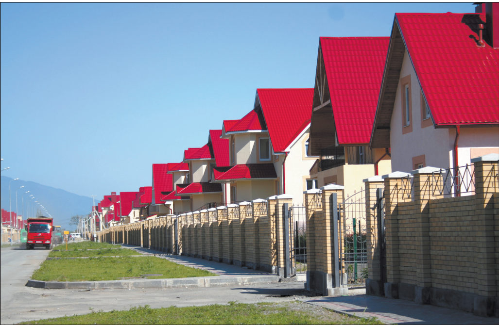
Для тех, кого стройка вынудила покинуть насиженные места, по индивидуальным проектам строятся поселки, полностью обеспеченные коммуникациями
