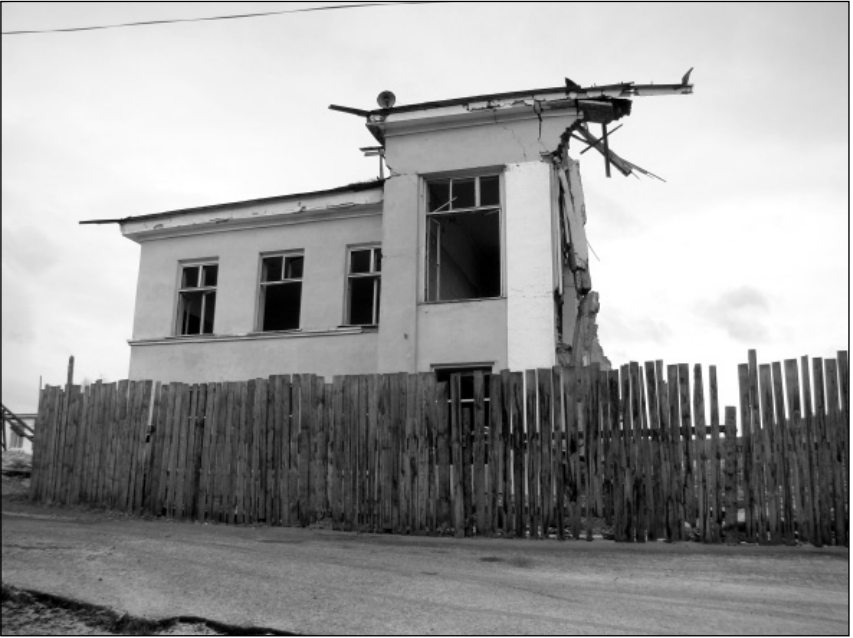
Так сейчас выглядит старая култукская школа, разрушенная землетрясением
