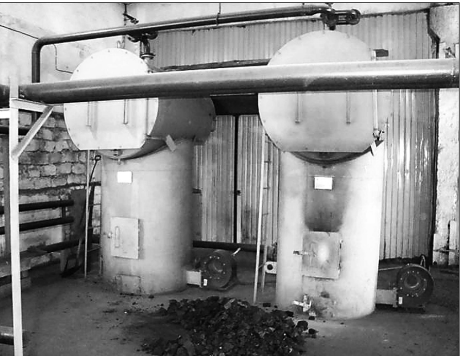
... и после ремонта
