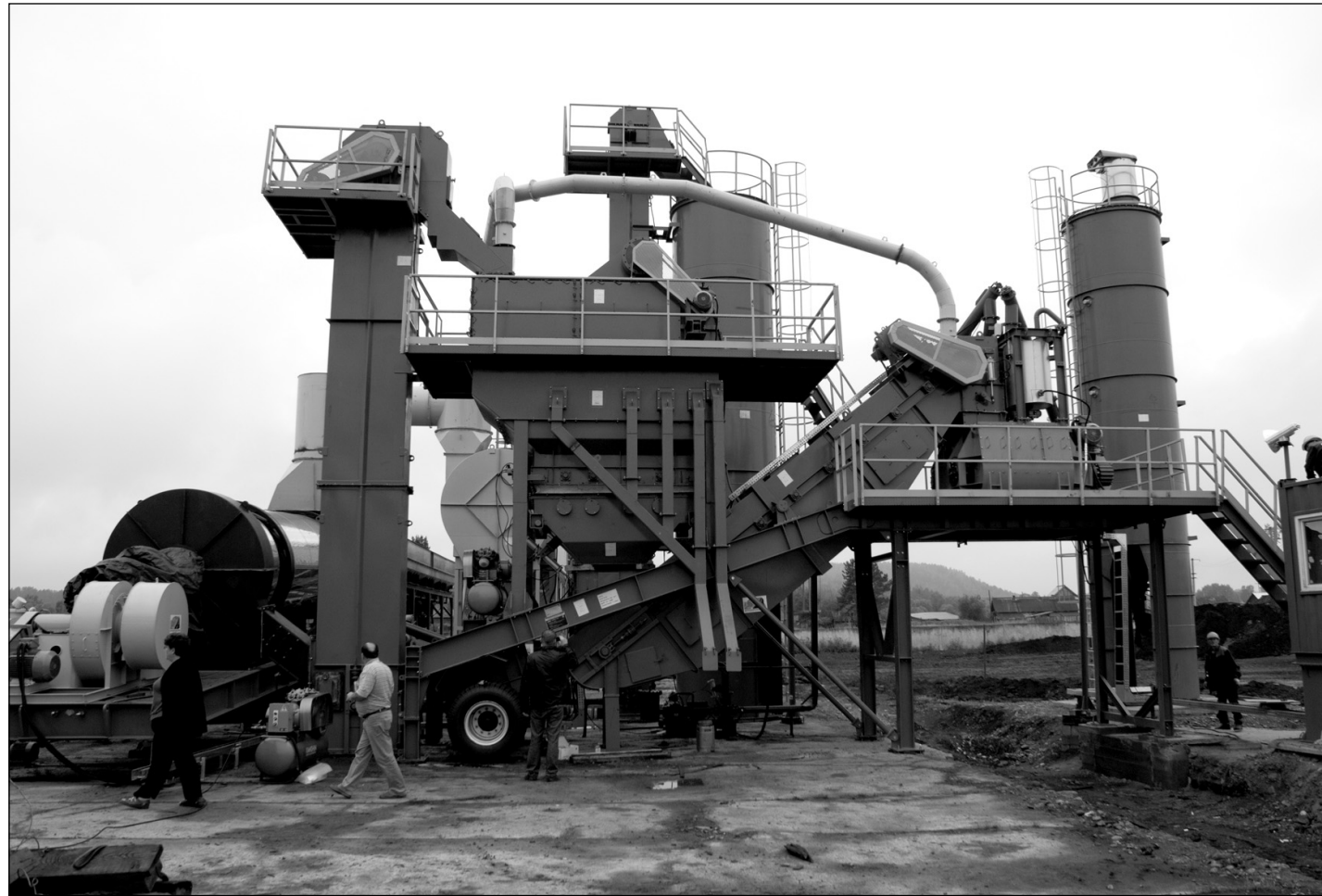
Такие мобильные асфальтобетонные заводы используют дорожники Иркутской области
