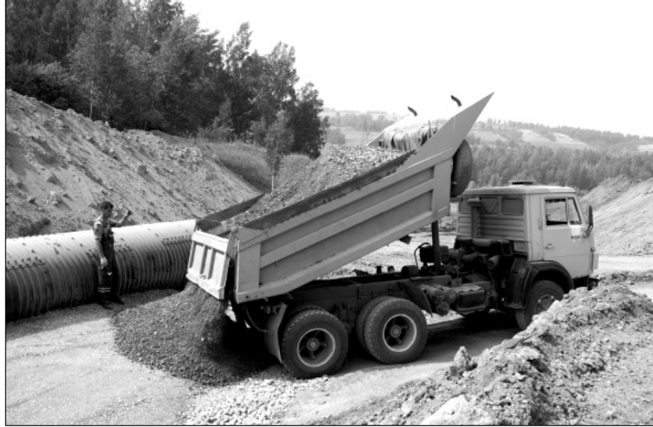
Укладка гофрированных труб в поселке Тыреть Заларинского района
