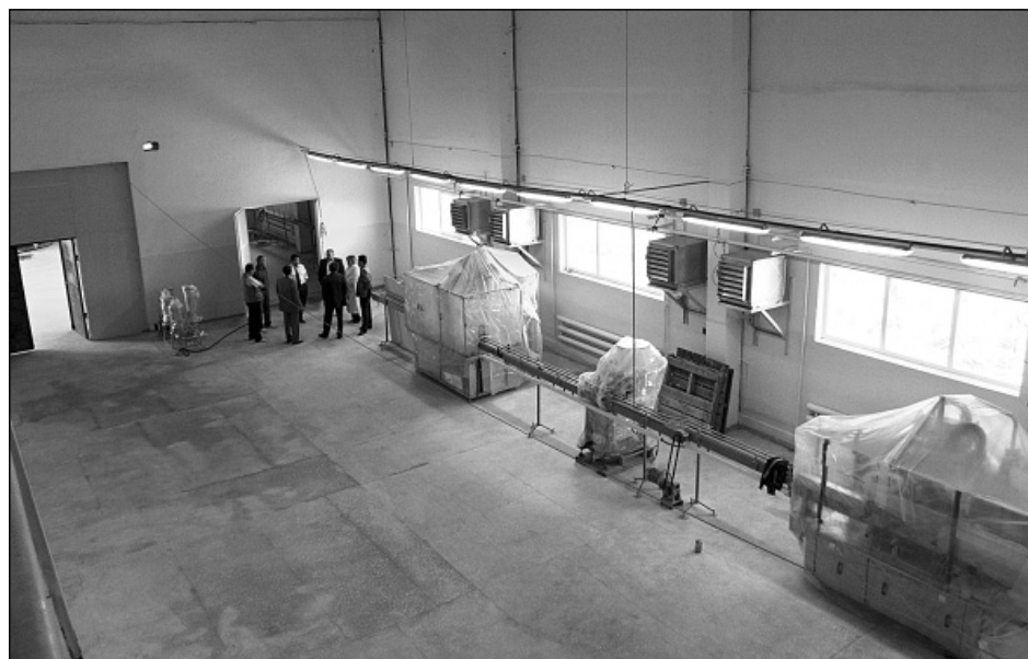
На Тельминской производственной площадке идет реконструкция
