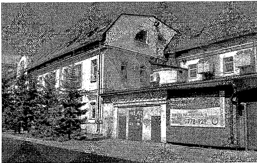
Вид на юго-восточный фасад
