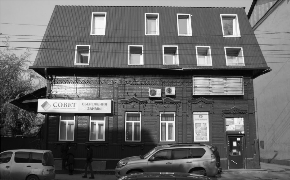
Главный (юго-восточный) фасад
