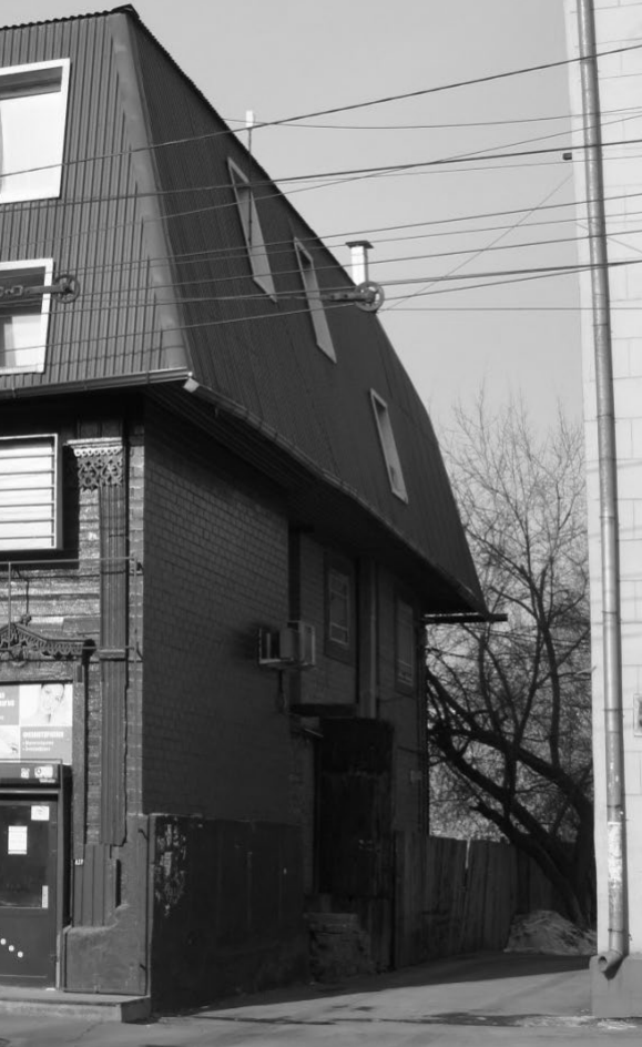
Правый боковой (северо-восточный) фасад
