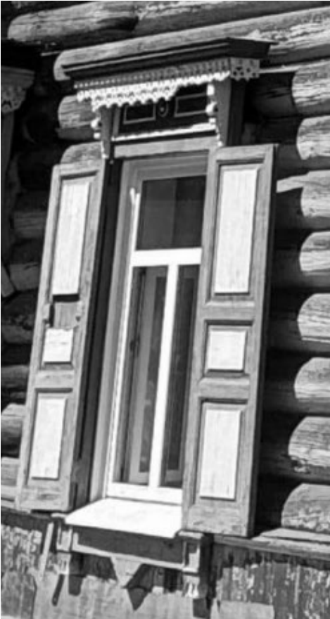
Завершение фасадов Объекта
