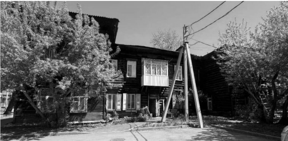
Юго-западный фасад Объекта
