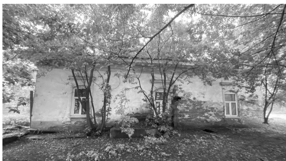
«Лаврентьевская богадельня». Юго-западный боковой фасад
