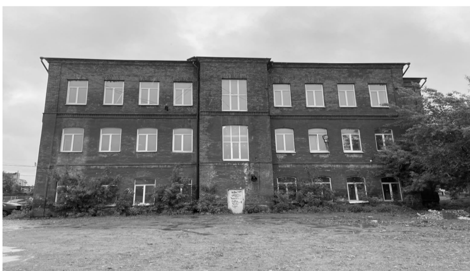
Школа фельдшерц. Дворовой северо-восточный фасад
