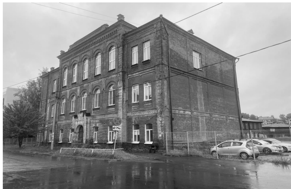
Школа фельдшер. Главный юго-западный и боковой юго-восточный фасады
