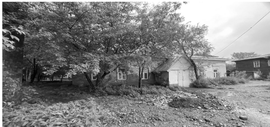
«Лаврентьевская богадельня». Юго-восточный фасад
