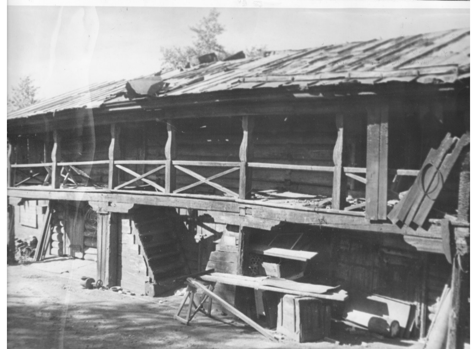
Фото 4 – Юго-западный фасад. Архивные фото, 1974 г.
