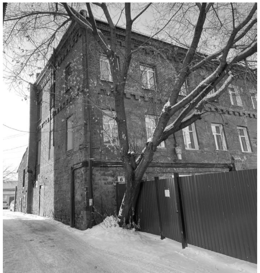
Торцевой фасад юго-западного корнуса.
