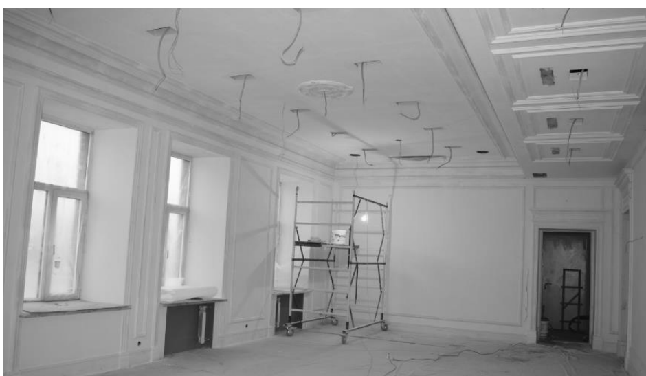
Интерьер в части блока бывш. доходного дома в уровне третьего этажа. Ремонтные работы.
