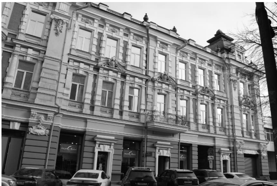
Фрагмент юго-западного фасада здания со стороны ул.Литвинова.
