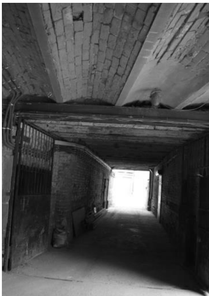
Пространство под блоком галереи-перехода.
