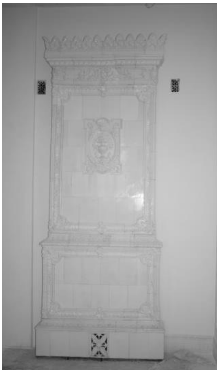
Печь с отделкой из керамического литья, расположенная на третьем этаже в корпусе по ул. К. Маркса.
