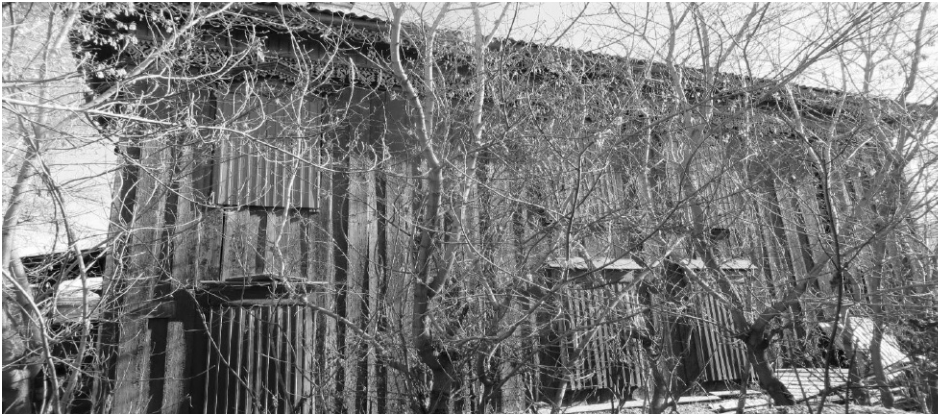
Жилой дом (лит Л). Боковой(северо-западный) фасад.
