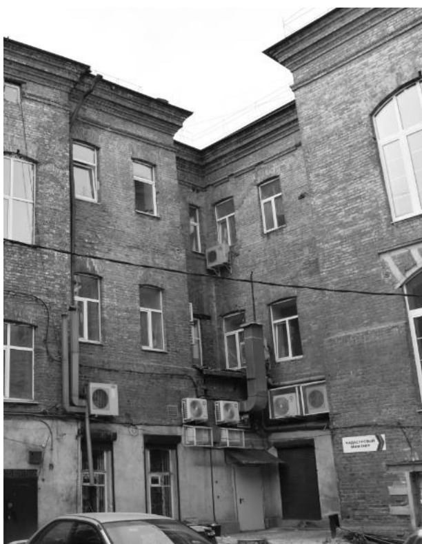
Вид на фрагменты дворовых (северо-восточного и юго-восточного) фасадов здания в части блока бывш.доходного дома.
