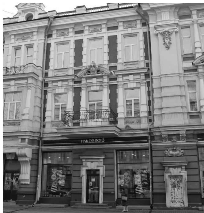
Фрагмент северо-западного фасада здания со стороны ул. К.Маркса.
