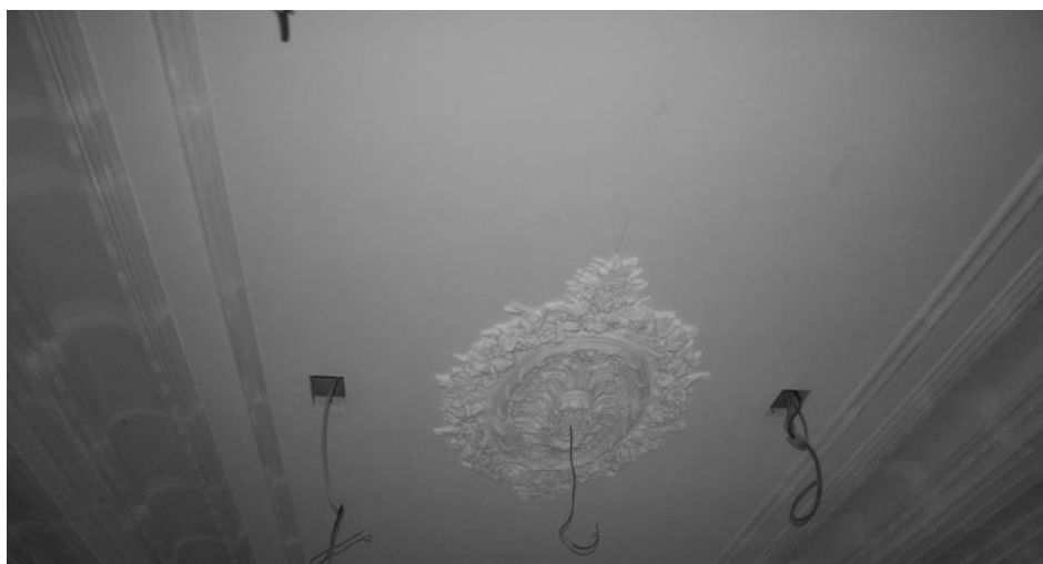
Фрагмент помещения парадных лестниц, расположенных в блоке бывш.доходного дома. Потолок. Ремонтные работы.
