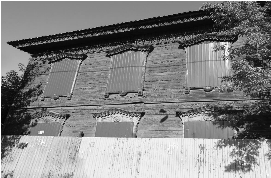
Главный лицевой (юго - западный) фасад дома.
