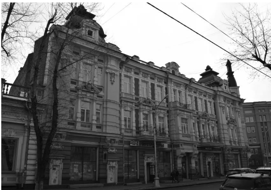
Вид на северо-западный фасад здания со стороны улицы К.Маркса.
