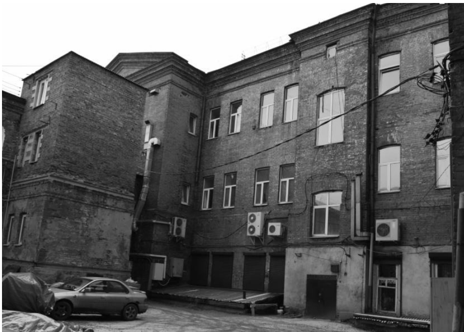
Вид на фрагмент дворового северо-восточного фасада здания в части протяженного корпуса по ул.Литвинова бывш.доходного дома. Слева расположен надстроенный объем (санузлов) блока бывш.флигеля.
