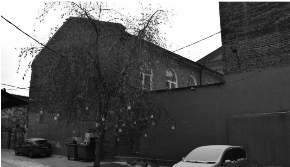
Фрагменты северо-западного и северо-восточного фасадов здания в части блока бывш.флигеля и одноэтажного блока бывш.хоз.постройки.
