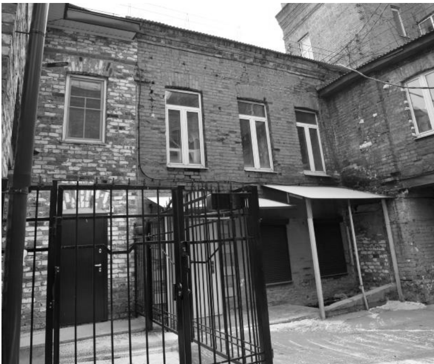
Фрагмент северо-западного фасада здания в части двухэтажного блока бывш.хоз.постройки.
