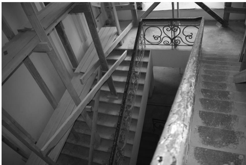
Фрагмент парадной лестницы, расположенной в блоке бывш.доходного дома. Вход на нее организован со стороны улицы Литвинова.
