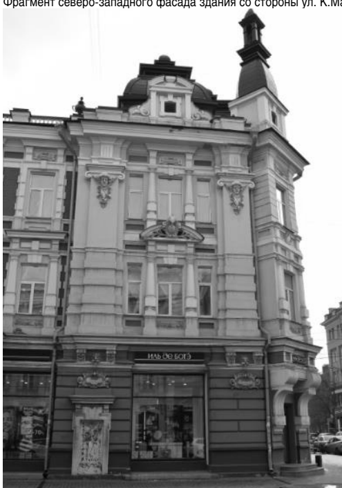
Фрагмент северо-западного фасада здания со стороны ул. К.Маркса.
