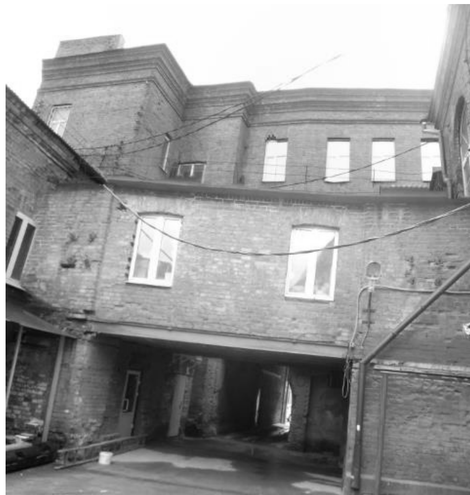
Фрагмент дворового северо-восточного фасада здания. На заднем плане расположен фрагмент протяженного корпуса по ул. Литвинова бывш. доходного дома с арочным проездом, на переднем плане - блок галереи-перехода между двухэтажным блоком бывш. хозяйственной постройки (слева) и блоком бывш. флигеля (справа).
