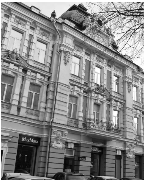
Фрагмент юго-западного фасада здания со стороны ул. Литвинова.
