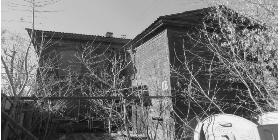
Жилой дом (лит Л). Пониженный пристрой со стороны юго-восточного фасада. Парадный вход с поздним навесом. Боковой (южный) фасад дома.
