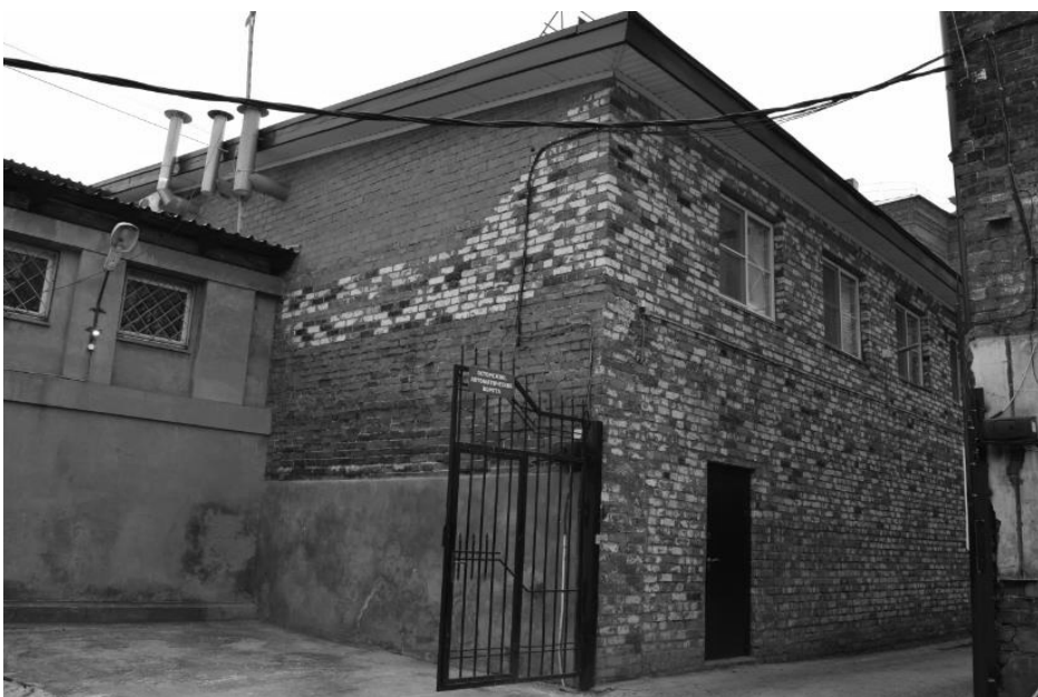
Фрагменты северо-западного и северо-восточного фасадов здания в части высокого одноэтажного блока бывш.пожарного сарая.
