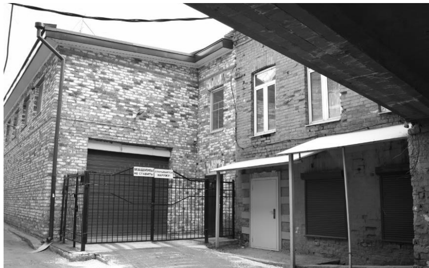
Фрагменты северо-западного и юго-западного фасадов здания в части высокого одноэтажного блока бывш.пожарного сарая и двухэтажного блока бывш.хоз.постройки.
