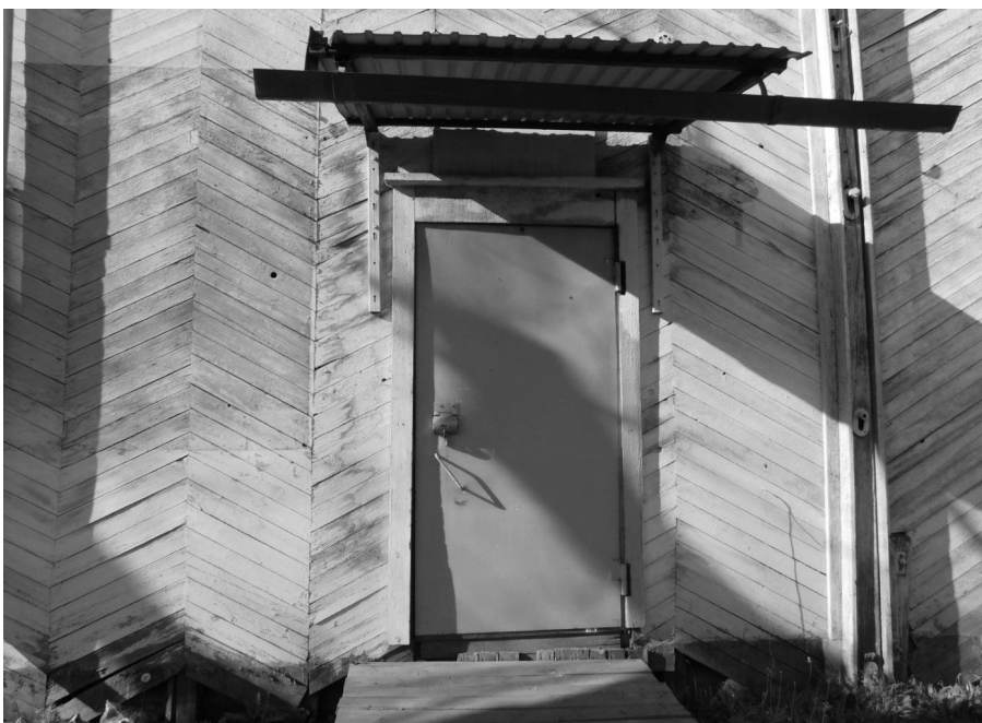
Фото 23 - Фрагмент бокового (южного) фасада. Наружная дверь
