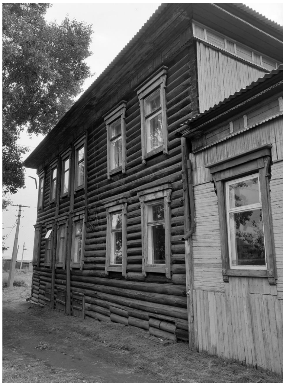
Фото 12 - Боковой (северный) фасад
