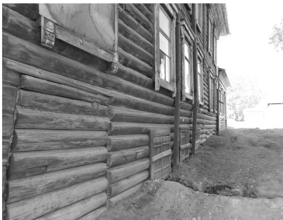
Фото 19 - Фрагмент бокового (северного) фасада. Оконные проемы подклетного этажа
