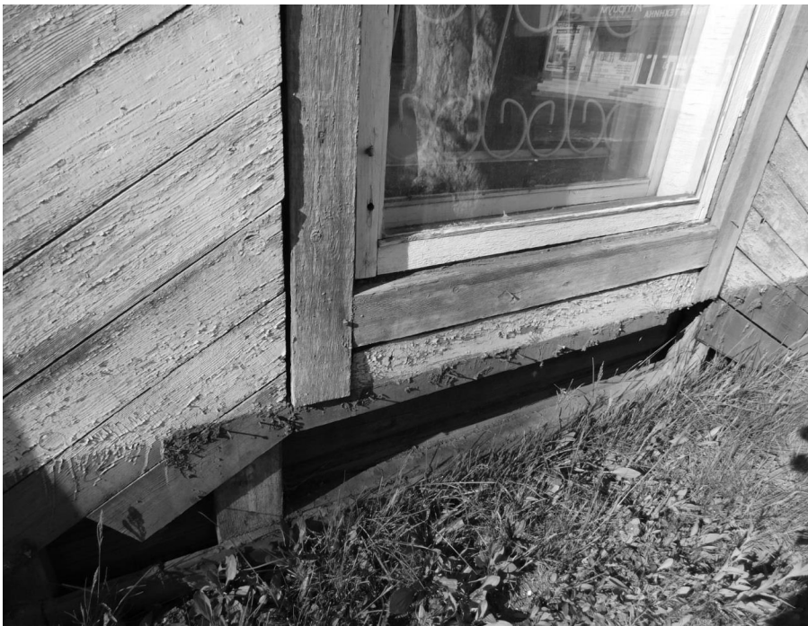
Фото 22 - Фрагмент бокового (южного) фасада. Наличники окон
