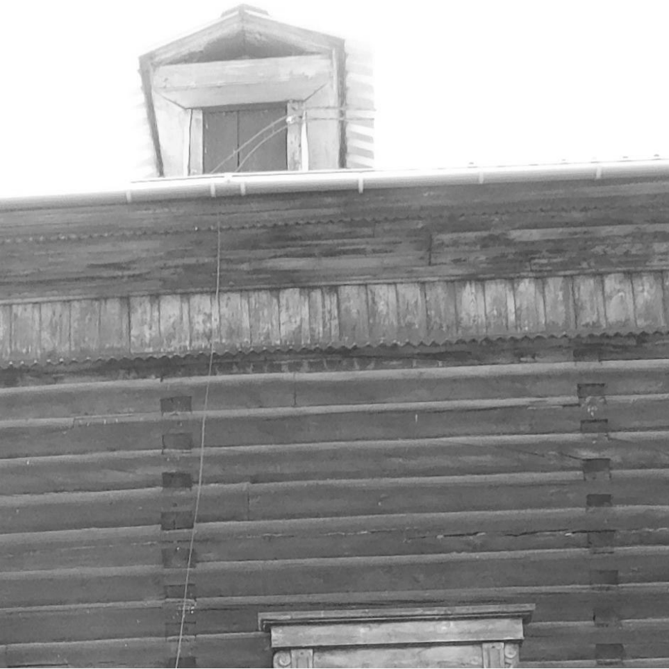
Фото 32 - Фрагмент дворового (восточного) фасада. Слуховое окно.
