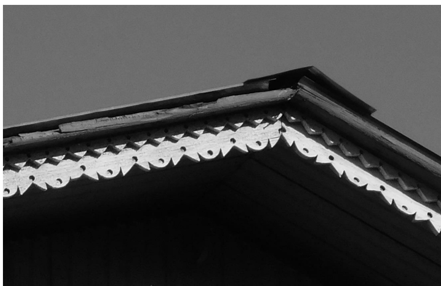
Фото 10 - Фрагмент лицевого (западного) фасада. Декоративное оформление: карниз.
