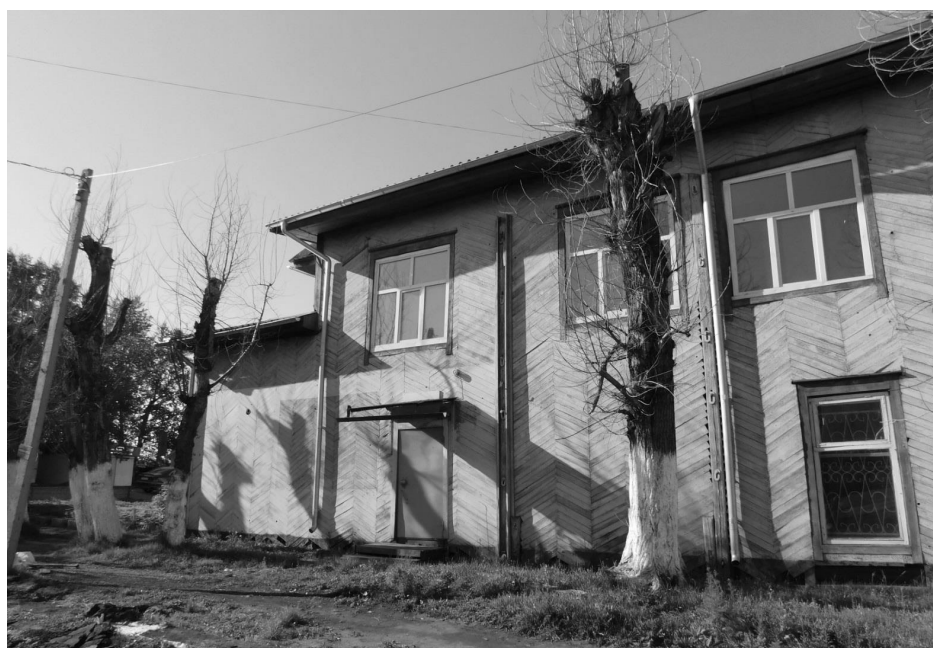
Фото 21 - Фрагмент бокового (южного) фасада.
