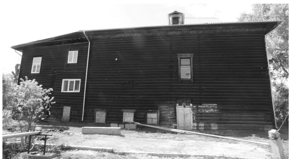
Фото 26 - Дворовой (восточный) фасад
