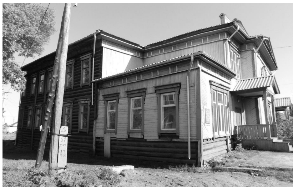
Фото 13 - Боковой (северный) фасад
