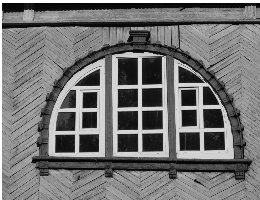
Фото 6 - Фрагмент главного (западного) фасада. Наличники арочного окон.
