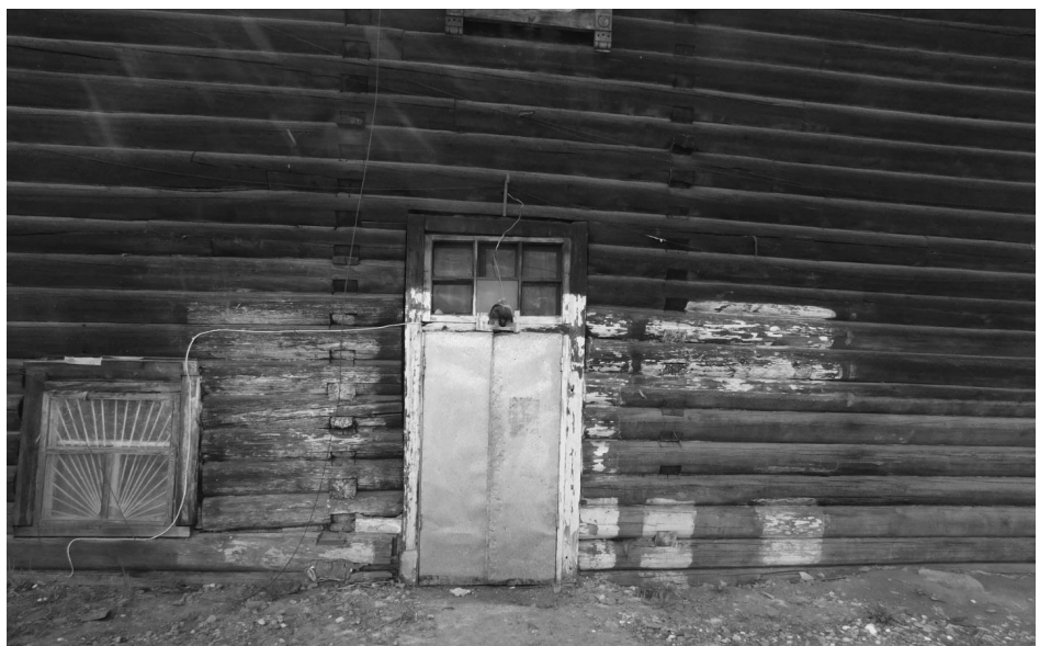
Фото 28 - Фрагмент дворового (восточного) фасада. Выход из подклетного этажа.
