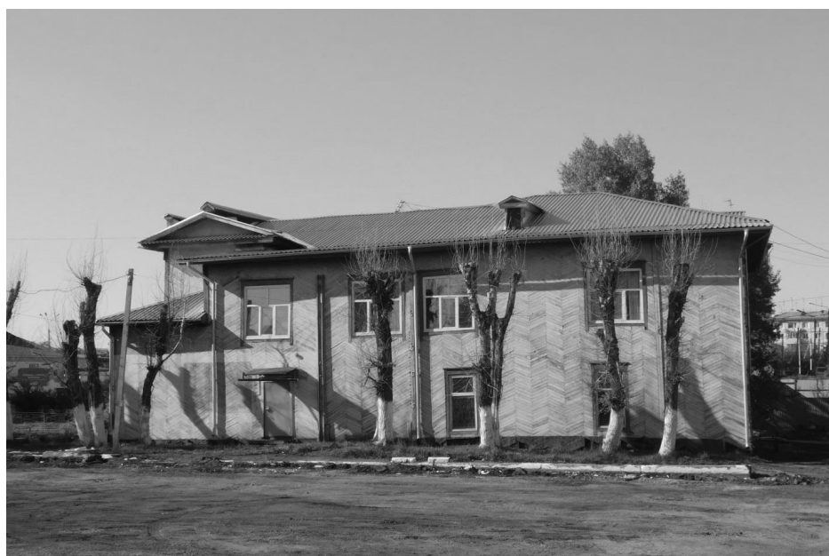
Фото 20 - Боковой (южный) фасад.
