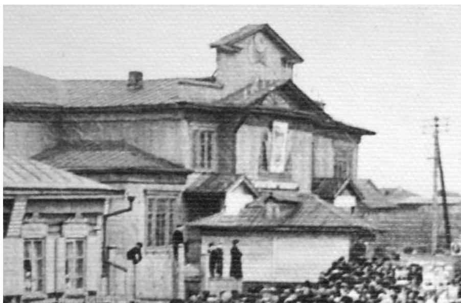
Фото 11 - Общий вид на здание с ул. Володарского.
