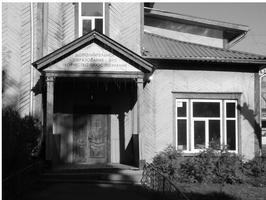
Фото 8 - Фрагмент главного (западного) фасада. Наружные двери.
