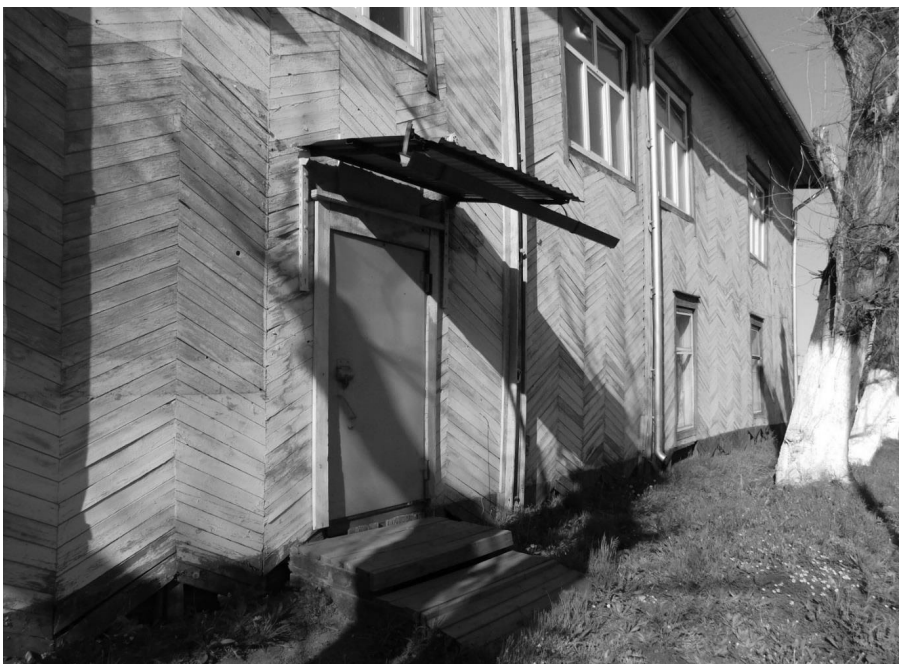
Фото 24 - Фрагмент бокового (южного) фасада.
