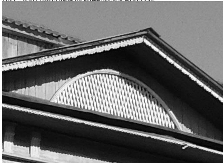
Фото 7 - Фрагмент главного (западного) фасада. Арочное слуховое окно.
