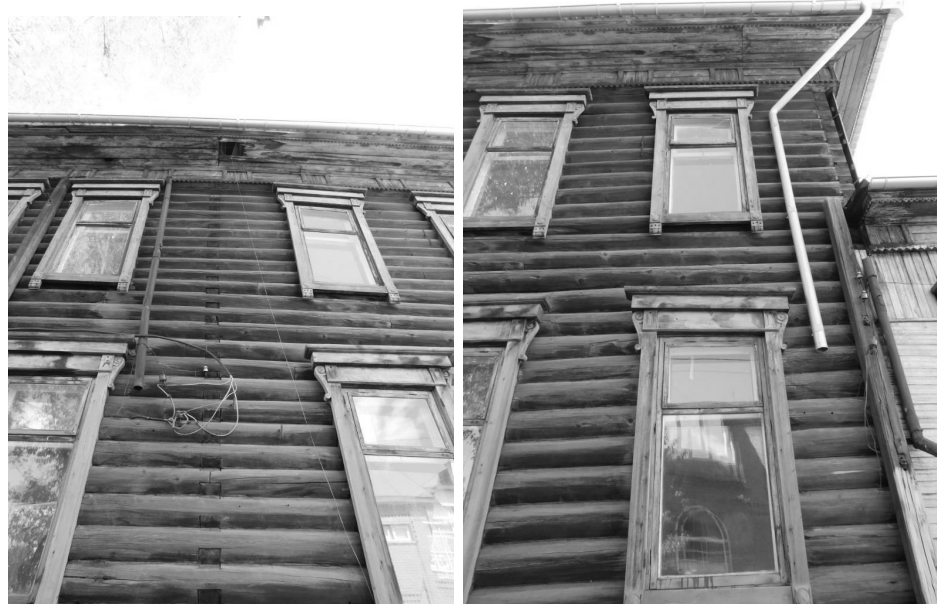
Фото 14 - Фрагмент бокового (северного) фасада. Оконные проемы, наличники, расстекловка.
