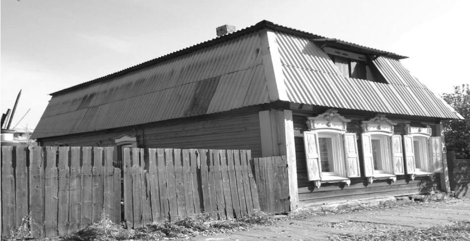
Боковой (северный) фасад дома.
