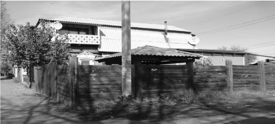
Боковой (южный) фасад дома.
