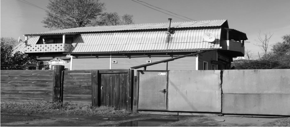
Боковой (южный) фасад дома.
