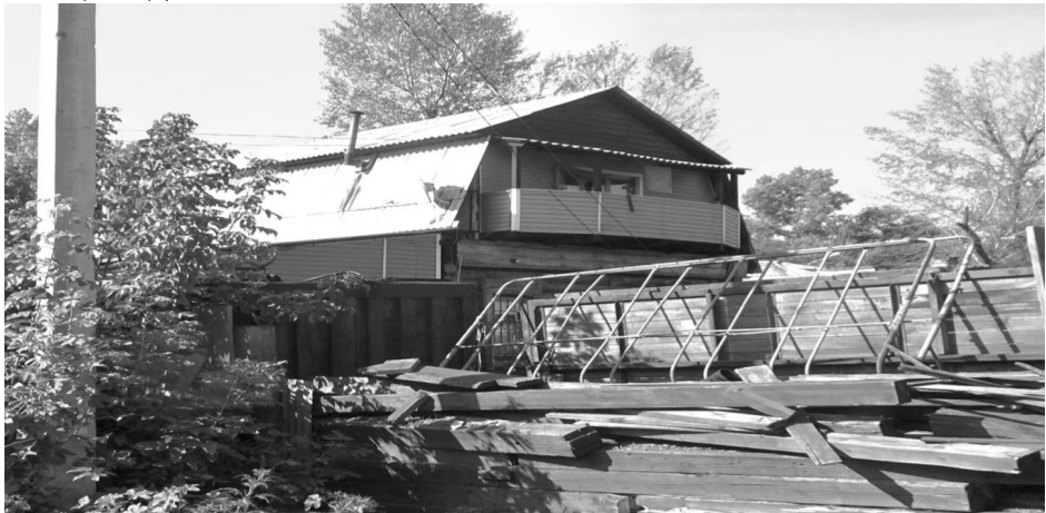
Дворовый (восточный) фасад дома.
