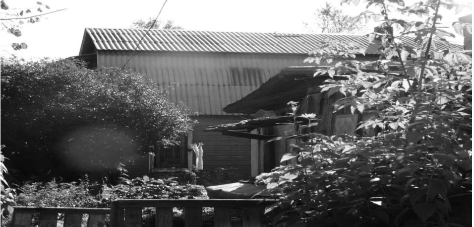
Фрагмент бокового (северного) фасада дома.
