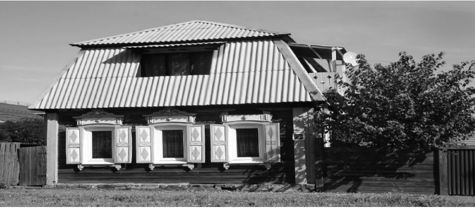
Главный лицевой (западный) фасад дома.
