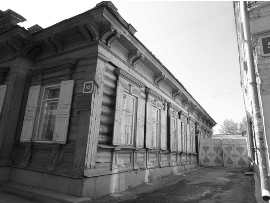
Лит. Б. Фрагмент бокового (северо-западного) фасада.
