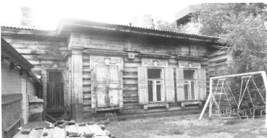
Фото 4 - Вид на боковой (юго-восточный) фасад со стороны двора
