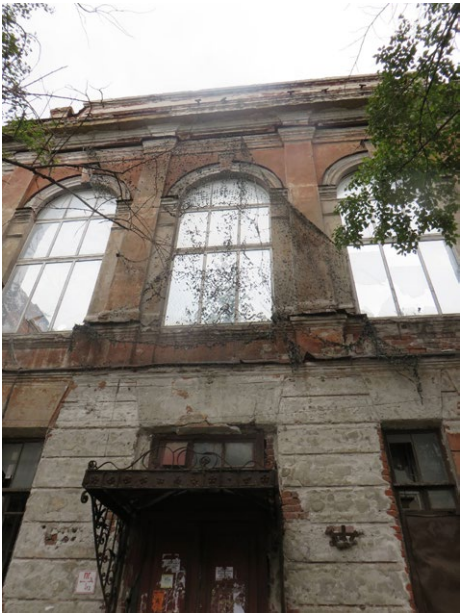
Арочные проемы центральной части главного фасада. Пилыстры, устроенные в простенках.
