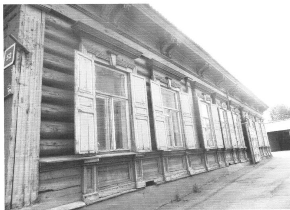
Фото 6 - Вид на боковой (северо-западный) фасад с улицы
