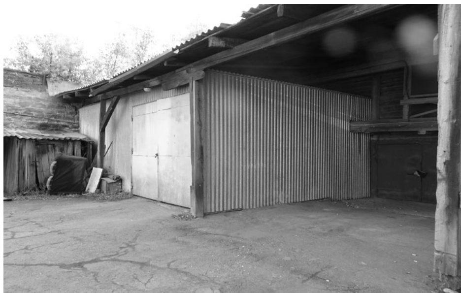
Лит. В. Бревенчатый пристрой с лестницей в подвал, обшитый поздним профлистом.
