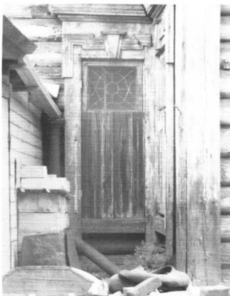
Фото 12 - Узкий оконный проем со стороны бокового (юго-восточного) фасада
