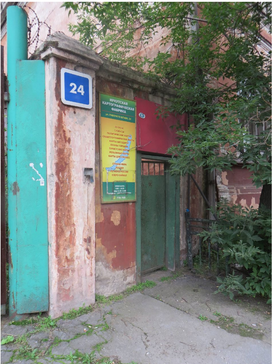
Фрагмент первоначального ограждения.
