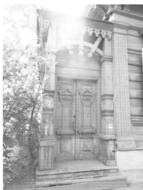
Фото 8 - Прируб парадного входа (лит. 61, 63)
