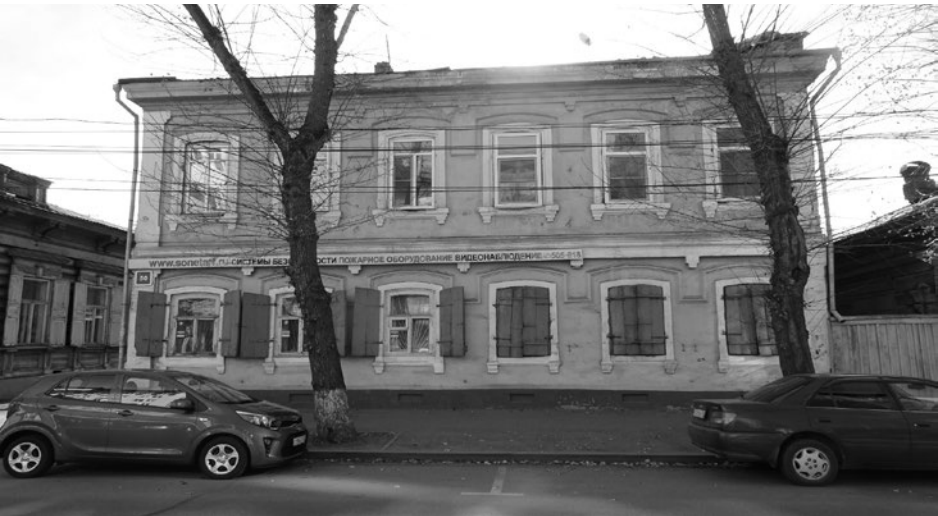
Лит. А. Главный (северо-восточный) фасад. Вид с ул. Декабрьских событий.
