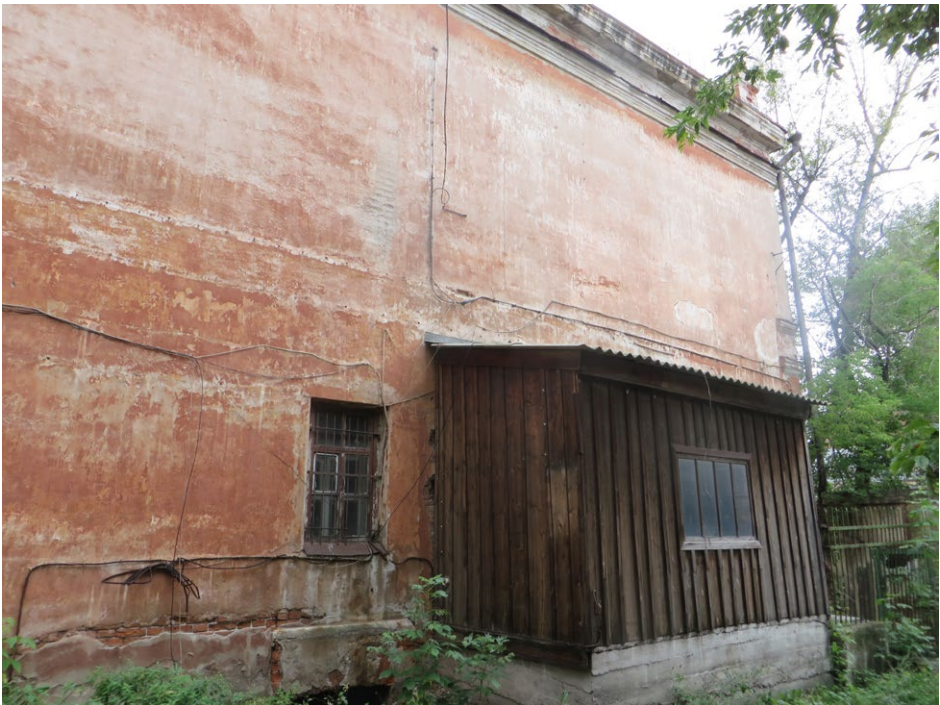
Боковой (северный) фасад.
