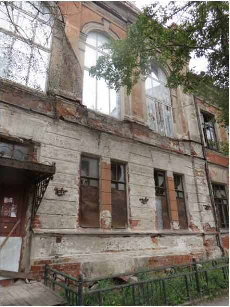
Сдвоенные зауженные проемы в уровне 1 этажа центральной части фасада.
