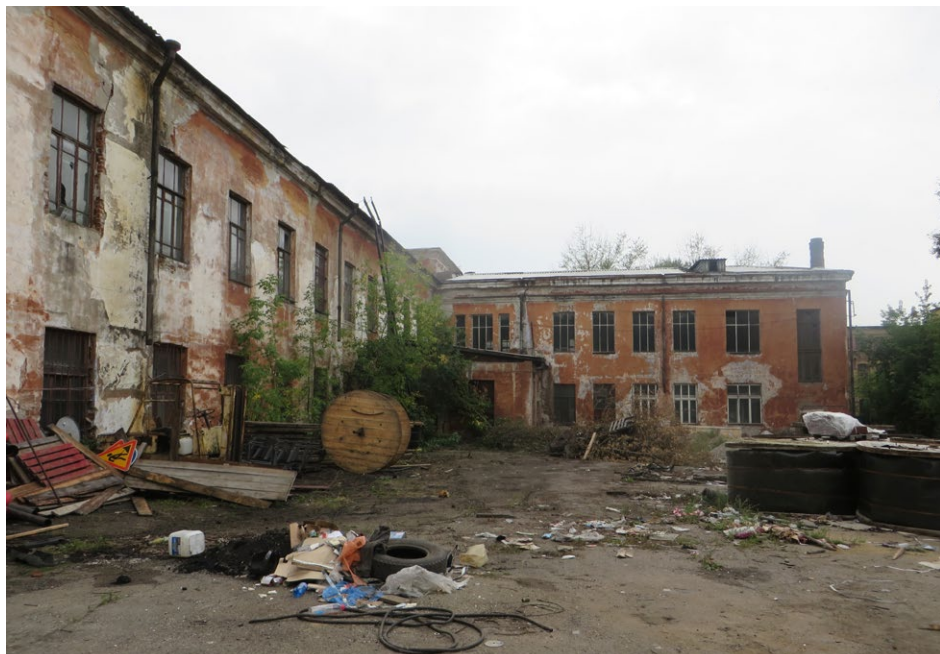
Общий вид со двора. Правый фланг восточного фасада. Боковой (северный) фасад дворового объема.
