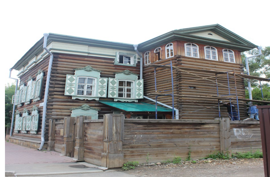
Боковой (северо-западный) фасад.
