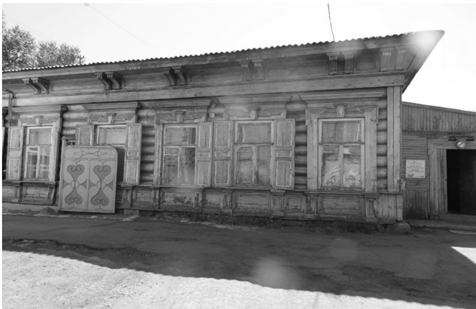
Лит. Б Фрагмент бокового (северо-западного) фасада.
