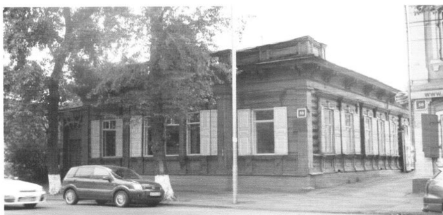
Фото 2 - Вид на главный (северо-восточный) фасад жилого дома (лит. Б)
