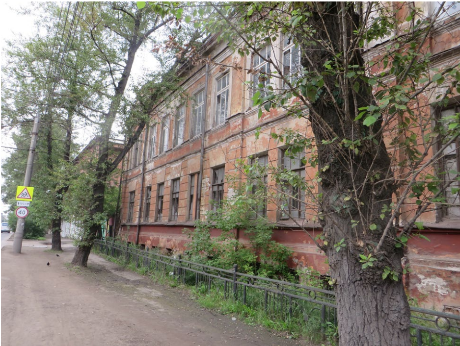
Фрагмент главного фасада. Вид с юга.
