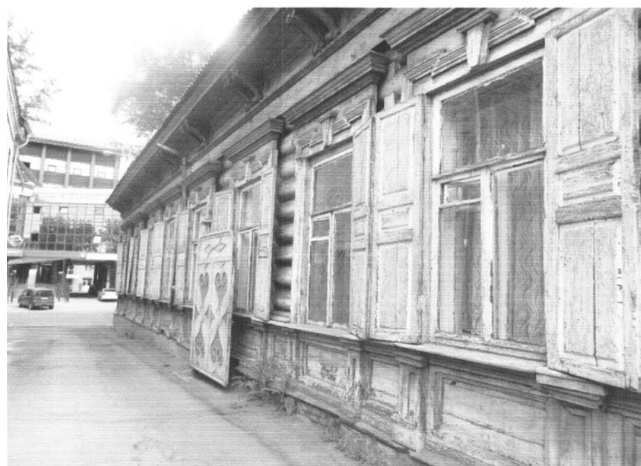
Фото 7 - Вид на боковой (северо-западный) фасад со двора
