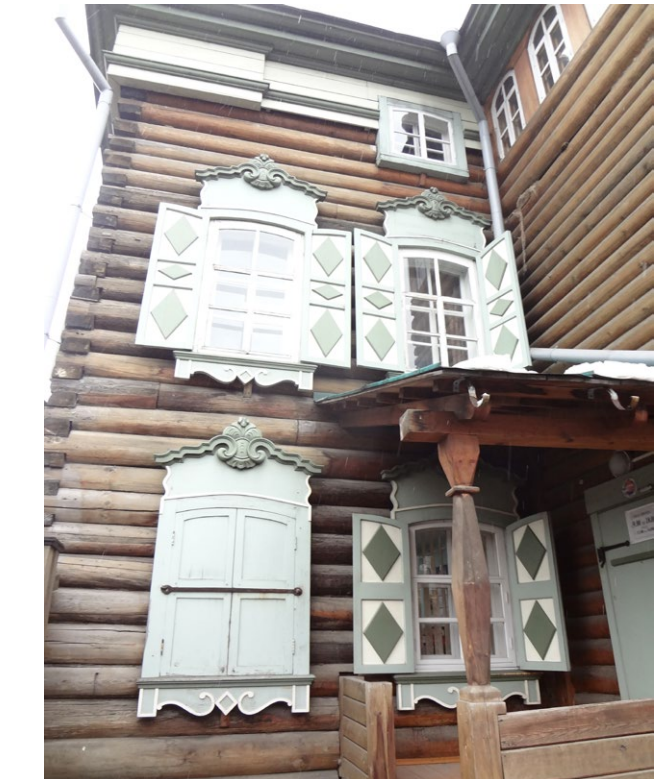
Фрагмент бокового (северо-западного) фасада.
