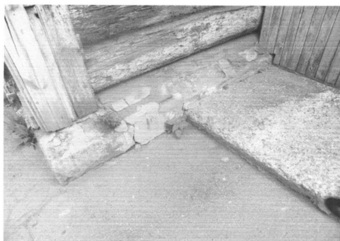
Фото 14 - Фрагмент цоколя и отмостки
