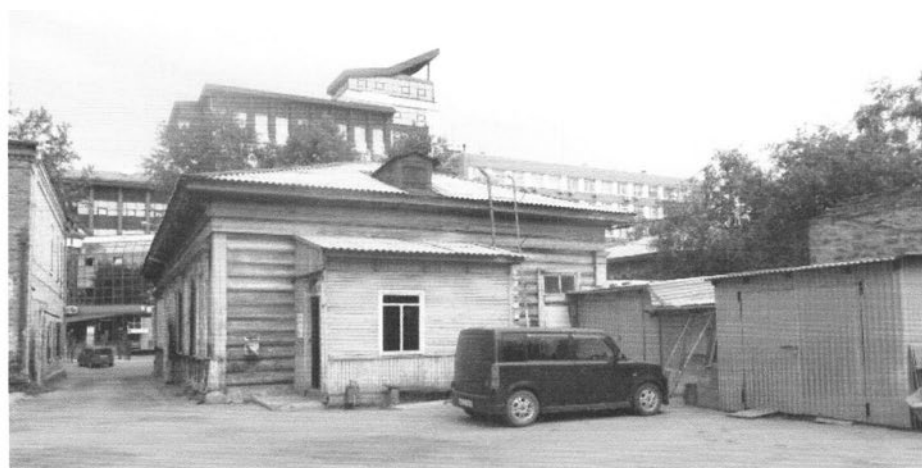
Фото 5 - Дворовый (юго-западный) фасад с поздним входным пристроем
