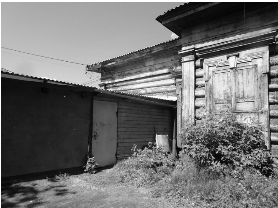
Лит. Б Фрагмент бокового (юго-восточного) фасада.
