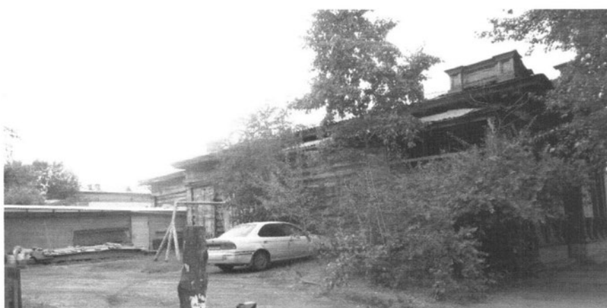
Фото 3 - Вид на боковой (юго-восточный) фасад со стороны улицы
