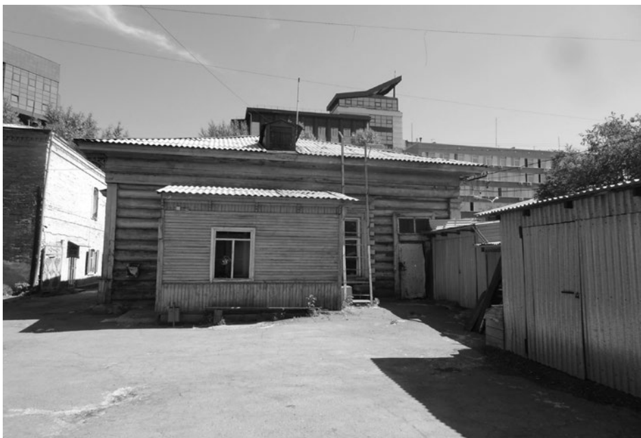
Лит. Б Дворовый (юго-западный) фасад. Поздний брусковый входной пристрой.
