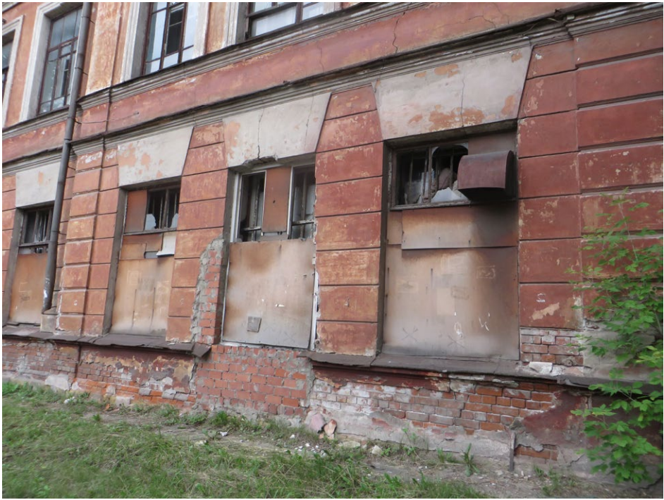
Фрагмент главного фасада в уровне 1 этажа. Рядовые оконные проемы. Цоколь.
