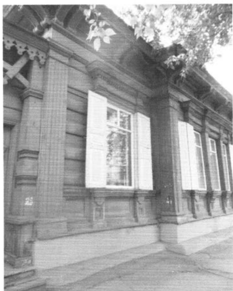
Фото 11 - Наличник бокового, левого оконного проема со стороны главного (северо-восточного) фасада
