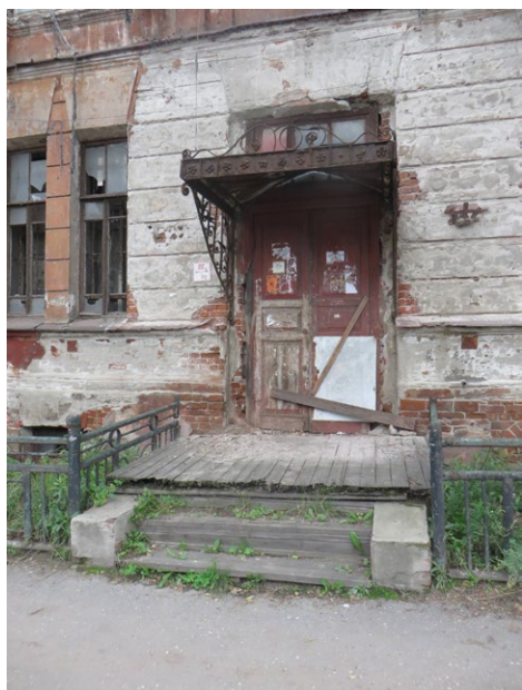
Сдвоенные зауженные проемы в уровне 1 этажа центральной части фасада.
