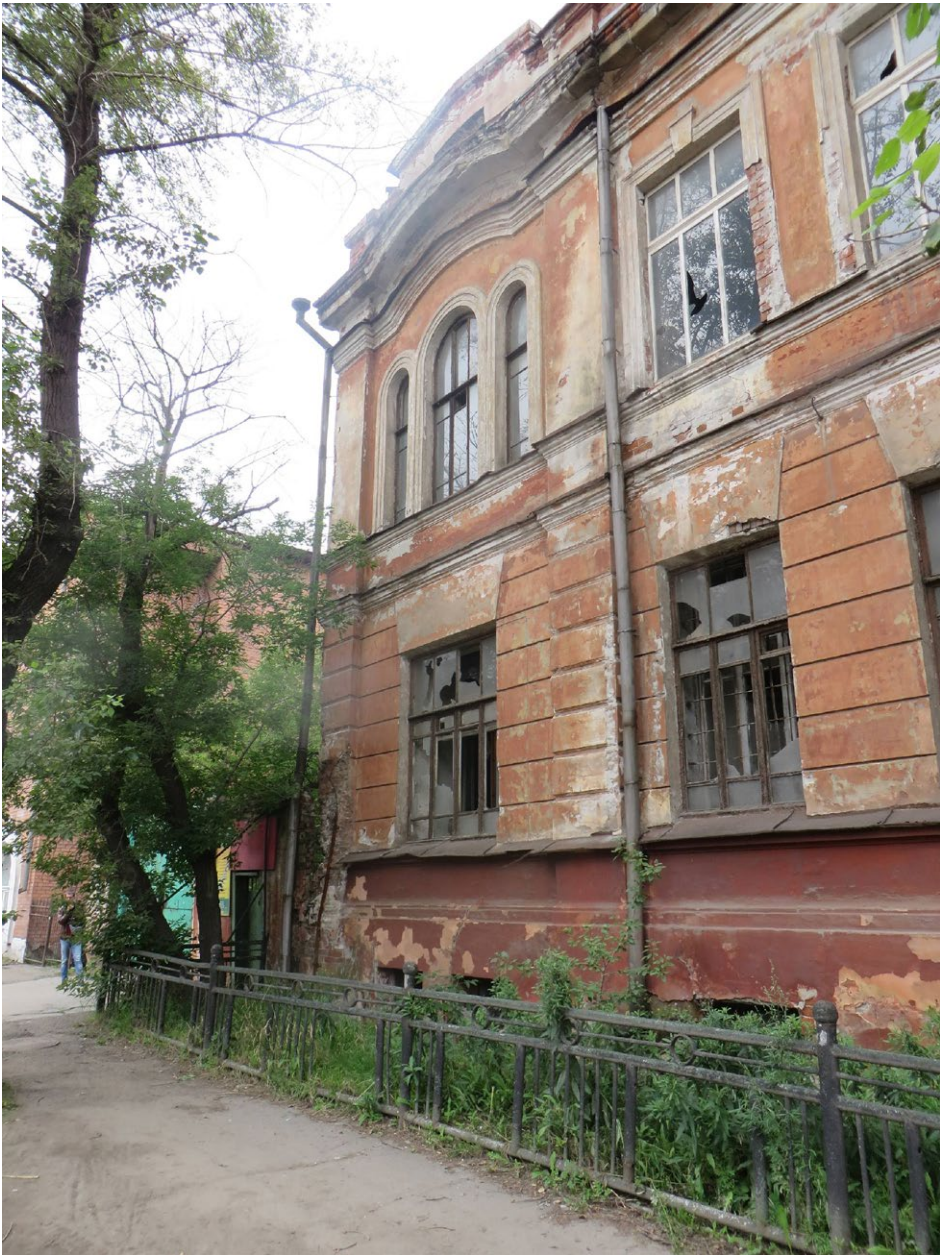
Фрагмент главного фасада – левый фланг.
