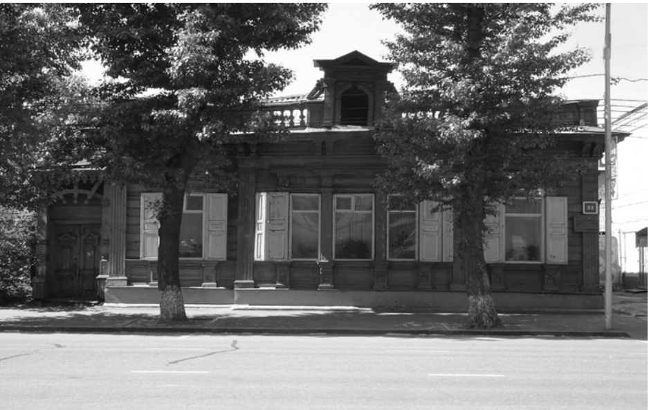
Лит. Б. Главный (северо-восточный) фасад особняка. Вид с ул. Декабрьских событий.
