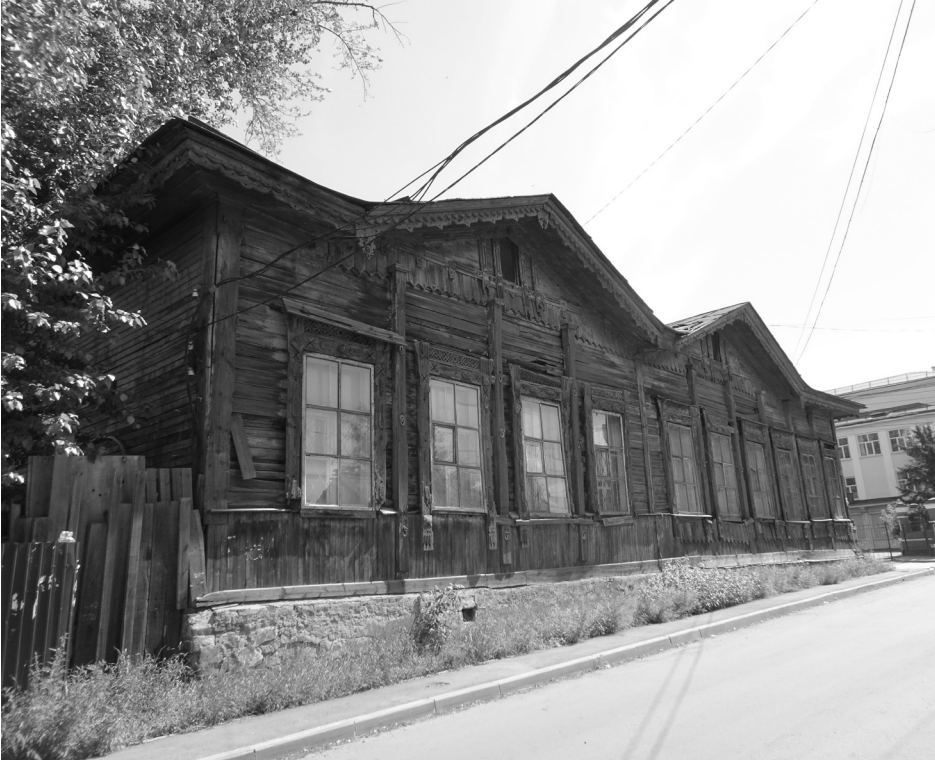
Северо-западный фасад. Вид с северного угла.
