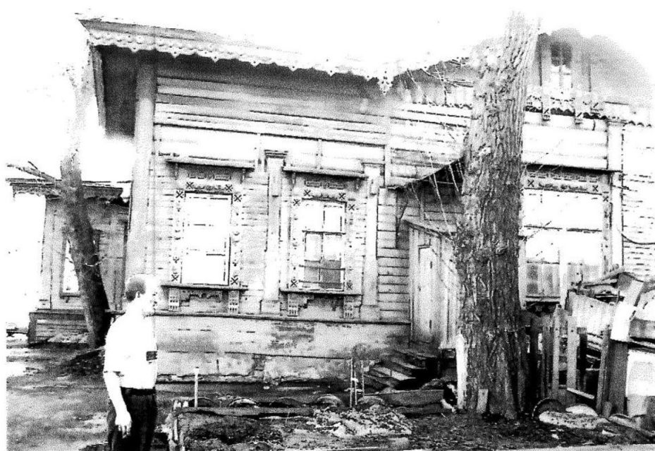
11. г.Иркутск, ул.Баррикад, 81, лит.А Фрагмент северо-восточного (дворового) фасада
