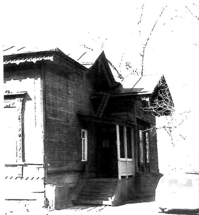
5. г.Иркутск, ул.Баррикад, 81, лит.А Юго-восточный фасад с главным входом, обращенным на ул. Баррикад
