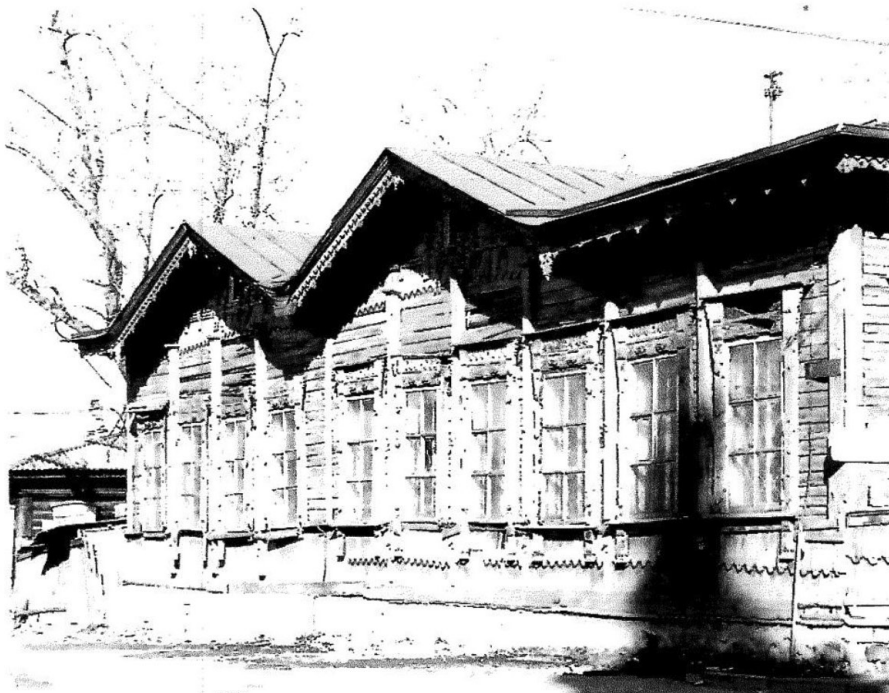
4. г.Иркутск, ул.Баррикад, 81, лит.А Северо-западный фасад, обращенный на пер. Учительский
