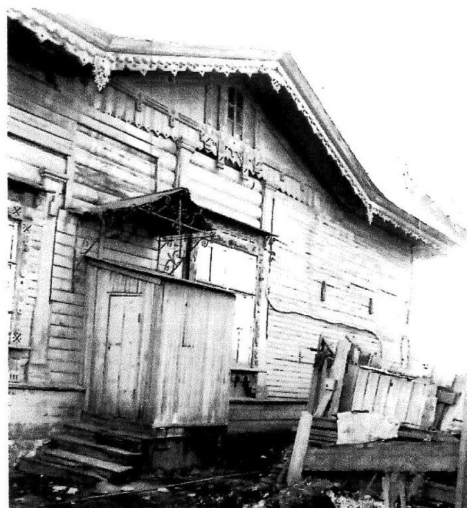
12. г.Иркутск, ул.Баррикад, 81, лит.А Фрагмент северо-восточного фасада
