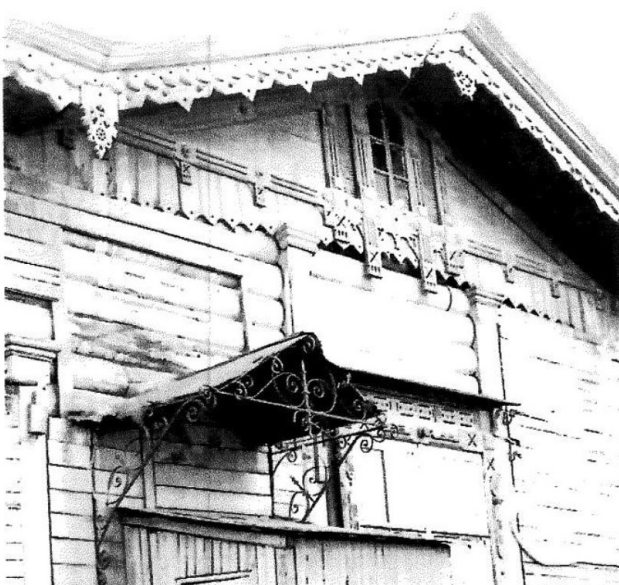
13. г.Иркутск, ул.Баррикад, 81, лит. Северо-восточный фасад, металлический навес с ажурными фронтоном и кронштейнами над дворовым входом
