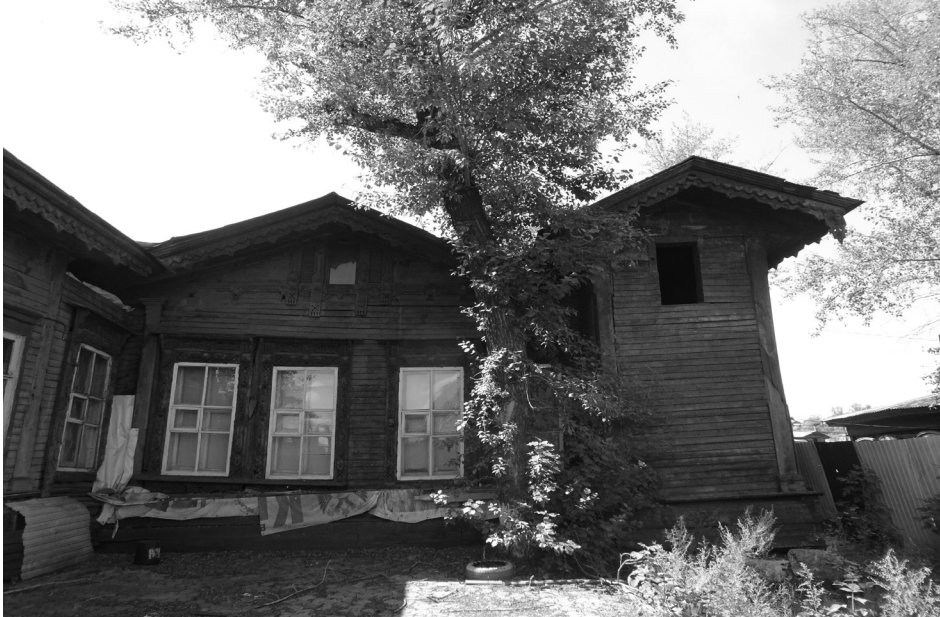
Фрагмент юго-восточного фасада. Правый фланг.
