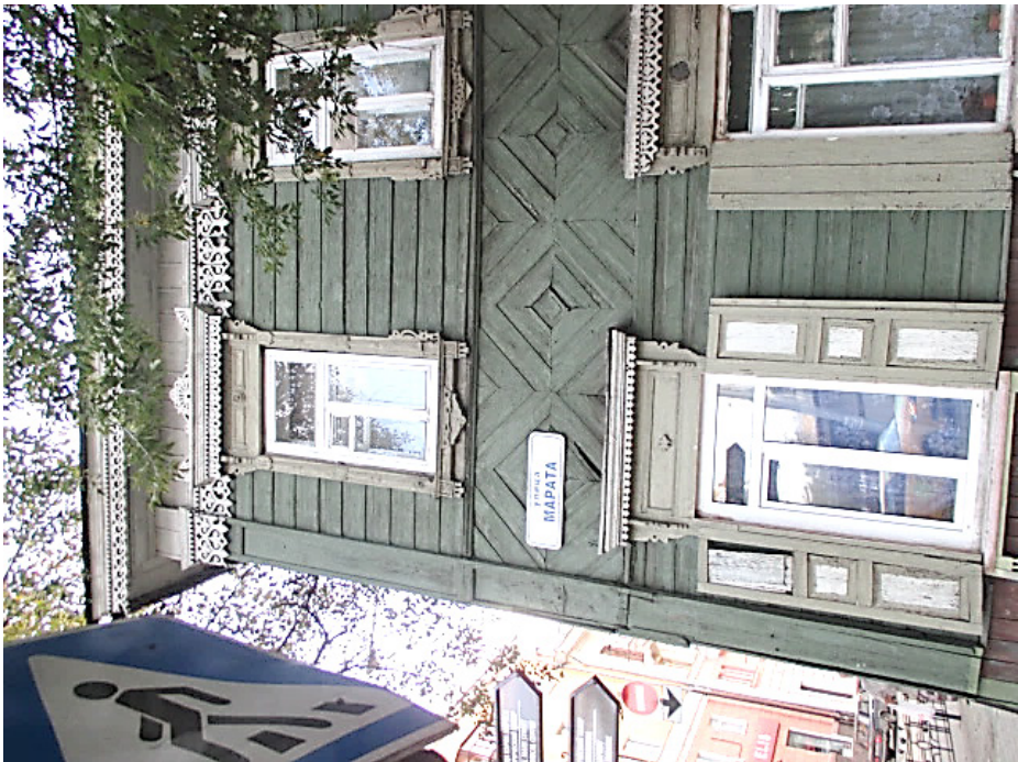
Фото 10 - Фрагмент продольного (юго-западного) фасада жилого дома (лит. А). Щипцовый на плечиках фронтон по центральной оси фасада
