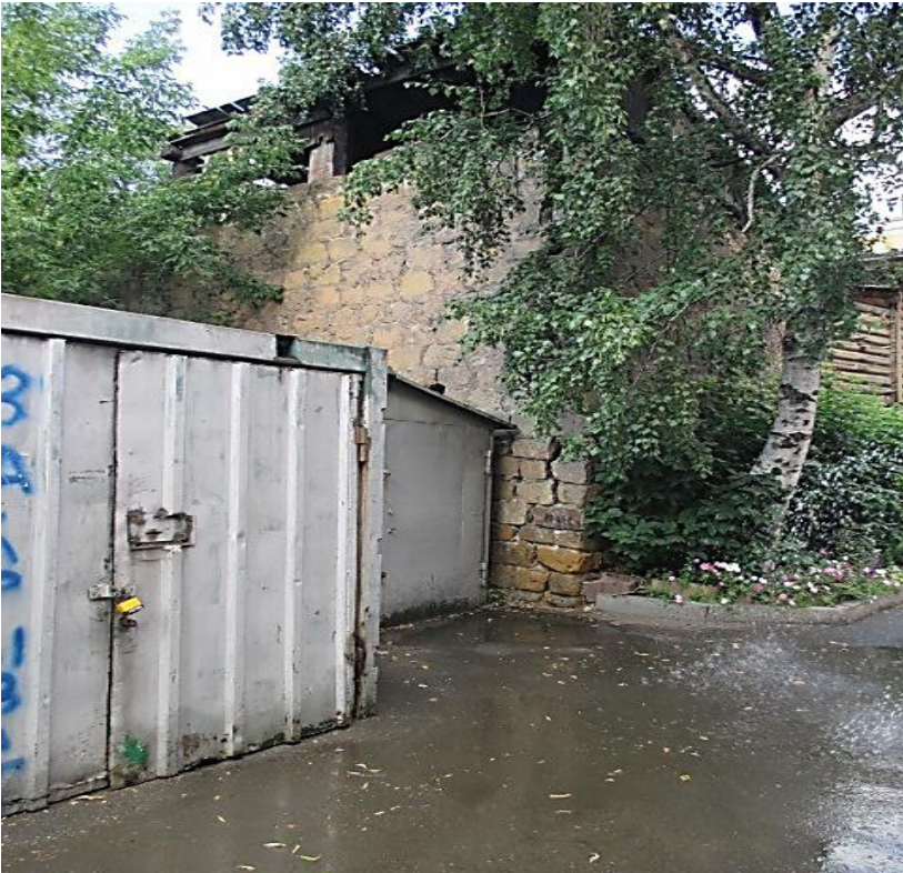
Фото 13 - Фрагмент продольного (юго-восточного) фасада амбара (выезда)
