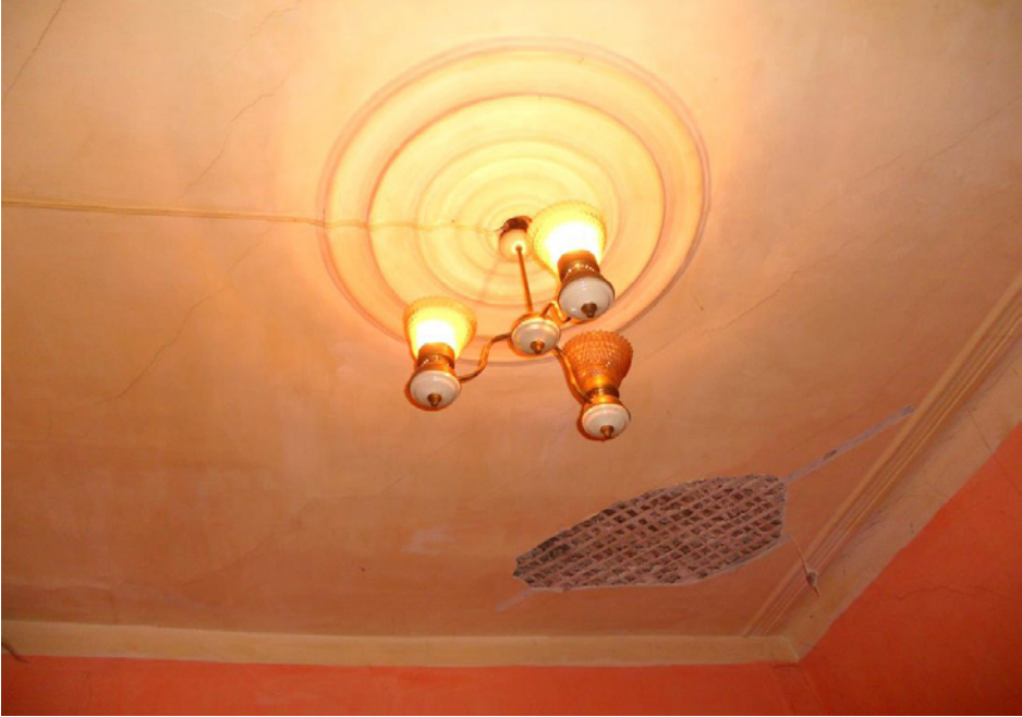
Фото 35 - Фрагмент интерьера жилого дома (лит. А). Потолочные тяги и розетка (архив ЦСН, 2011 г.)
