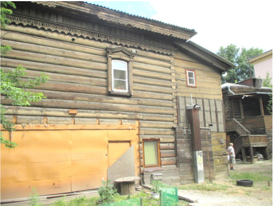
Фото 26 - Фрагмент торцевого, дворового (юго-восточного) фасада жилого дома (лит. А). Место примыкания снесенного позднего пристроя гаража. Поздние дверной и оконный проем в уровне 1-го этажа
