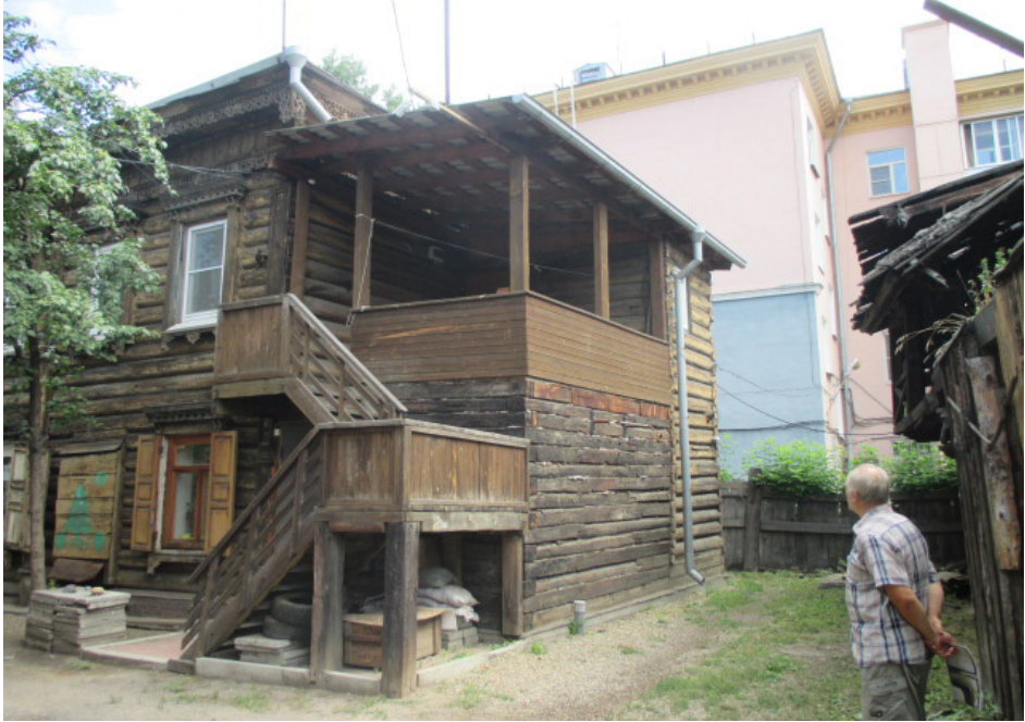
Фото 18 - Торцевой юго-восточный фасад. Перестроенная открытая лестница на 2-ой этаж. Поздний пристрой к прируб туалета
