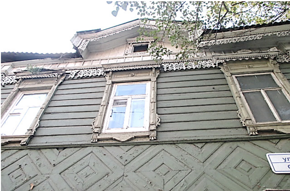
Фото 3 - Фрагмент торцевого (северо-западного) фасада жилого дома (лит. А). Шипцовый на плечиках фронтон по центральной оси фасада
