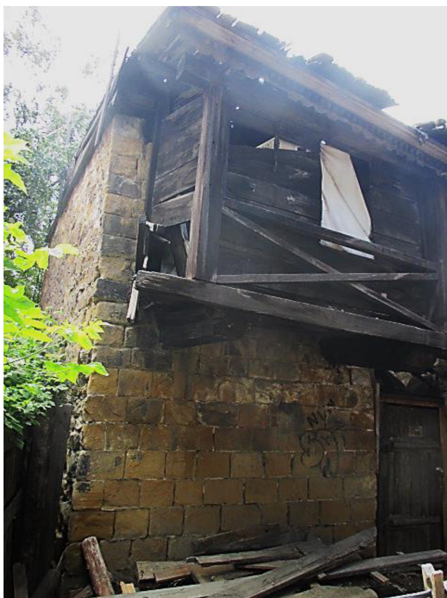
Фото 3, 4 - Фрагменты главного (северо-западного) фасада амбара (выезда). Сохранившийся фрагмент ограждения открытой галереи. Поздний дощатый пристрой на галерее
