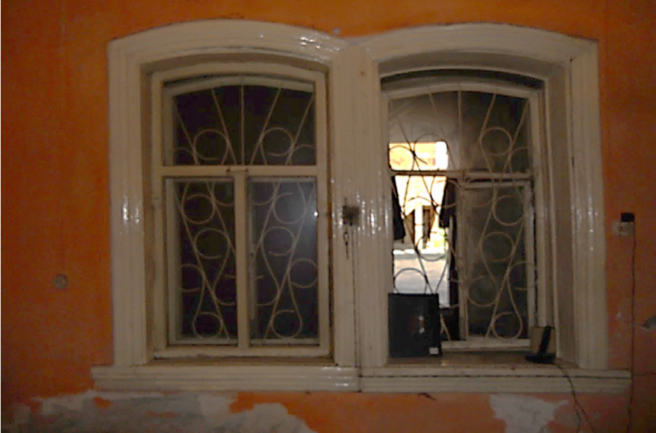
Фото 33 - Фрагмент интерьера жилого дома (лит. А). Сдвоенное окно 1-го этажа, закрытое поздним пристроем в открытой галерее. Внутренние профилированные оконные наличники (архив ЦСН, 2011 г.)
