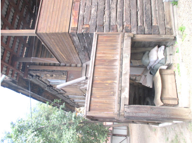
Фото 20 - Торцевой юго-восточный фасад. Перестроенная открытая лестница на 2-ой этаж
