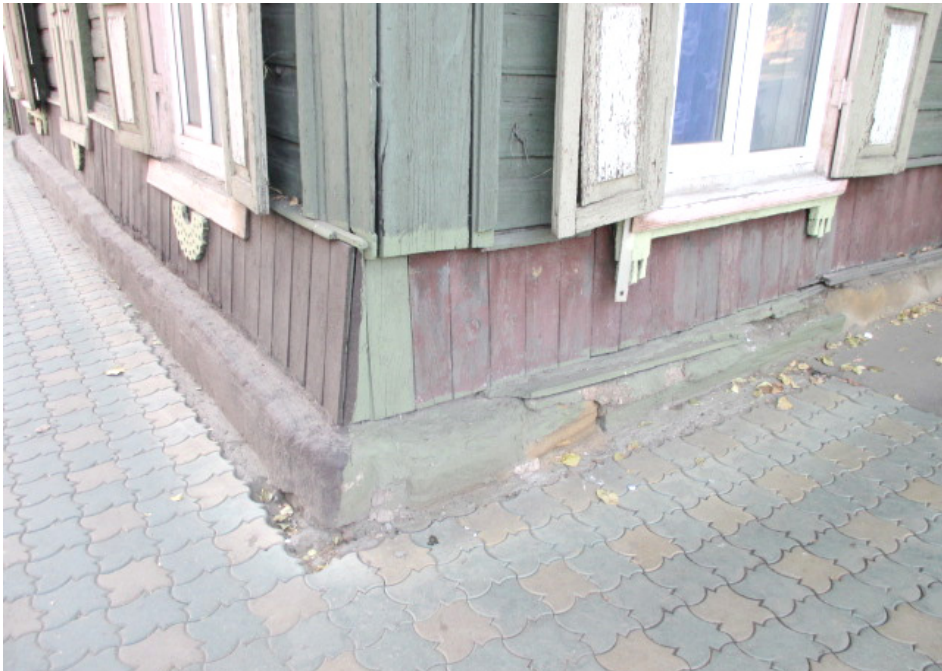
Фото 8 - Фрагмент торцевого (северо-западного) фасада жилого дома (лит. А). Цоколь из блоков песчаника
