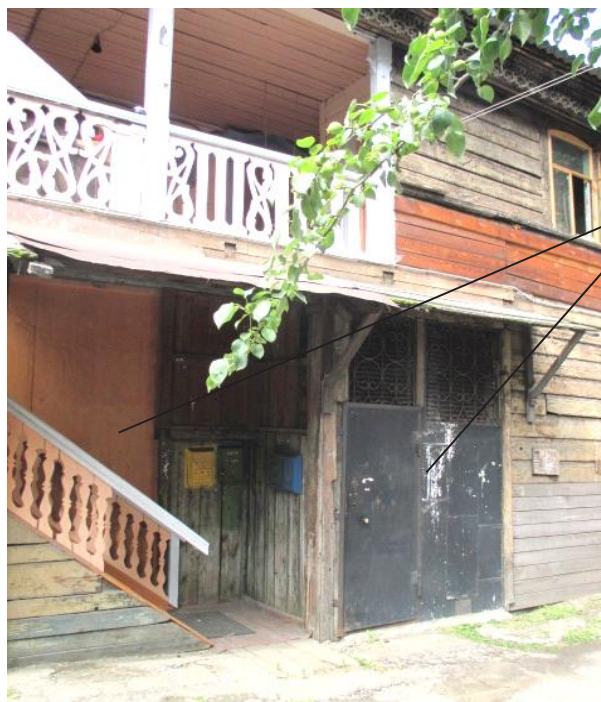
Фото 18. Фрагмент продольного, дворового (северо-восточного) фасада прируба сеней. Поздний дощатый пристрой входа в открытой галерее в уровне 1-го этажа
