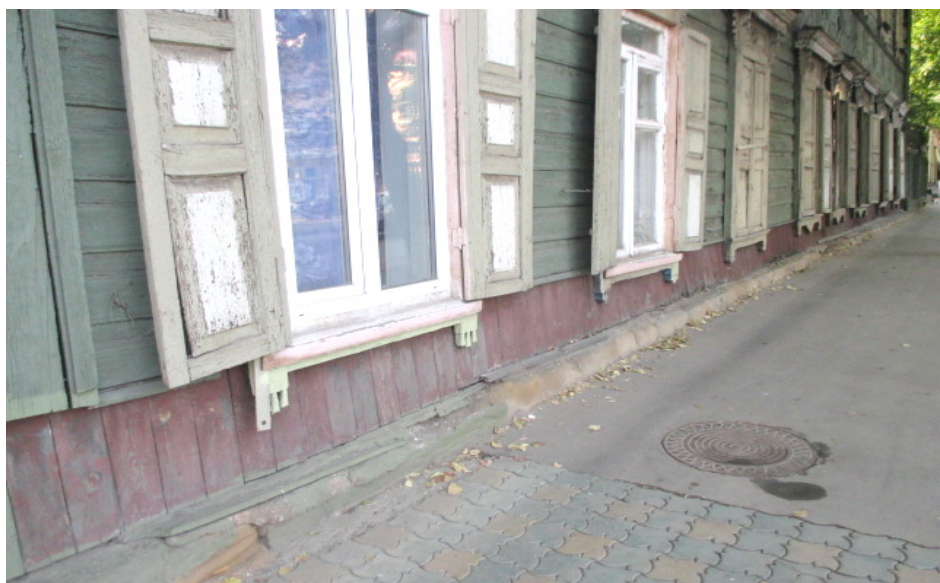
Фото 13 - Фрагмент продольного (юго-западного) фасада жилого дома (лит. А). Цоколь из блоков песчаника
