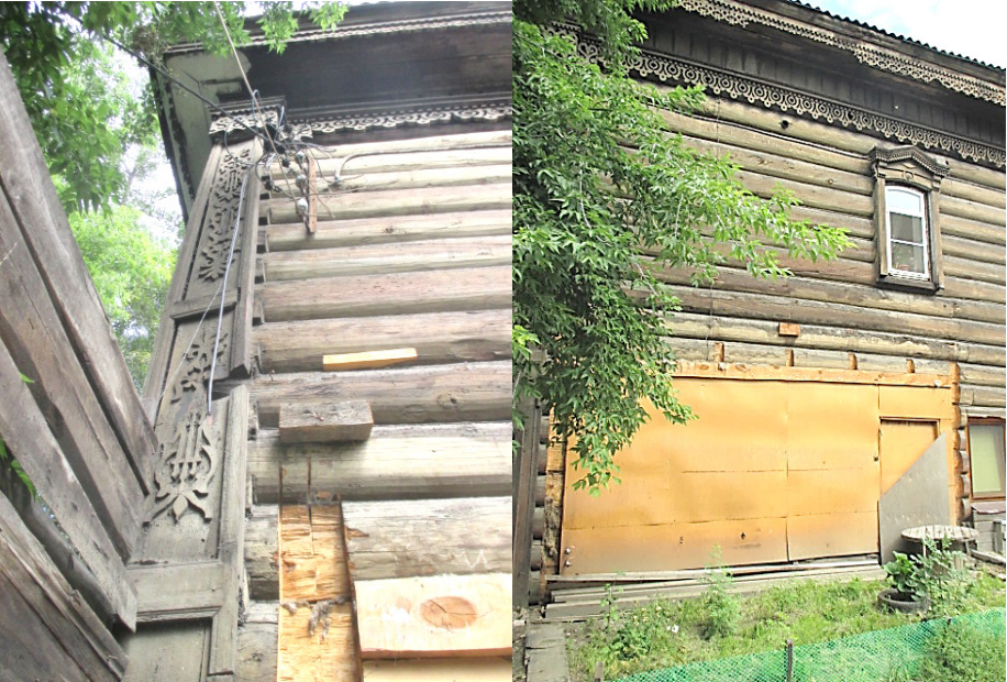
Фото 29, 30 - Фрагменты торцевого, дворового (юго-восточного) фасада жилого дома (лит. А). Основной объем. Огибающая лопатка, фриз, карниз, оконный проем 2-го этажа
