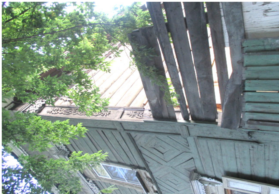
Фото 11, 12 - Фрагменты продольного (юго-западного) фасада жилого дома (лит. А). Огибающие лопатки, фриз, карниз, наличники оконных проемов 1-го и 2-го этажей
