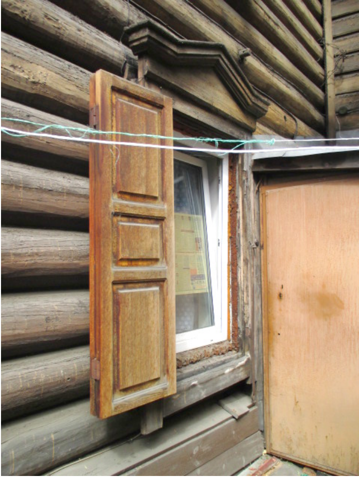
Фото 15 - Фрагмент продольного северо-восточного фасада основного объема. Наличник оконного проема 1-го этажа
