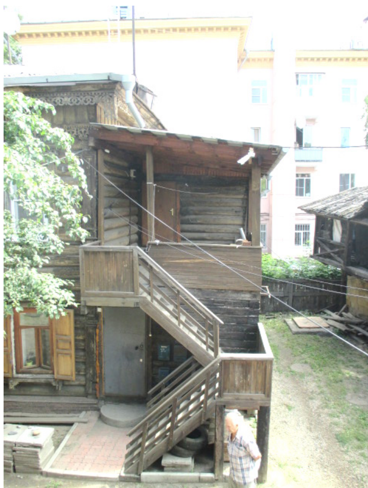
Фото 9 - Торцевой юго-восточный фасад. Перестроенная открытая лестница и поздний пристрой к прирубам туалета
