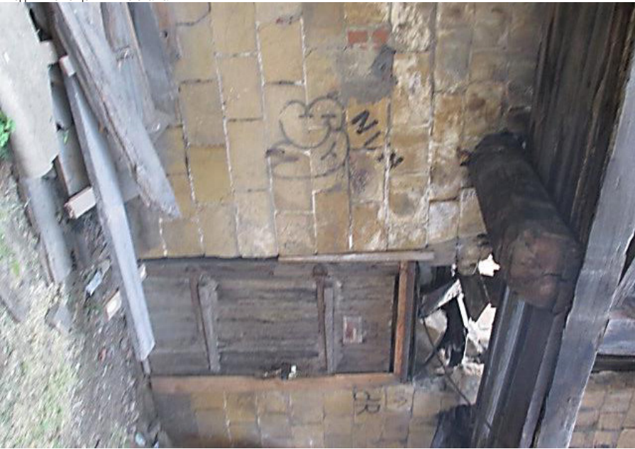
Фото 9 - Фрагмент главного (северо-западного) фасада амбара (выезда). Бревенчатые консоли галереи. Входы в помещения 1-го этажа
