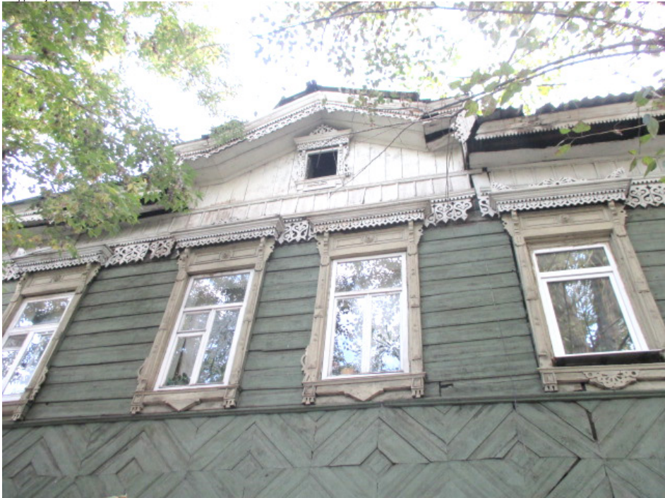
Фото 10 - Фрагмент продольного (юго-западного) фасада жилого дома (лит. А). Щипцовый на плечиках фронтон по центральной оси фасада
