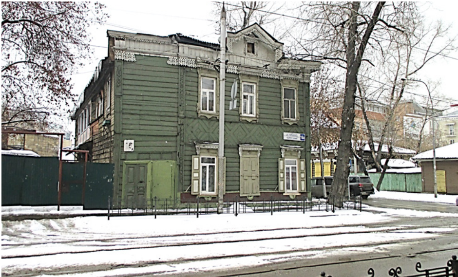
Фото 4 - Фрагмент торцевого (северо-западного) фасада жилого дома (лит. А). Огибающие лопатки, фриз, карниз
