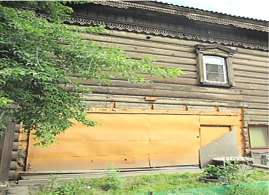
Фото 31 - Фрагменты торцевого, дворового (юго-восточного) фасада жилого дома (лит. А). Основной объем. Место при- мыкания снесенного позднего пристроя гаража
