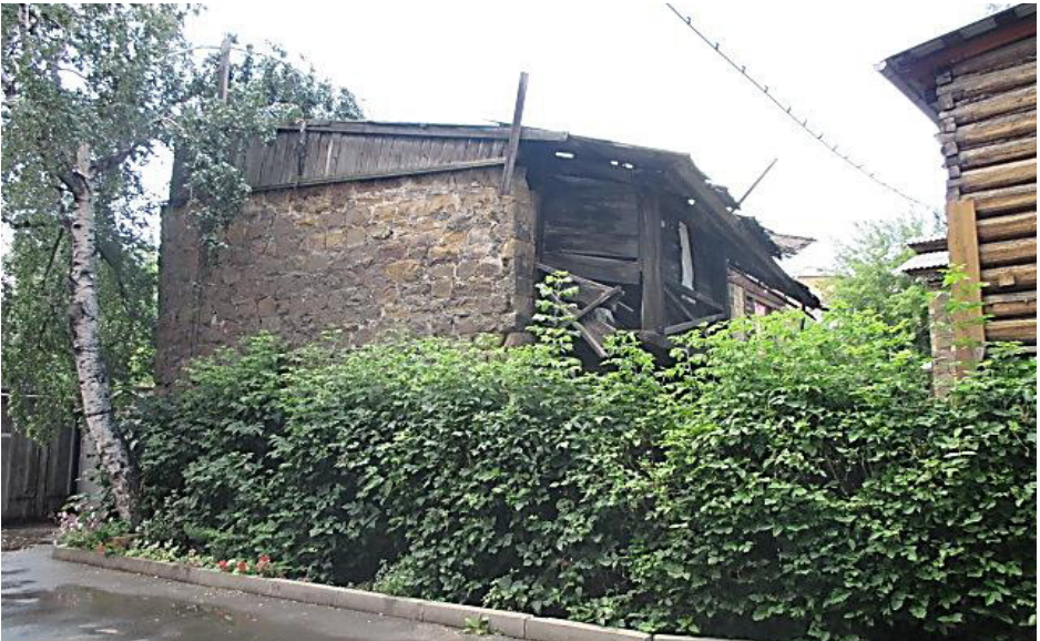
Фото 12 - Боковой (юго-западный) фасад амбара (выезда)
