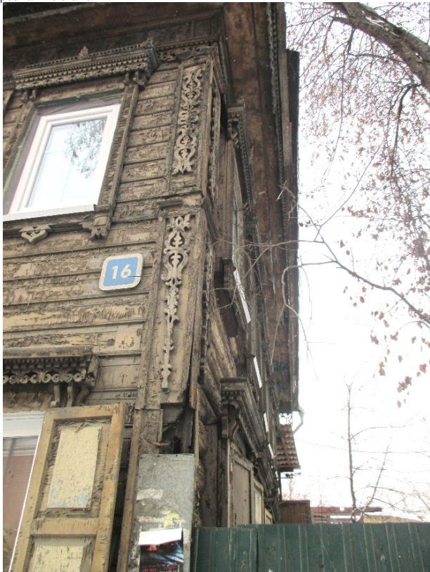
Фото 6 - Фрагмент главного, торцевого фасада. Лопатка, декорированная пропильным декором
