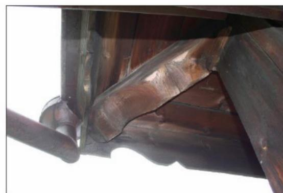
Фото 17. Декоративно оформленный выпуск стропильной ноги и карниз основного сруба.
