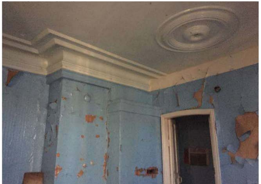
Фото 16. Интерьер. Филенчатые двери, профилированные потолочные тяги, круглая розетка, печь. Адрес: г. Киренск, ул. Ленских Рабочих, 31.
