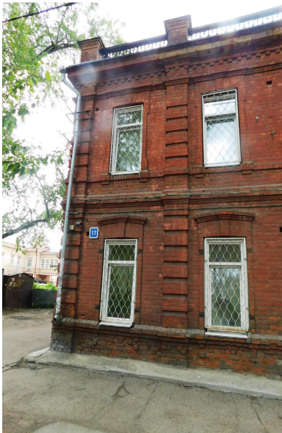
9.Главный, юго-западный фасад. «Ризалит»1.
