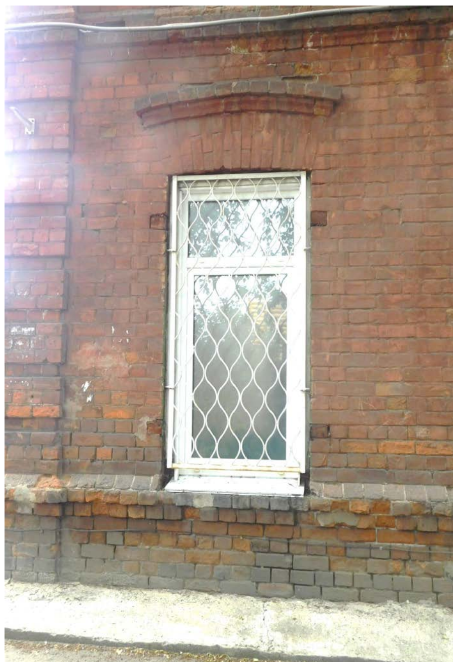
16. Боковой, юго-западный фасад. Оконный проем 1 этажа.
