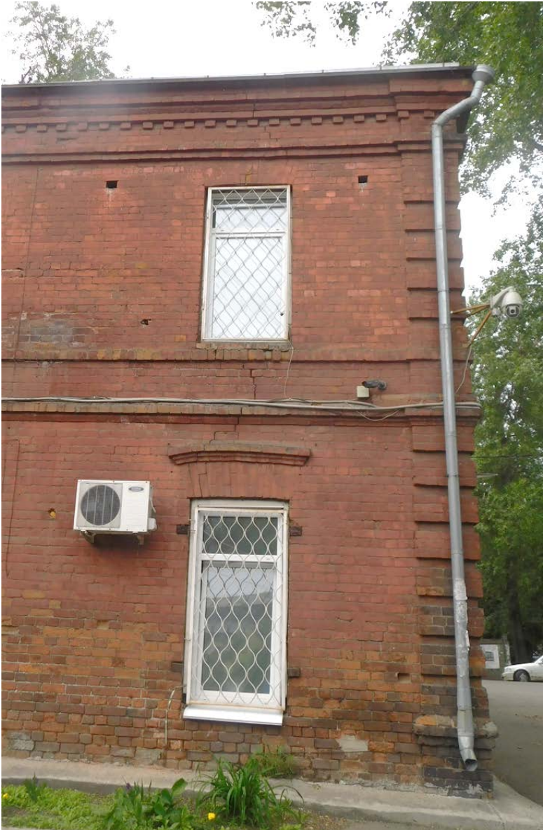
18.Северо-восточный фасад. Оконный проем1,2 этажей.
