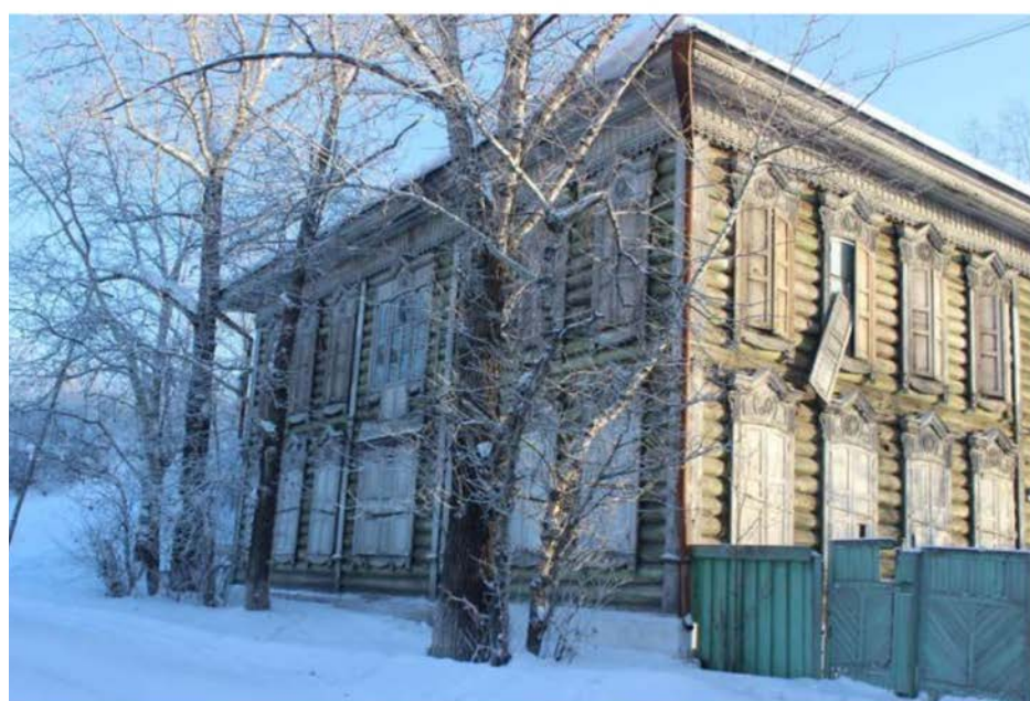
Фото 8. Главный (северный) фасад по адресу: г. Киренск, ул. Ленских Рабочих,31.
