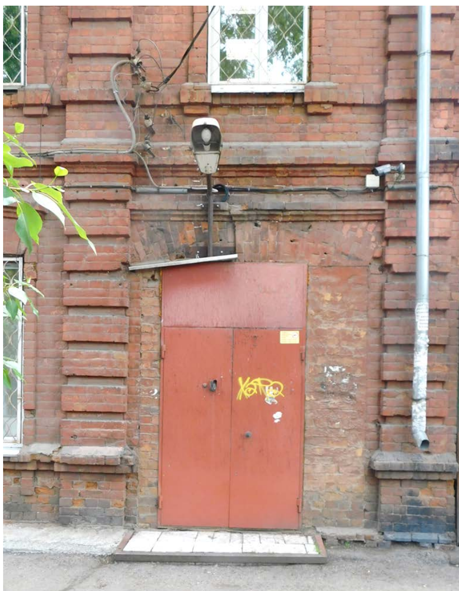
15. Главный, юго-западный фасад. Главный вход. Подоконный пояс.
