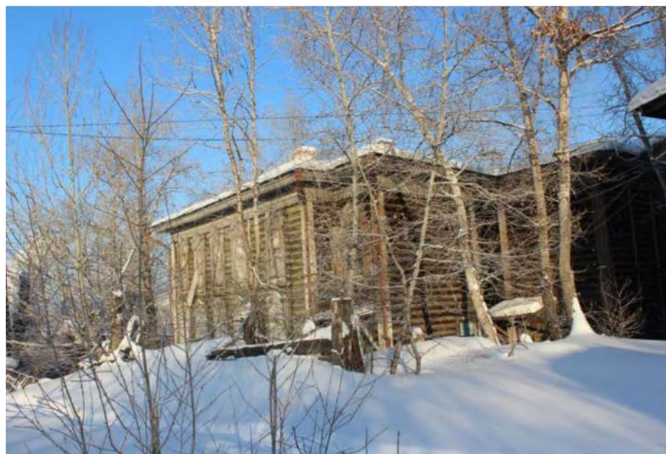
Фото 10. Дворовый (южный) фасад по адресу: г. Киренск, ул. Ленских Рабочих,31.
