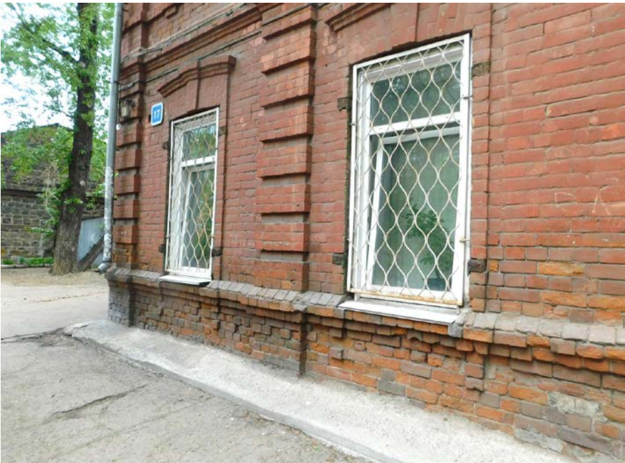
4. Главный, юго-западный фасад. Окно 1этажа. Наличник, сандрик, подоконный пояс.
