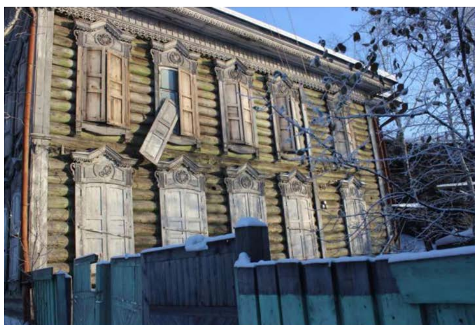
Фото 9. Боковой (западный) фасад по адресу: г. Киренск, ул. Ленских Рабочих,31.
