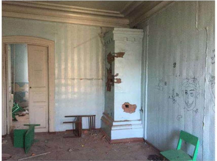
Фото 15. Интерьер. Филенчатые двери, профилированные потолочные тяги, печь. Адрес: г. Киренск, ул. Ленских Рабочих, 31.
