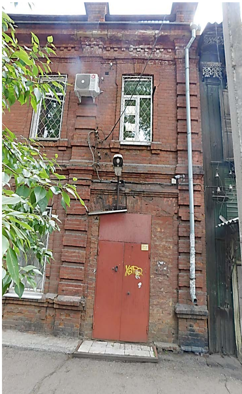
10.Главный, юго-западный фасад. Ризалит2.
