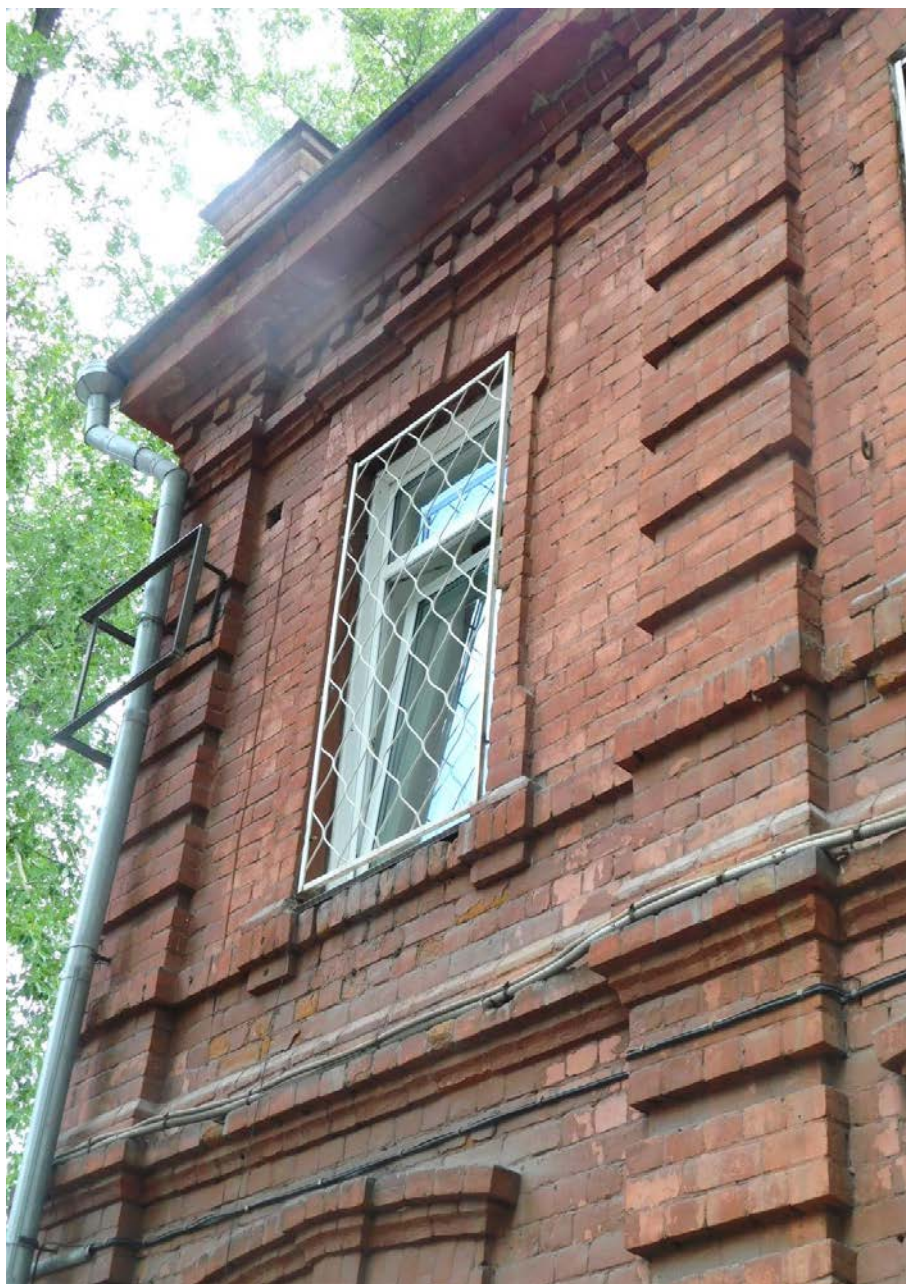
13. Главный, юго-западный фасад. Окно 2 этажа. Наличник, сандрик. Подоконный пояс.
