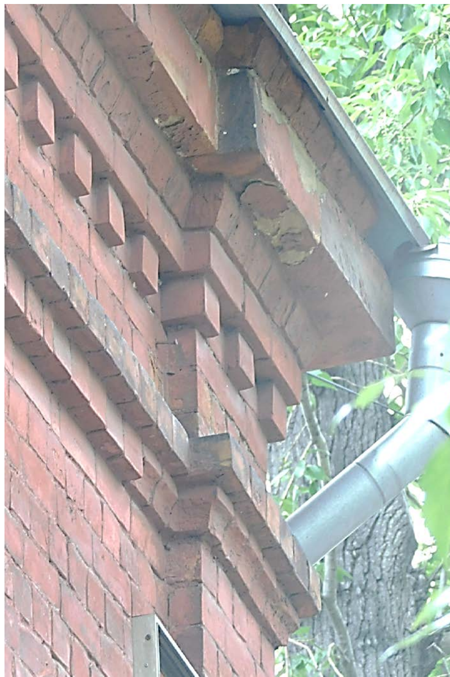
14. Боковой, юго-западный фасад. Карниз.
